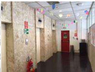
Hall de andar padrão (5º andar)
