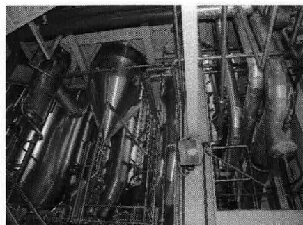
Silos de armazenamento de produtos processados
