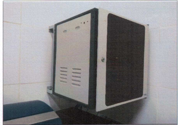
Equipamentos de Informática - Rack suspenso de informática
