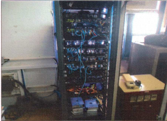
Equipamento de Informática Rack piso de informática
