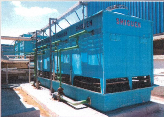
Máquinas e Equipamentos - Torre de resfriamento SHIGUEN
