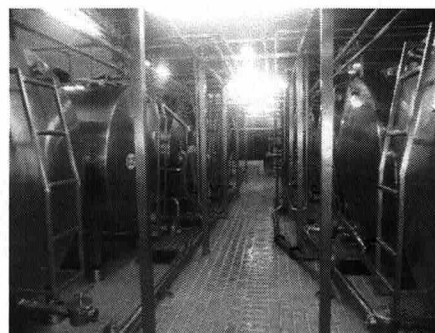
Tanques de processo
