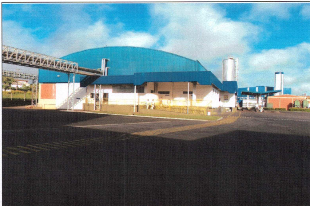
Vista externa – entrada da Fábrica – Cerqueira Cesar/SP
