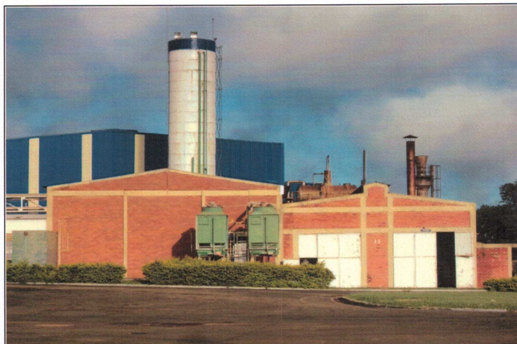
Vista externa – Casa dos geradores – Cerqueira Cesar/SP
