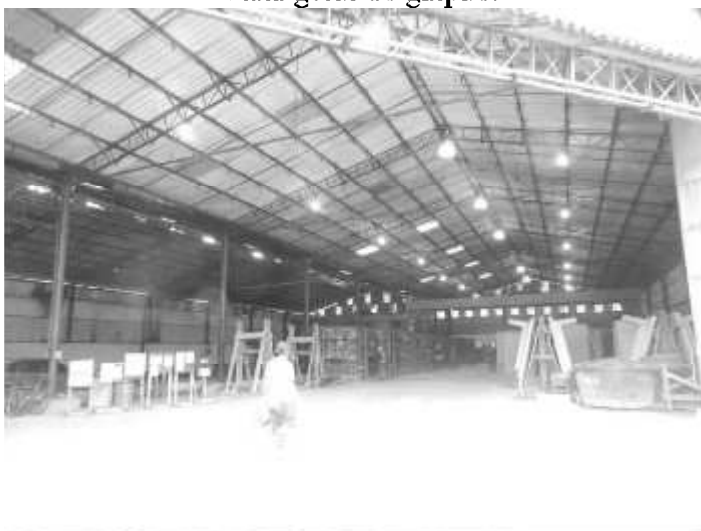
Vista geral do galpão.
