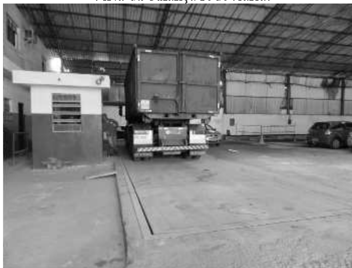
Vista da balança rodoviária.
