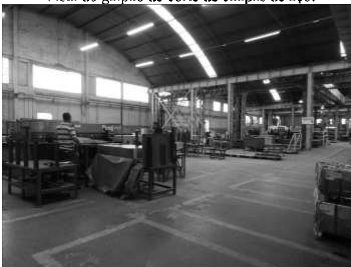
Vista do galpão de corte de chapas de aço.
