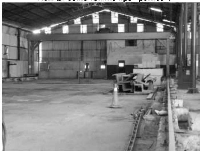
Vista da ponte-rolante tipo "pórtico".
