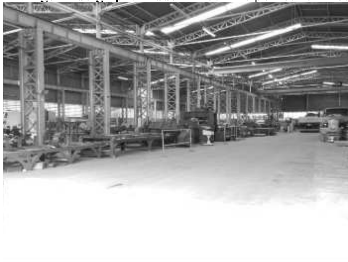
Vista geral do galpão industrial com as pontes rolantes.
