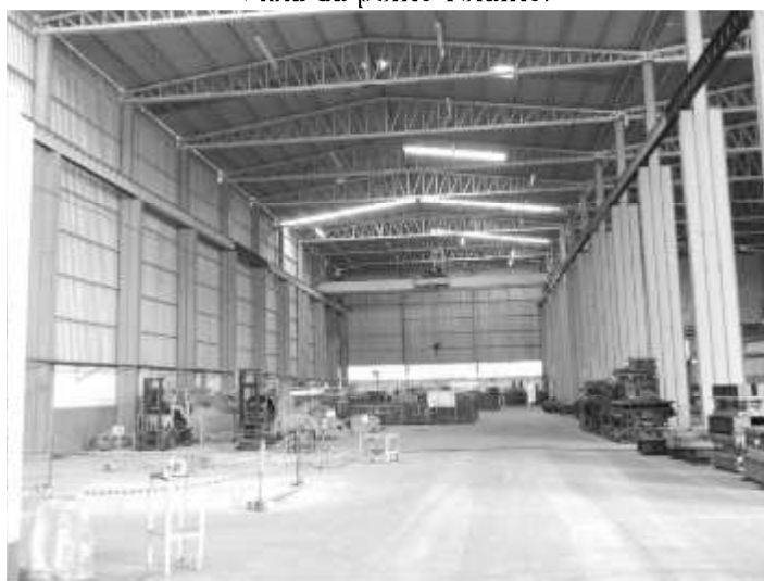
Vista da ponte-rolante.
