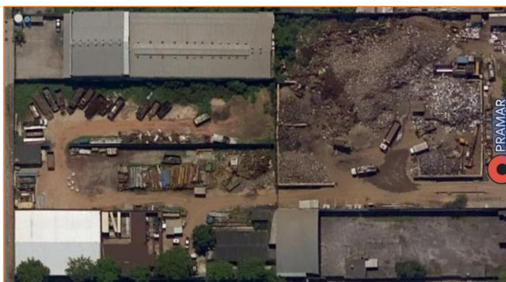
Vista aérea da sede do GRUPO PRAMAR em Duque de Caxias / RJ
