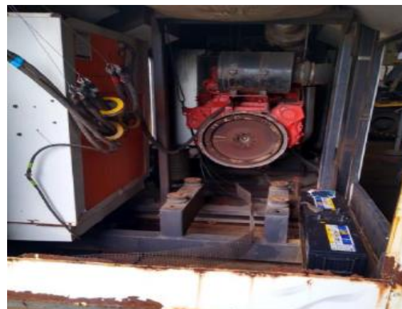
4) Manutenção no gerador e reparo nos pontos de oxidação ZPMC 02
