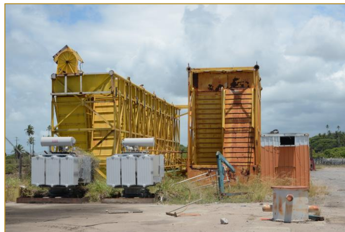
Escada de Acesso ao Navio
