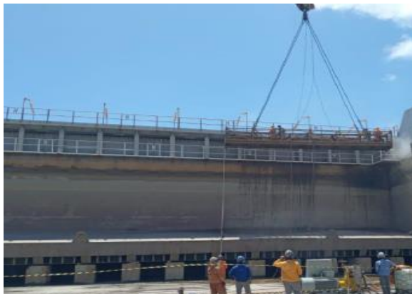
1) Tratamento e pintura da porta batel
