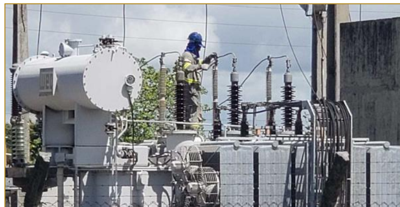
Manutenção da subestação principal 69kv
