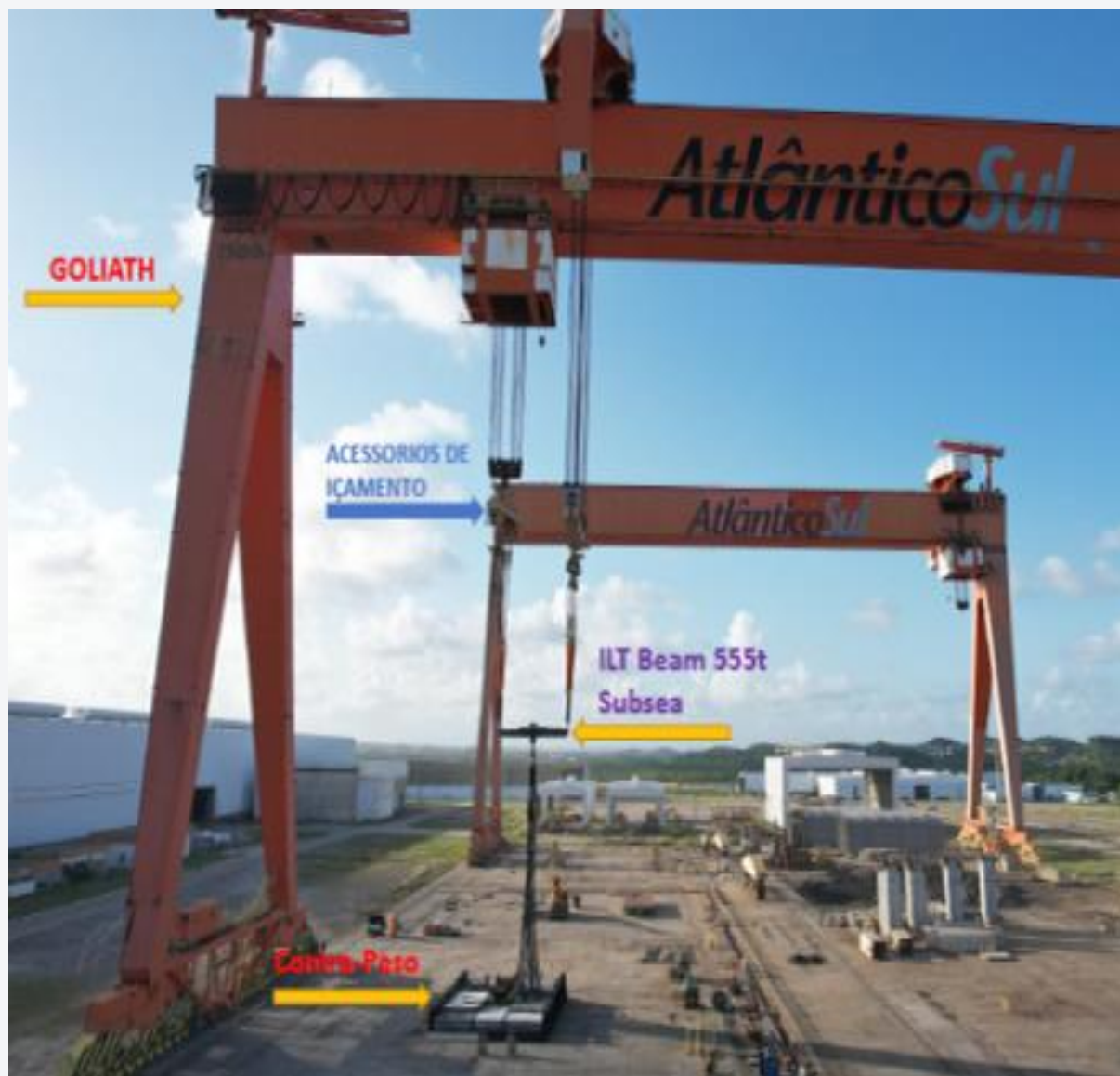
Estrutura metálica ILT BEAM - Subsea
