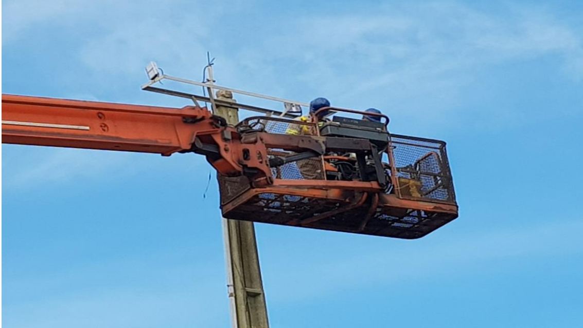
Manutenção Iluminação Externa
