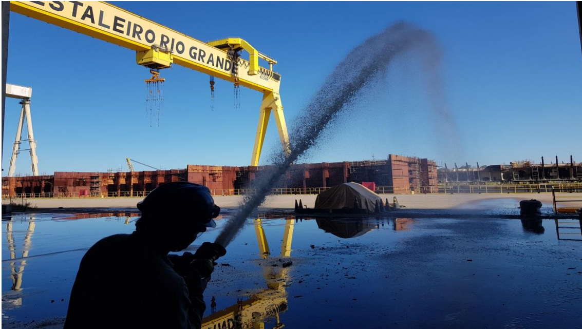
Teste de Combate a Incêndio
