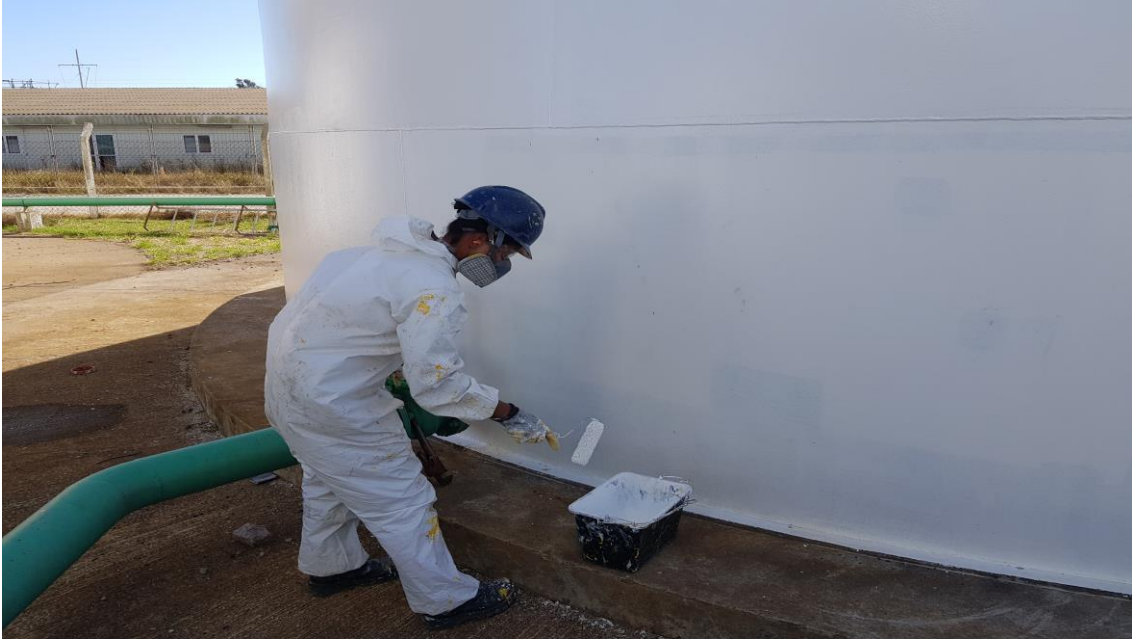
Pintura tanque água potável
