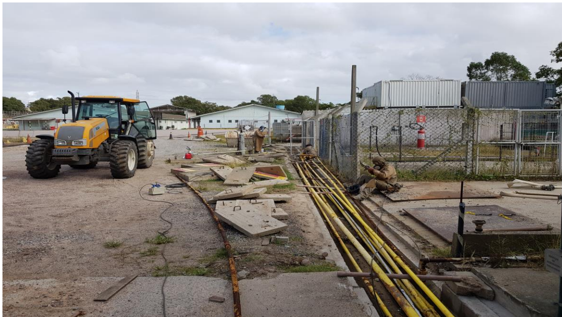
Manutenção rede de gases
