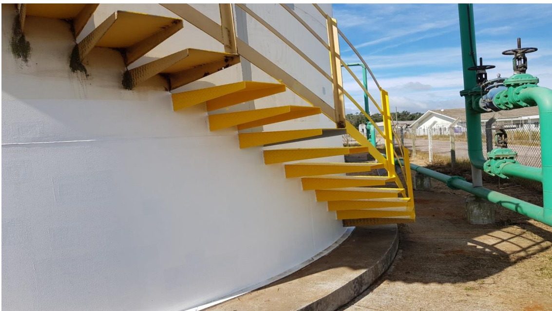
Tratamento e Pintura Tanque de Água Potável
