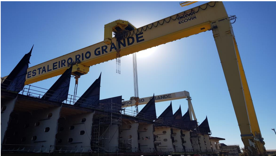
Lubrificação Pórtico 2.000 ton
