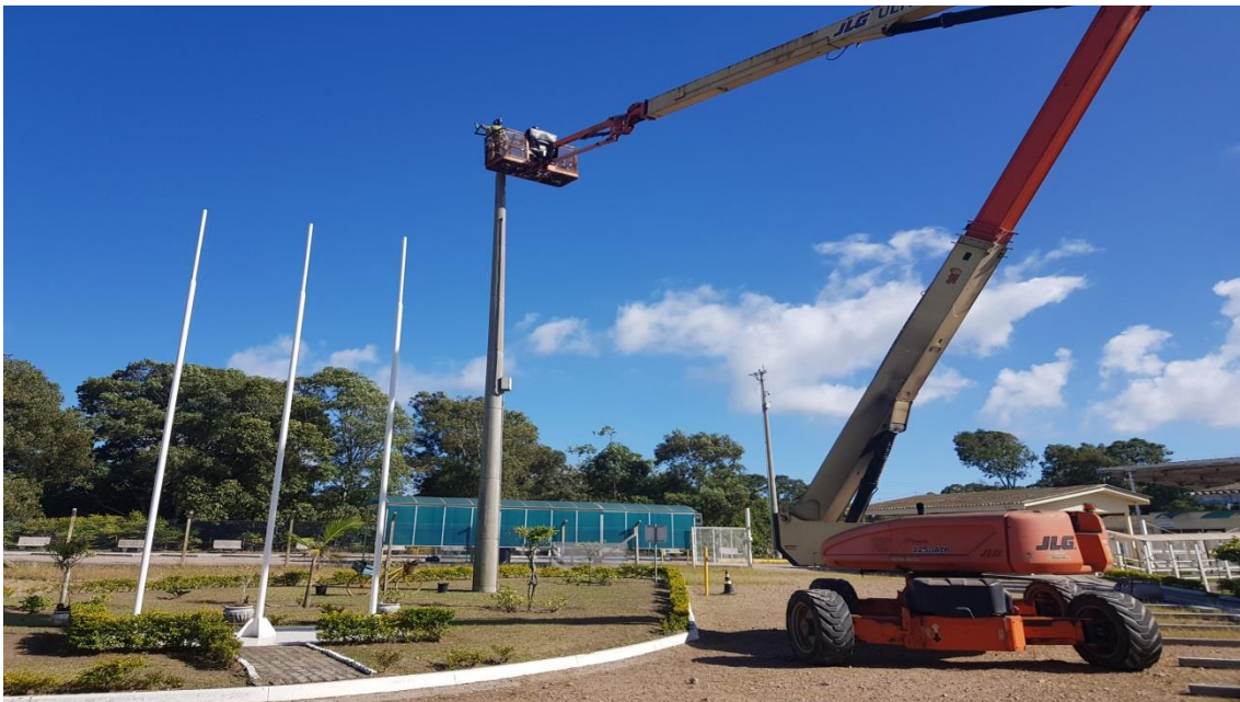
Melhoria iluminação externa
