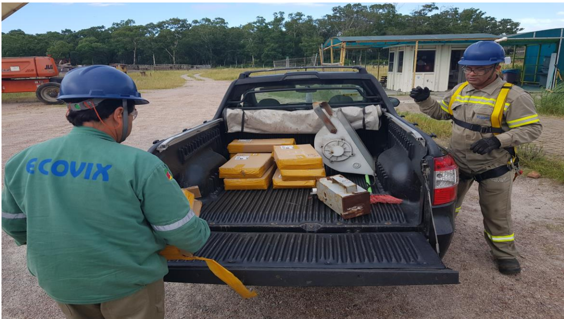
Manutenção Iluminação Externa
