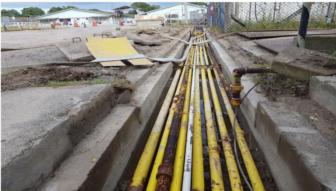
Manutenção Rede de Gases
