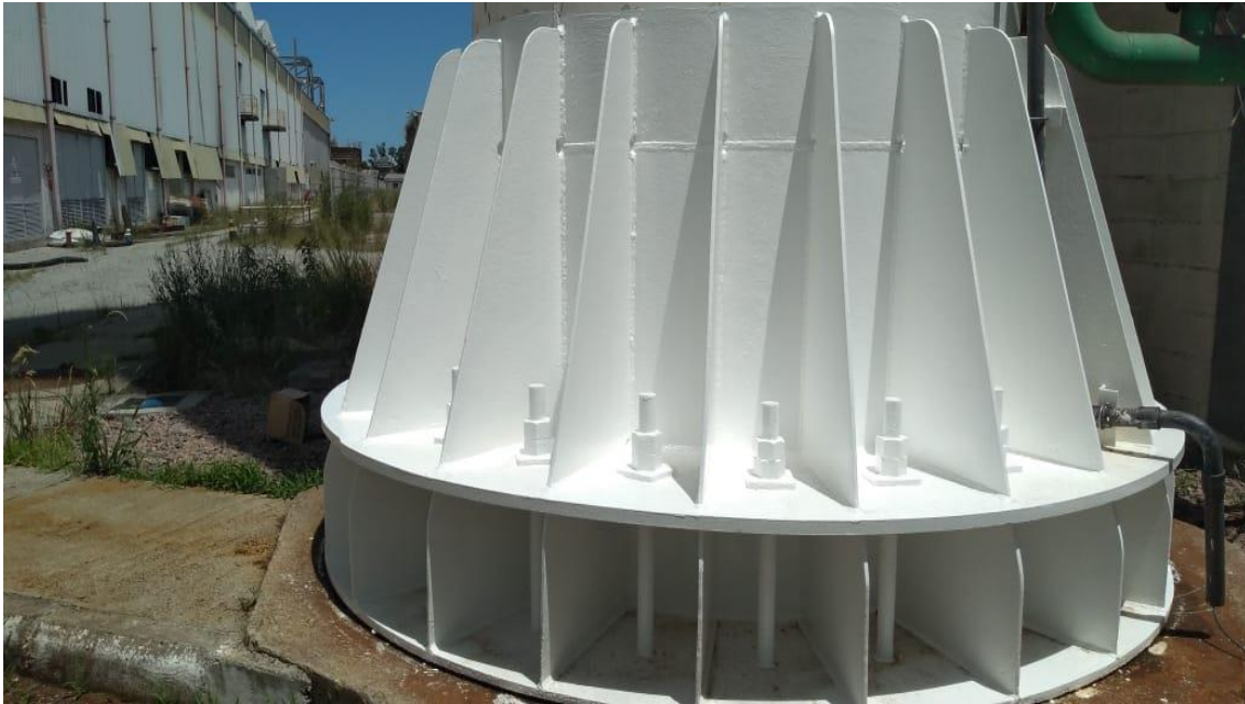
Tratamento e Pintura Taça de Água Potável – Base Fixação
