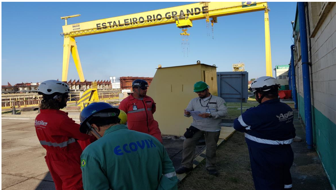
Alpinismo – tratamento e pintura Pórtico 600 ton
