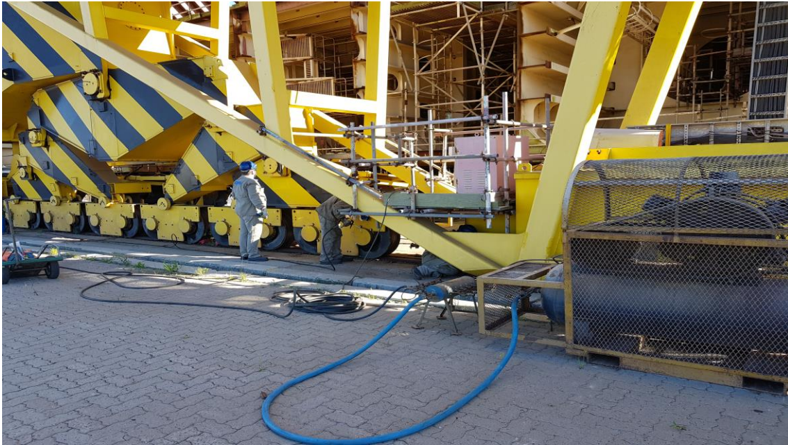
Lubrificação Pórtico 2.000 ton
