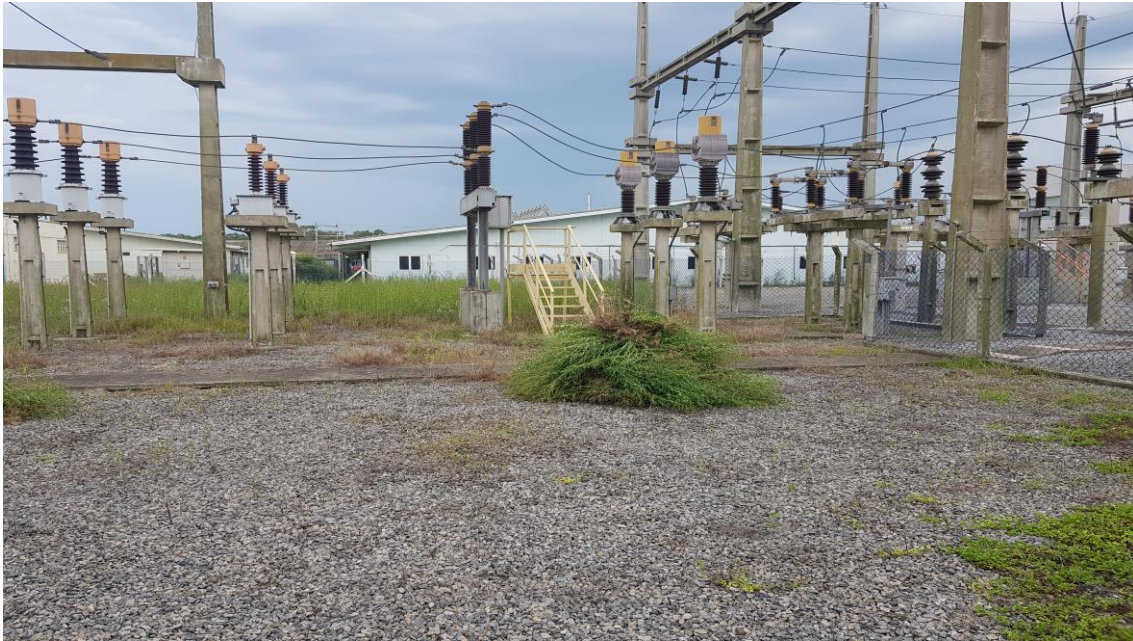
Manutenção Subestação – Capina
