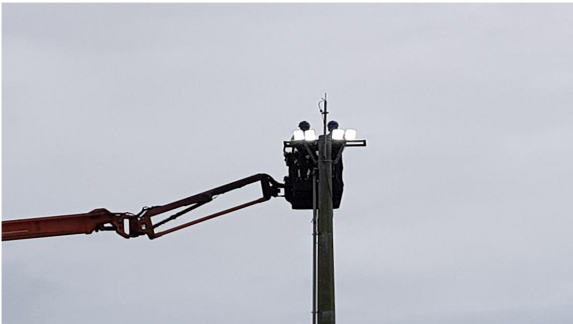
Manutenção Iluminação Externa
