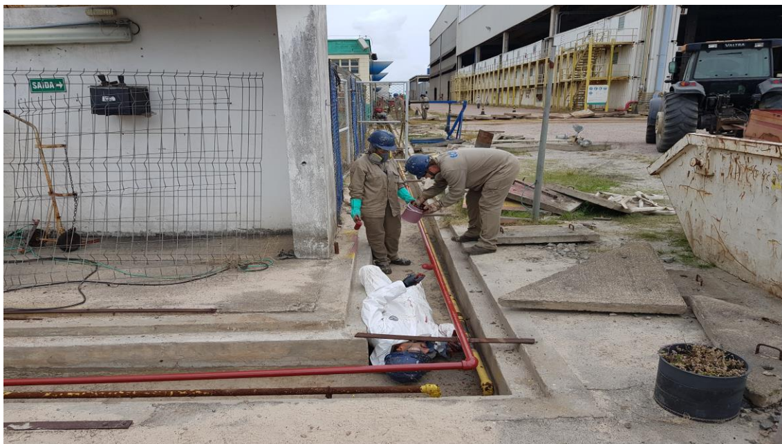
Manutenção rede de gases
