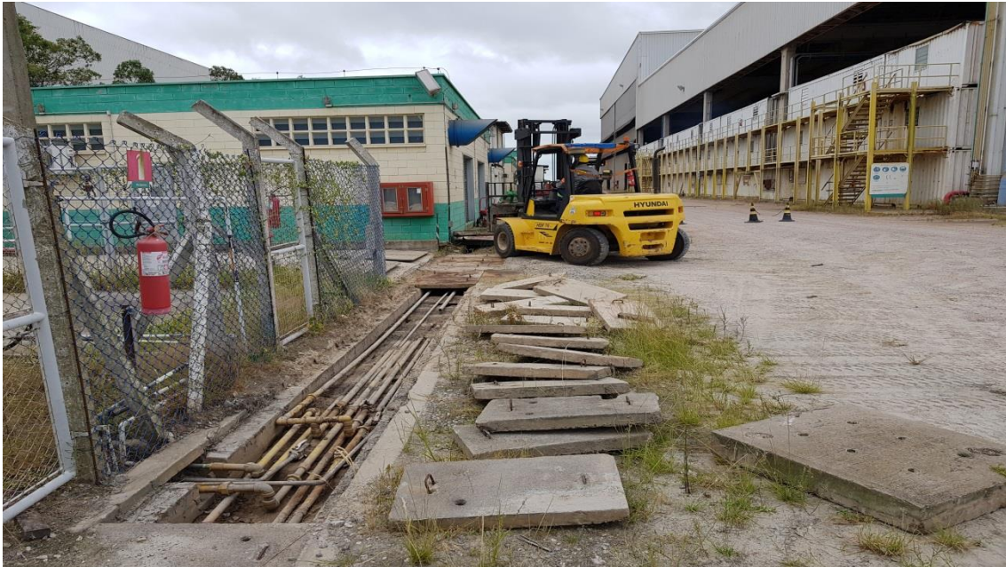
Manutenção Rede de Gases
