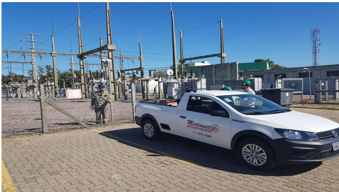
Manutenção Subestação – Capina Química – Aplicação
