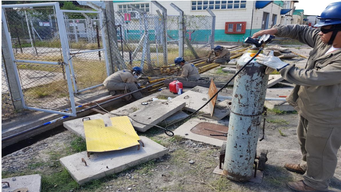
Manutenção rede de gases
