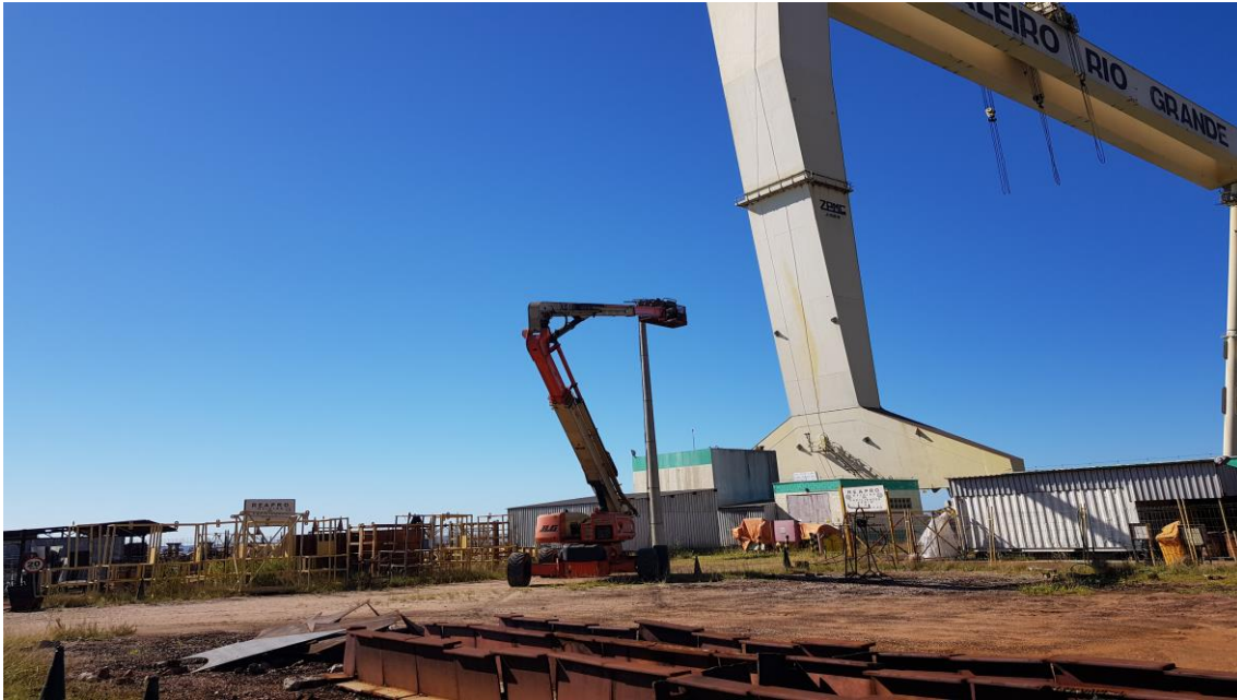
Manutenção Iluminação Externa
