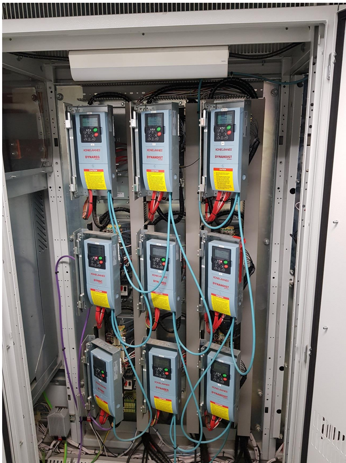
Manutenção Pórtico 2000 ton
