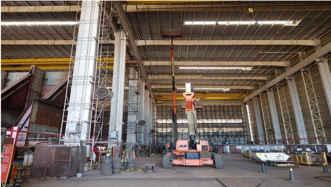
Manutenção Plataforma de Trabalho Aéreo
