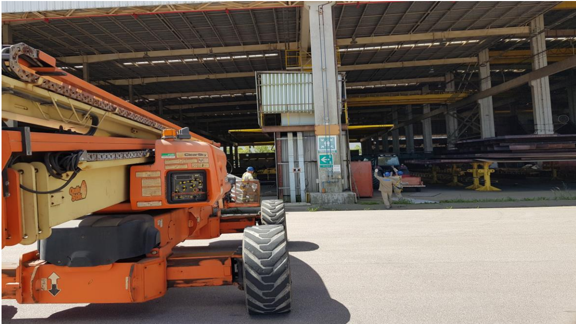
Manutenção Estruturas Subestação Oficinas
