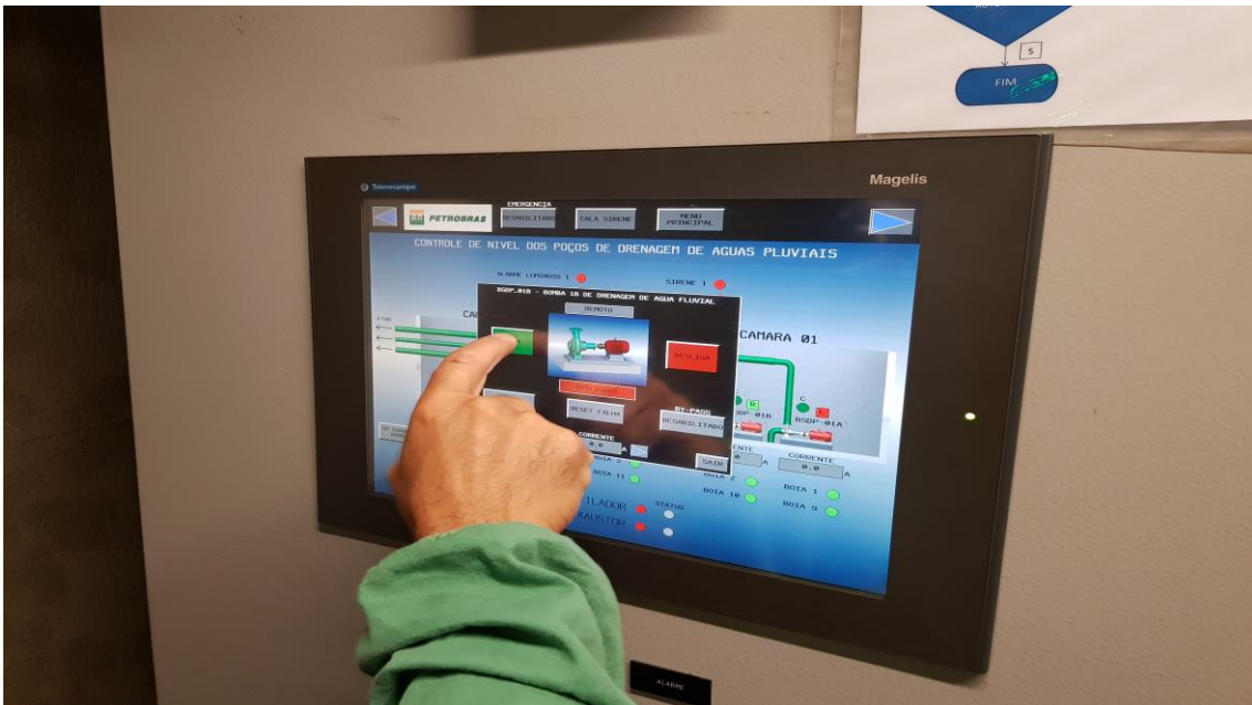
Manutenção drenagem do dique
