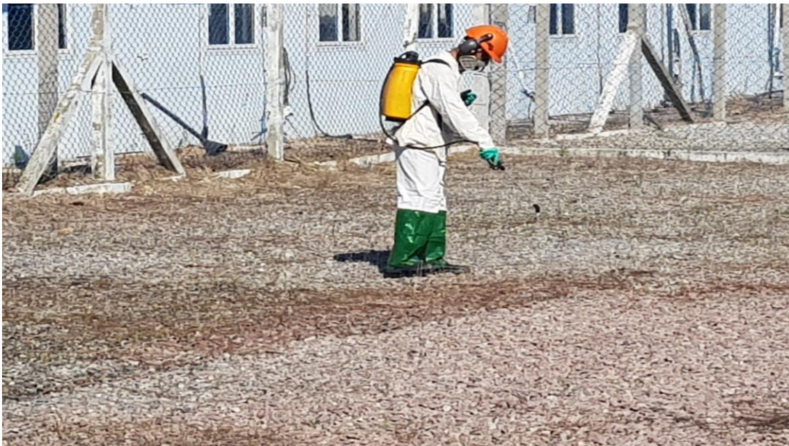
Manutenção Subestação – Capina Química – Aplicação
