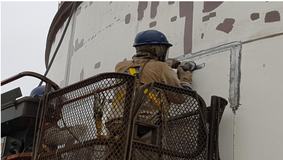
Tanque B – Água Potável – Tratamento e Pintura
