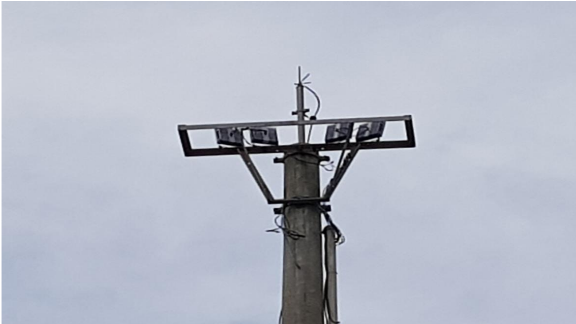
Manutenção Iluminação Externa
