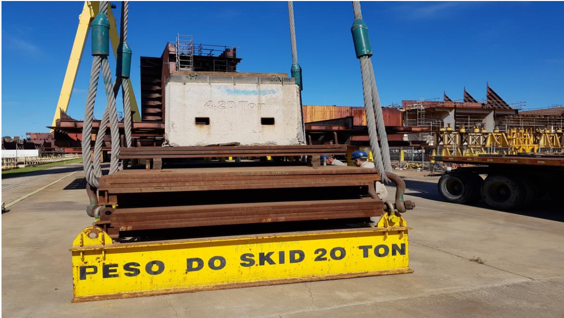
Manutenção e testes Pórtico 2000 ton
