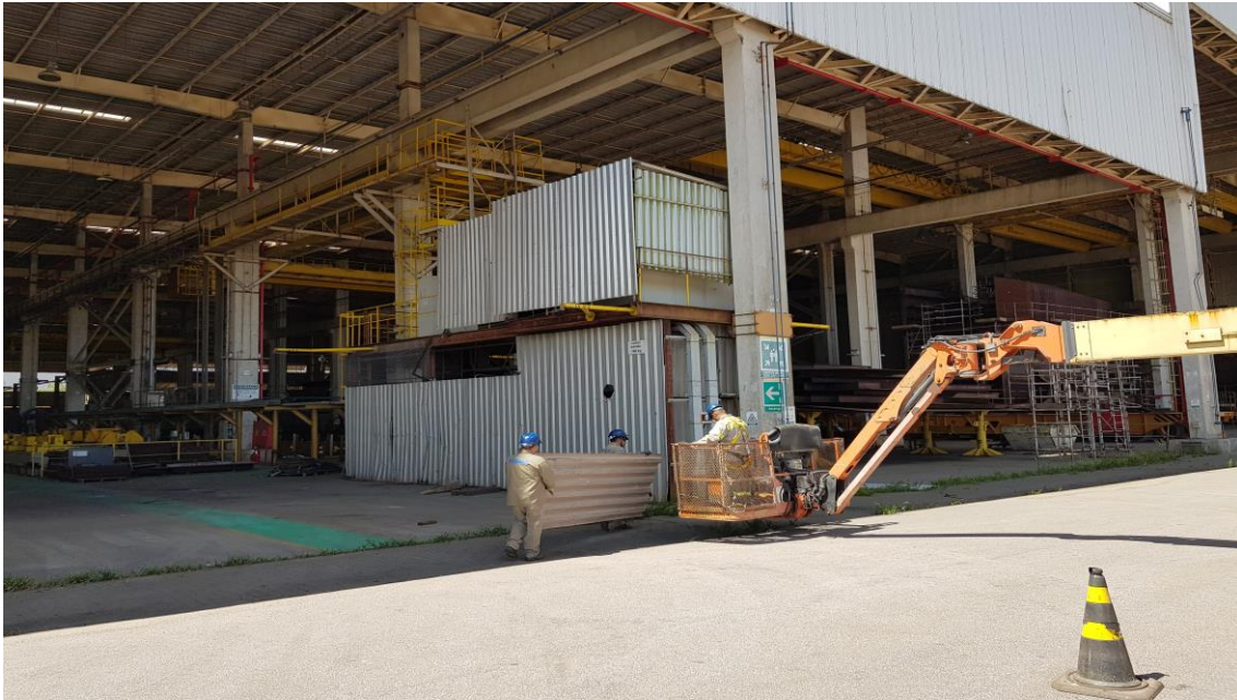
Manutenção Estruturas Subestação Oficinas
