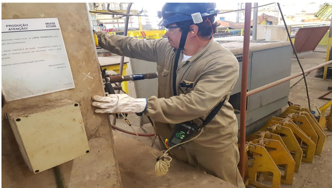
Manutenção rede de gases
