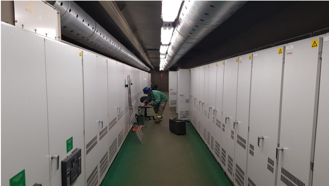
Manutenção Pórtico 2000 ton
