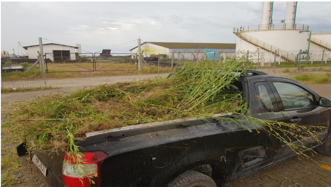
Manutenção Subestação – Capina
