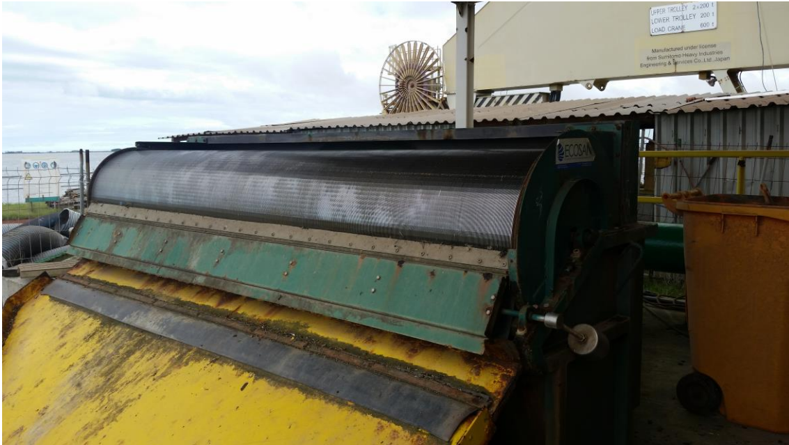
Manutenção ETAR – Estação de de Tratamento de Água
