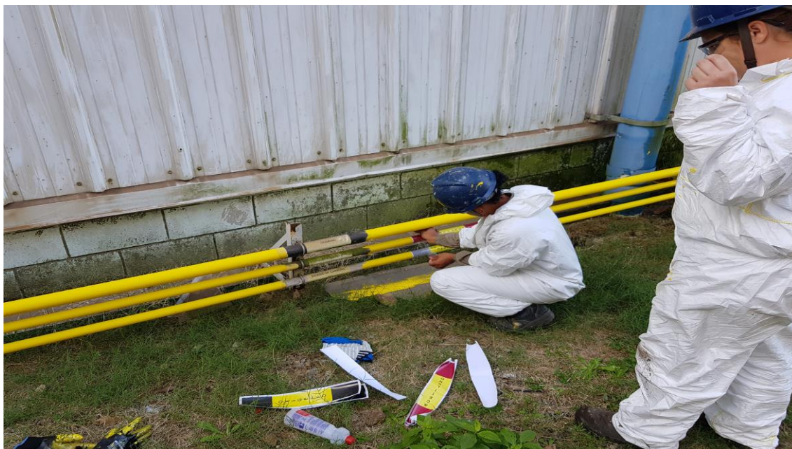
Manutenção rede de gases
