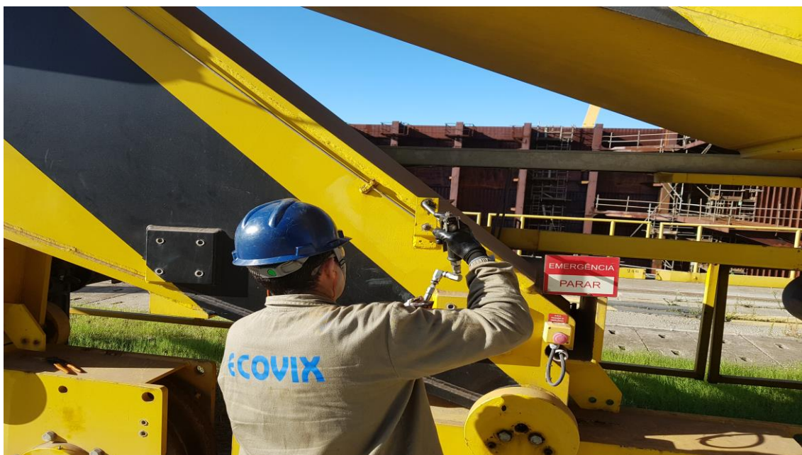
Lubrificação Pórtico 2.000 ton
