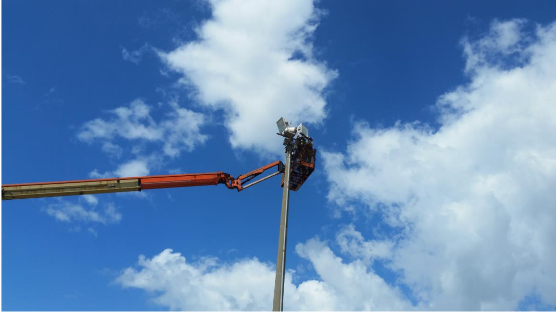
Manutenção Iluminação Externa
