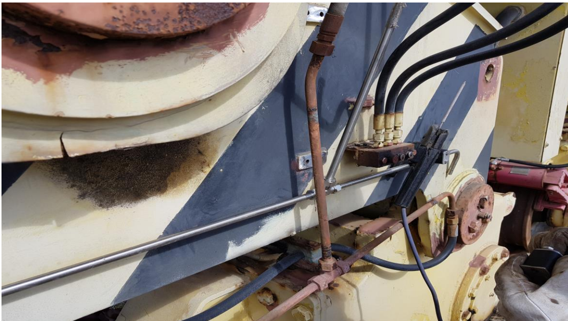
Manutenção sistema hidráulico Pórtico de 600 ton
