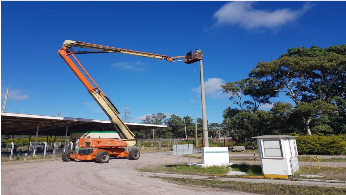
Melhoria iluminação externa
