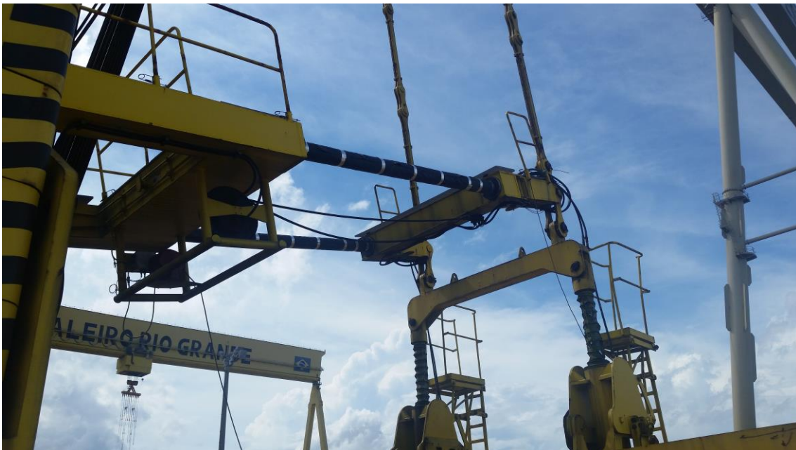
Manutenção Guindaste Sany 750 ton
