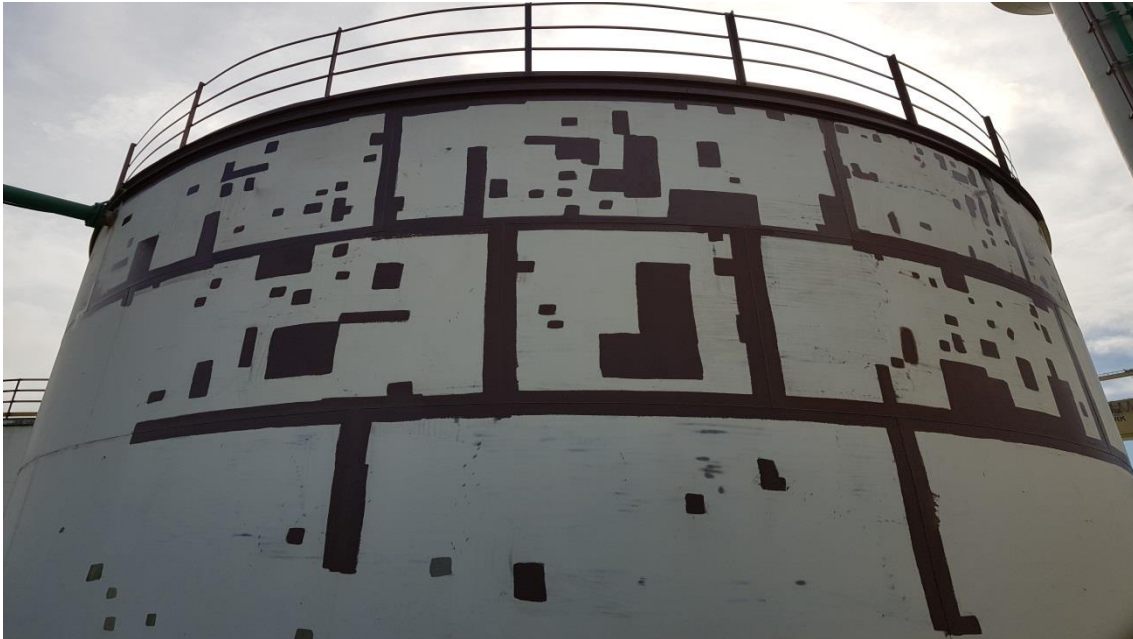
Tratamento e Pintura Tanque de Água Potável
