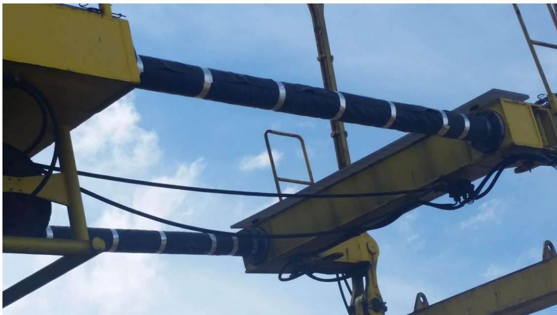
Manutenção Guindaste Sany 750 ton
