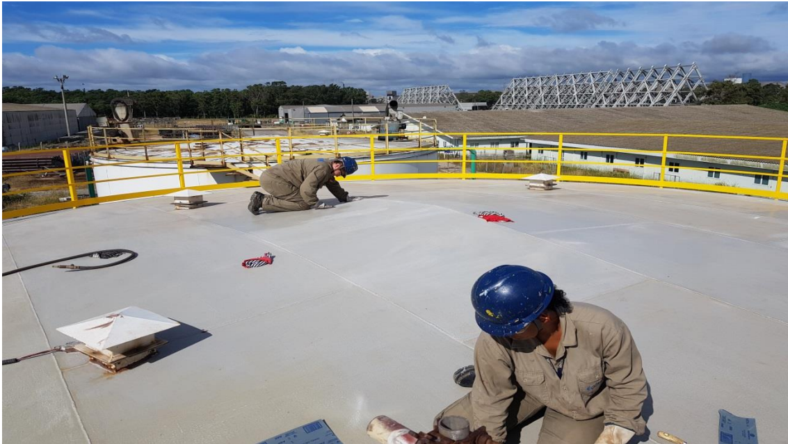
Tratamento e Pintura Tanque de Água Potável
