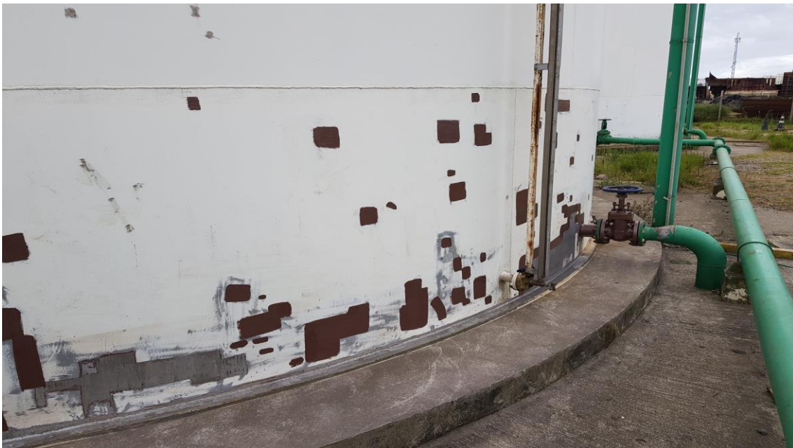
Tanque B – Água Potável – Tratamento e Pintura
