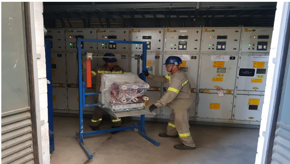
Manutenção em Subestações
