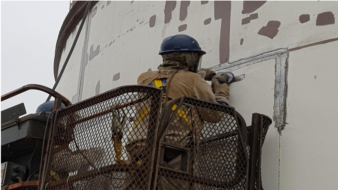
Tratamento e Pintura Tanque de Água Potável
