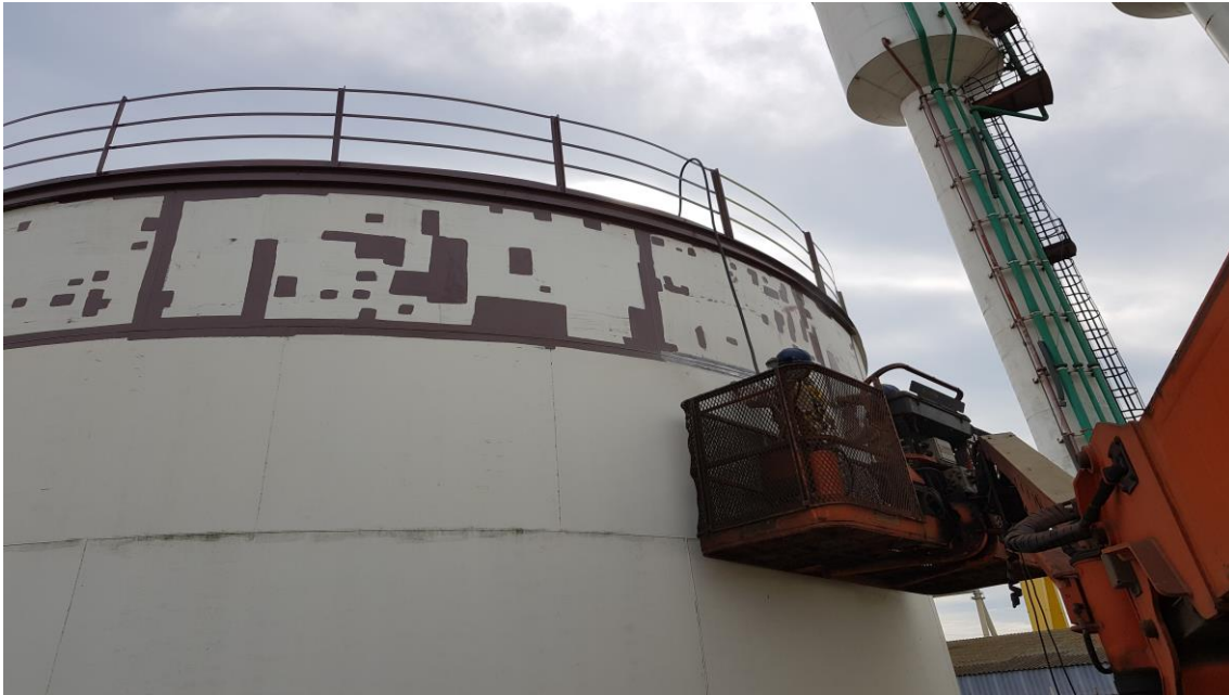
Tanque B – Água Potável – Tratamento e Pintura
