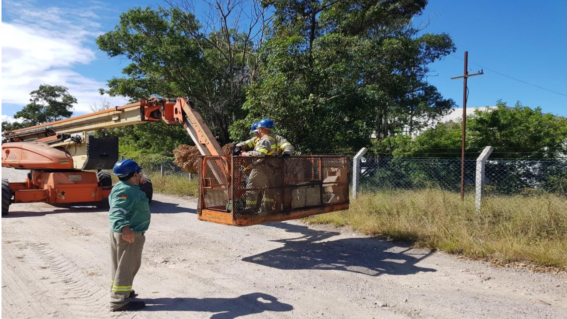
Melhoria iluminação externa
