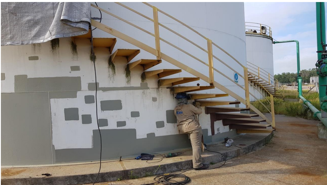
Tratamento e Pintura Tanque de Água Potável
