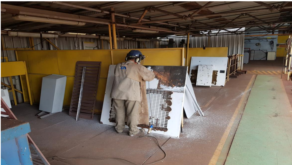
Pintura peças gerador de emergência
