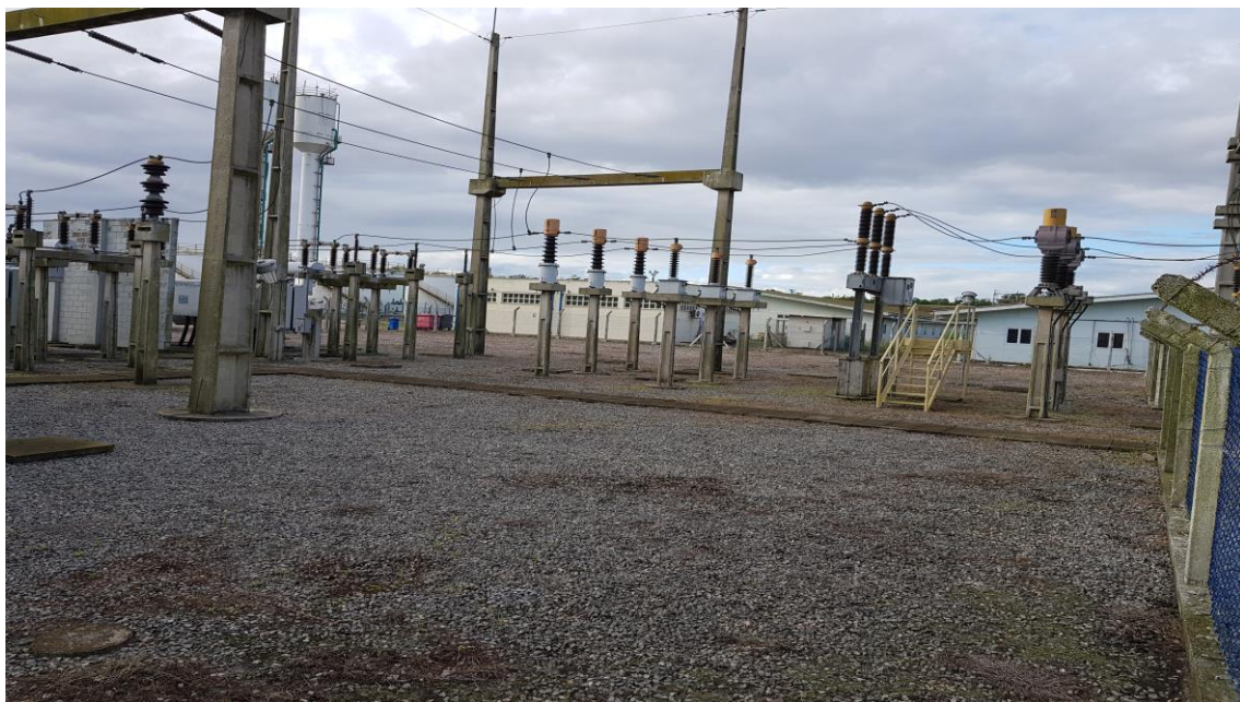
Manutenção Subestação – Capina executada
