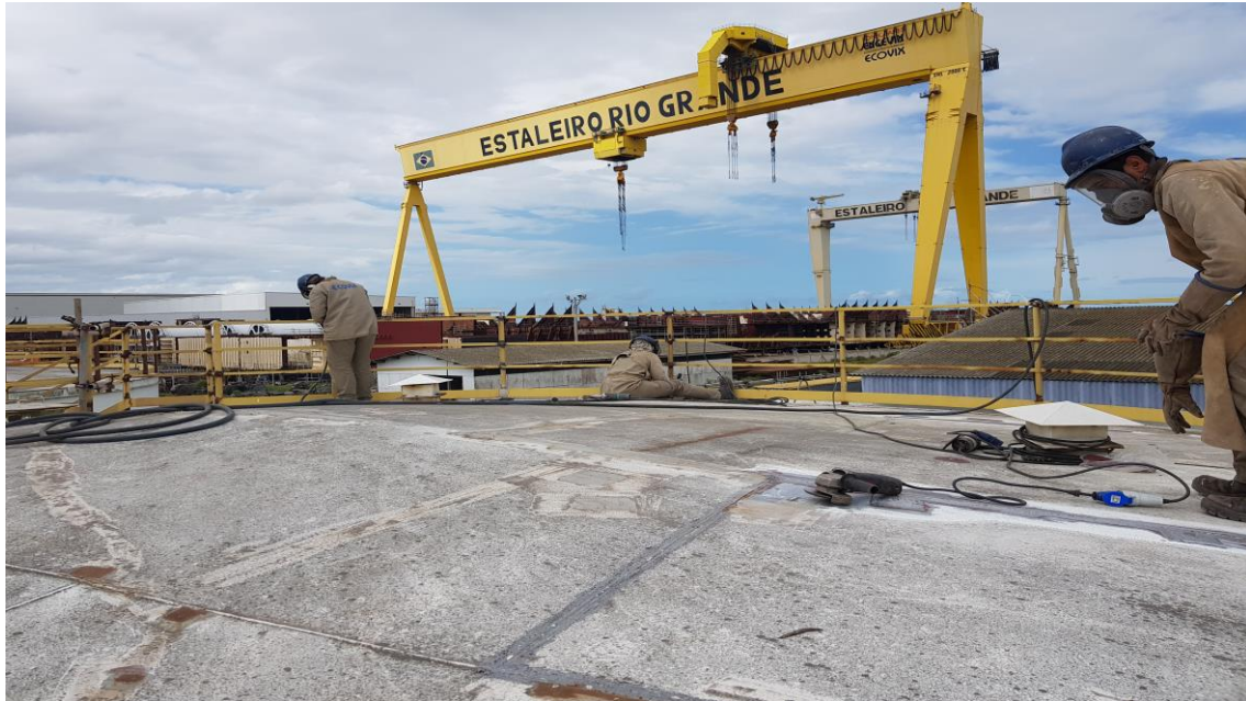
Tanque B – Água Potável – Tratamento e Pintura
