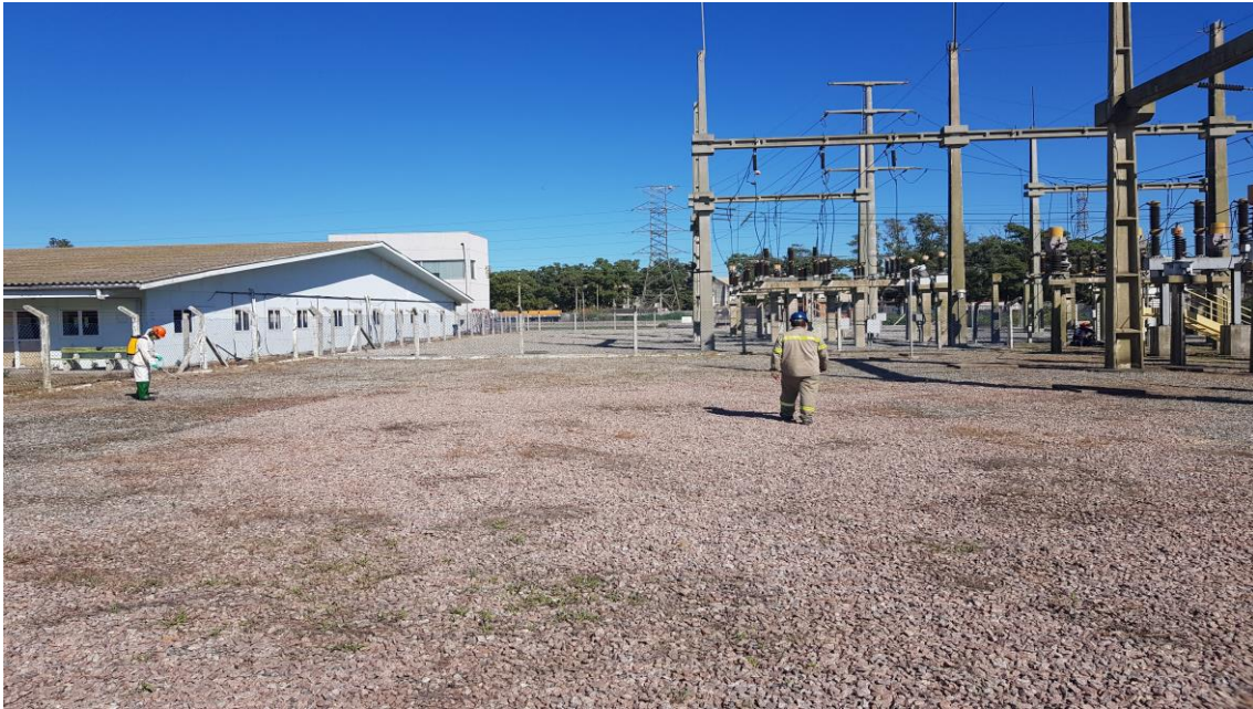
Manutenção Subestação – Capina Química – Aplicação
