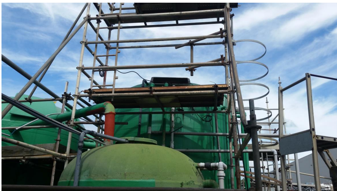
Manutenção Sistema da ETE – Estação Tratamento de Esgoto
