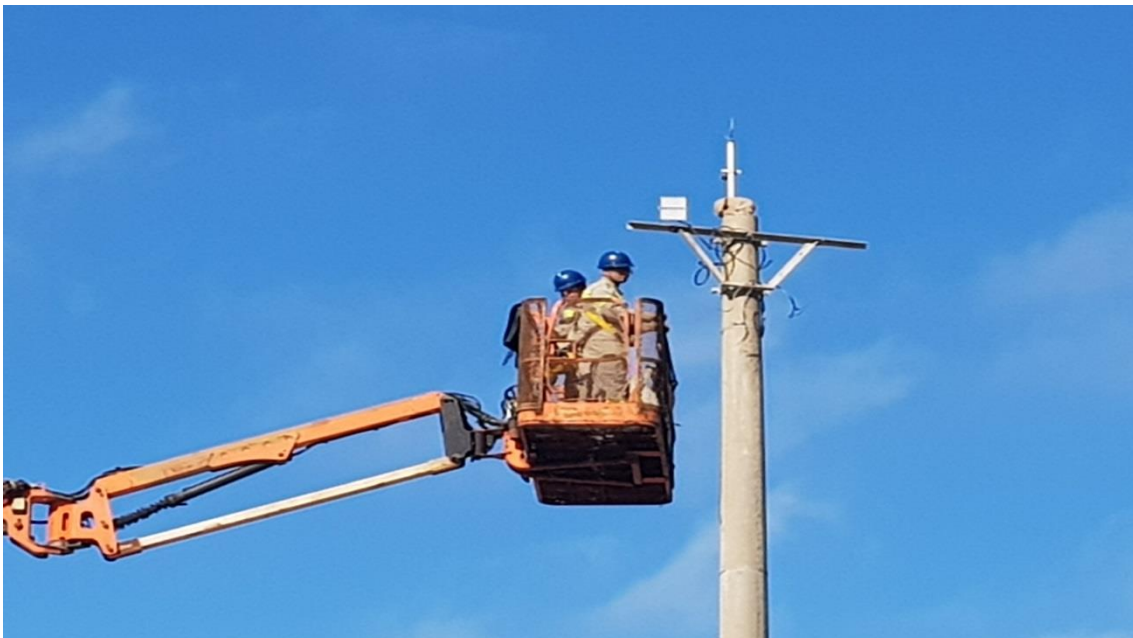
Melhoria iluminação externa
