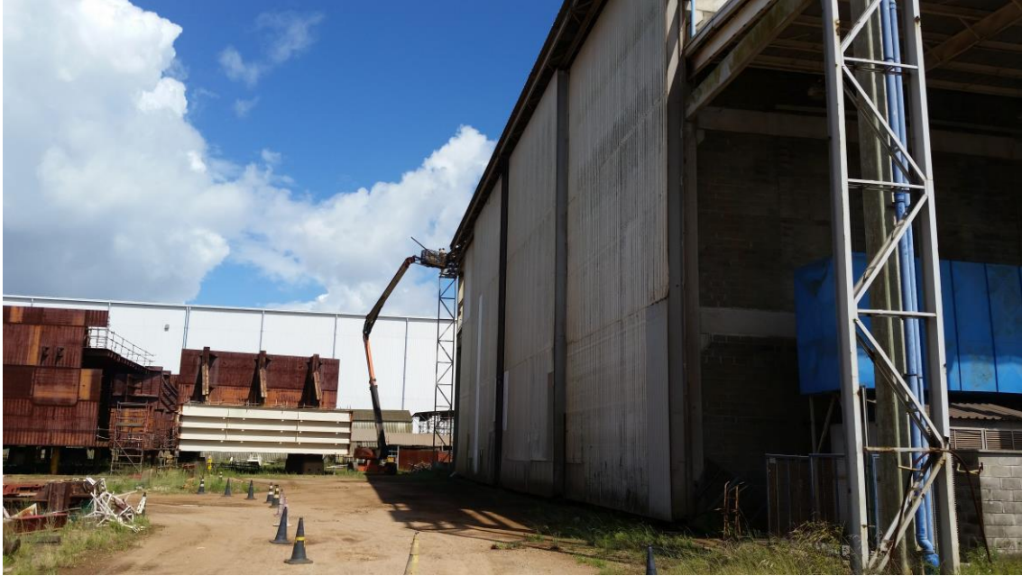
Manutenção Estruturas Cabine Jato Seco
