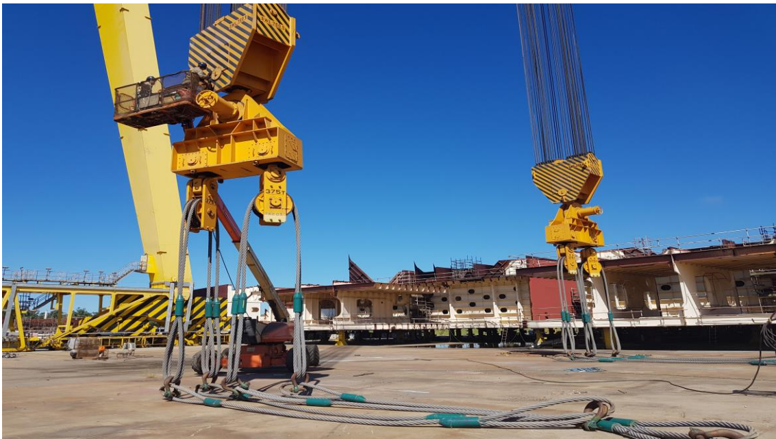
Lubrificação Pórtico 2.000 ton
