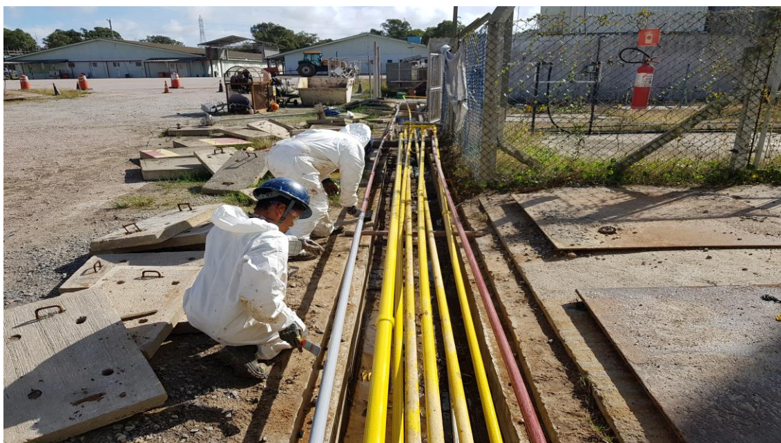
Manutenção rede de gases
