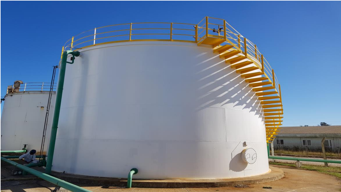
Pintura tanque água potável
