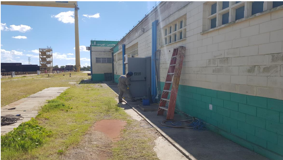
Manutenção Subestações – Portas e Fechaduras
