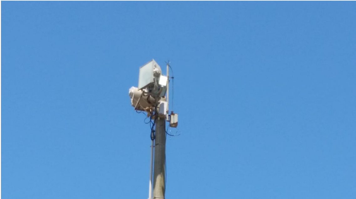
Manutenção Iluminação Externa
