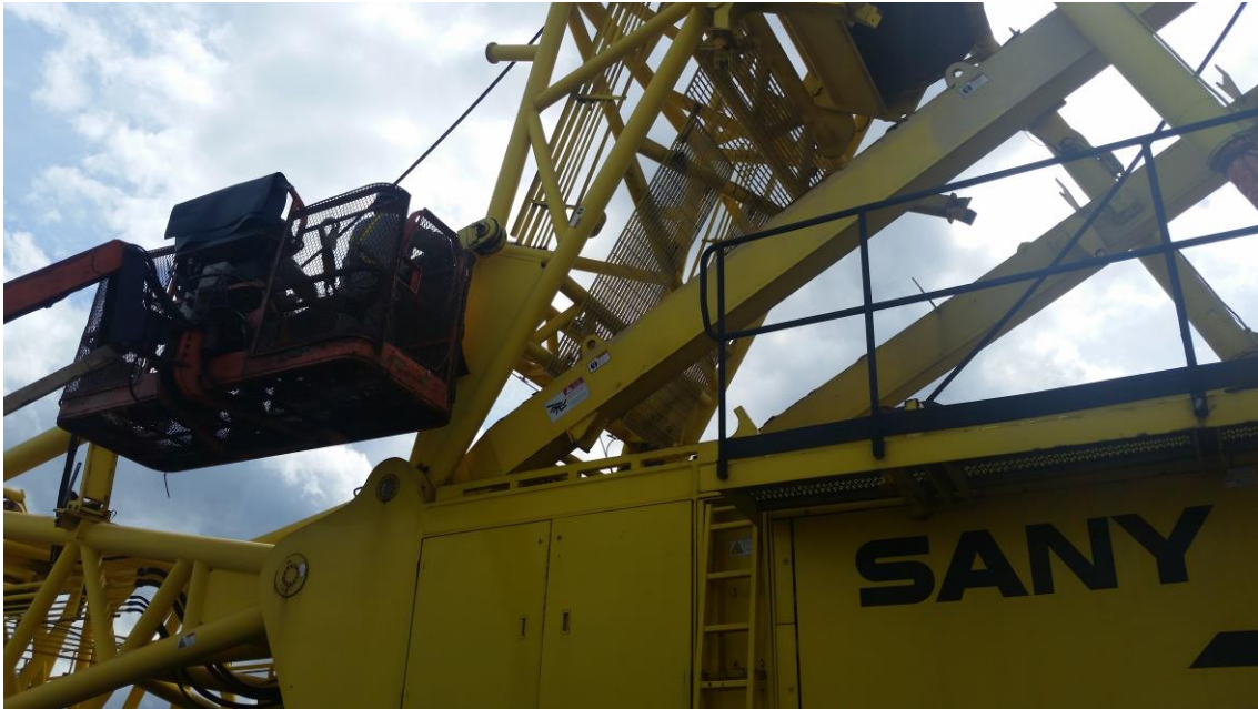
Manutenção Guindaste Sany 750 ton
