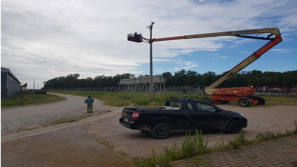
Manutenção Iluminação Externa
