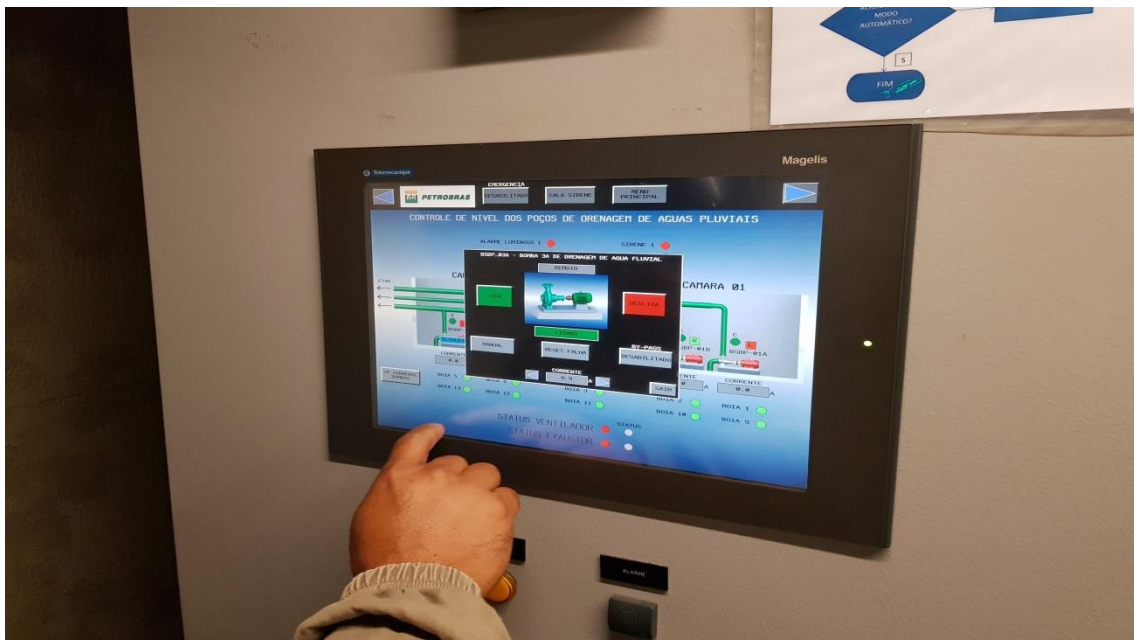
Manutenção Sistema Casa de Bomba do Dique
