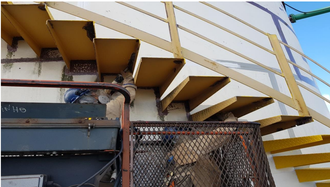
Tratamento e Pintura Tanque de Água Potável
