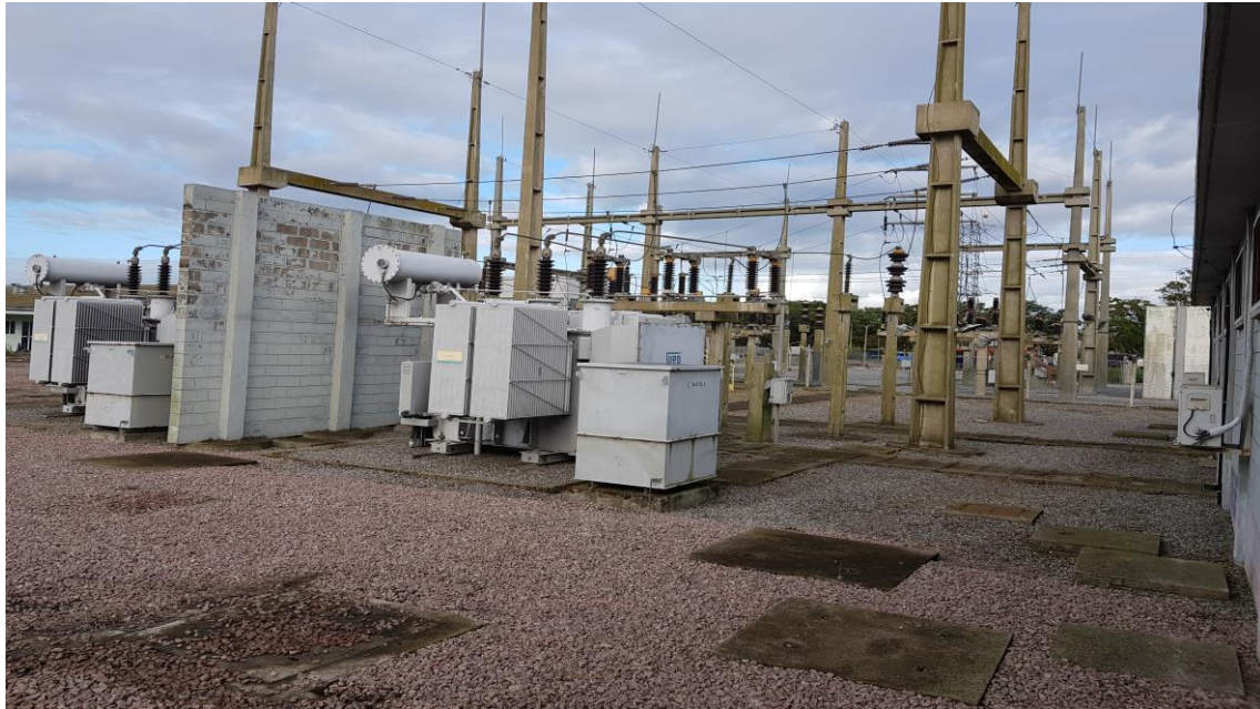
Manutenção Subestação – Capina executada
