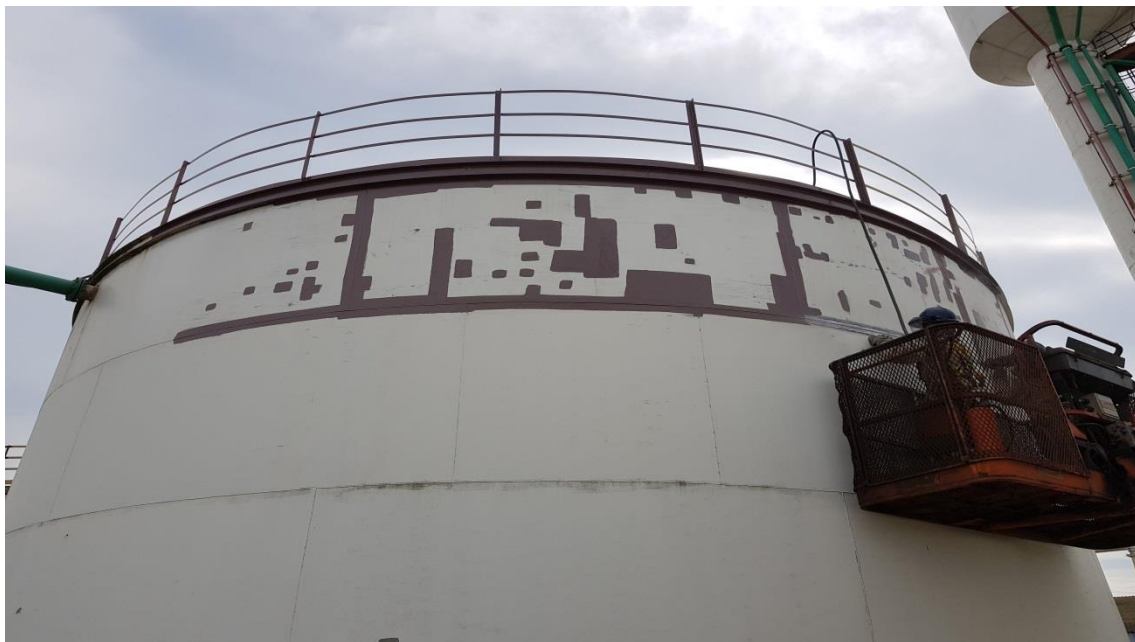
Tratamento e Pintura Tanque de Água Potável
