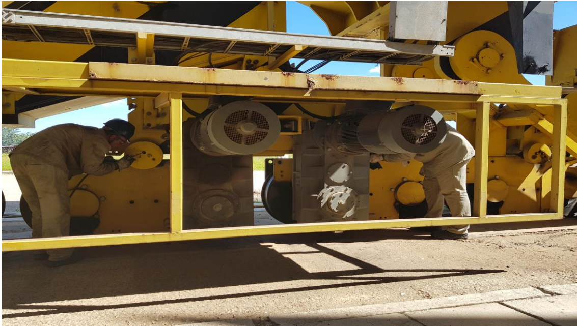
Lubrificação Pórtico 2.000 ton
