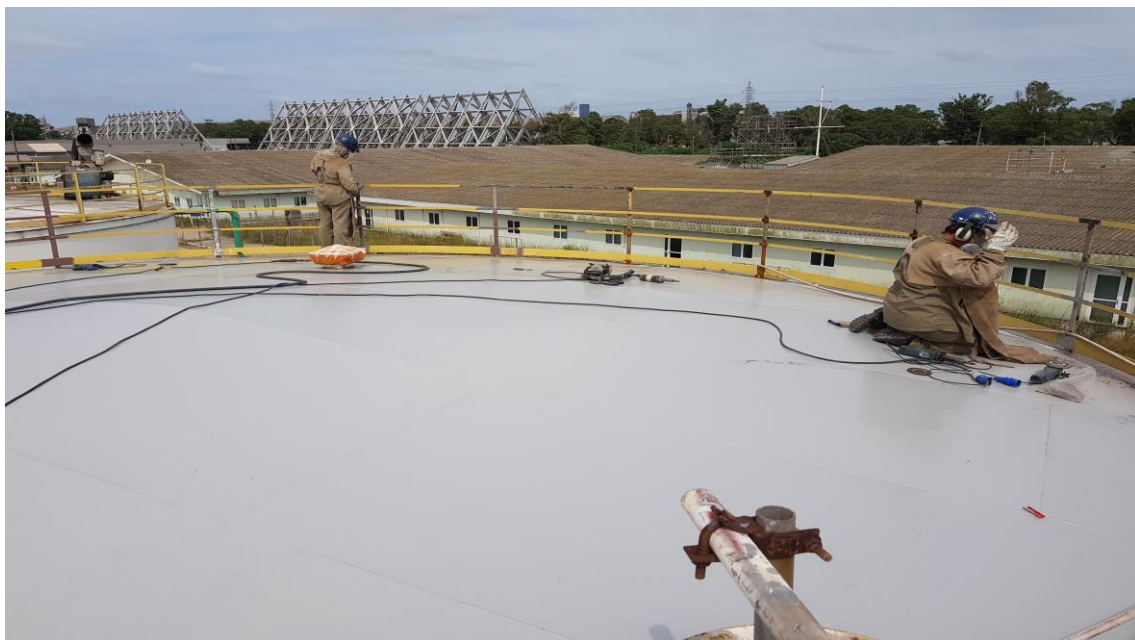
Tanque B – Água Potável – Tratamento e Pintura
