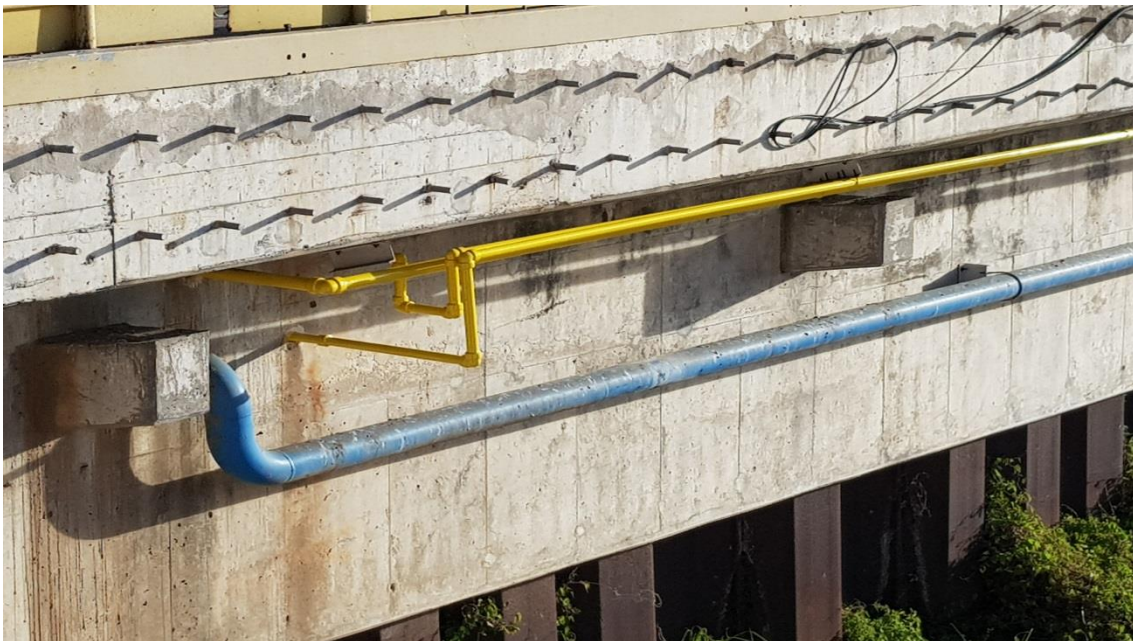
Tratamento e Pintura Tubulação de Gases
