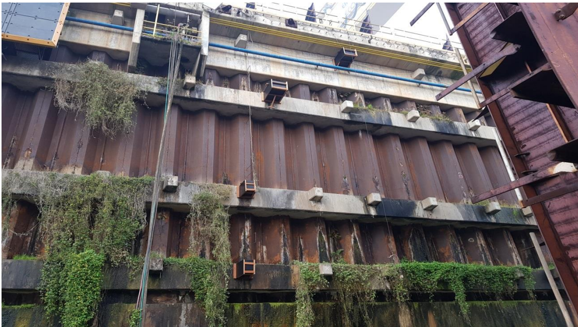
Manutenção Dique – Fechamento Cabeças dos Tirantes
