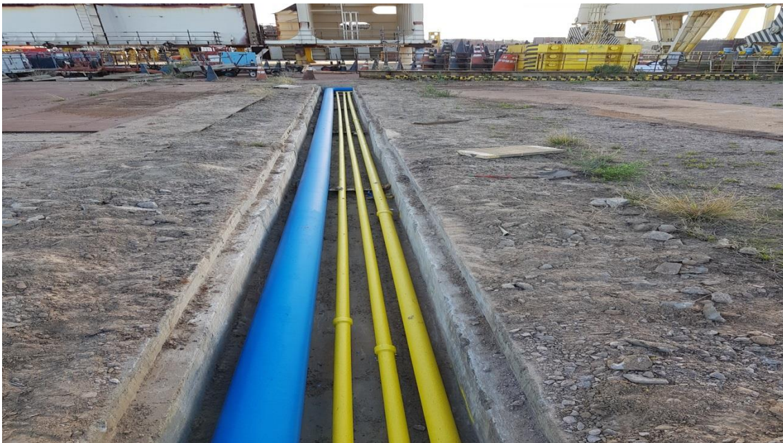
Tratamento e Pintura Tubulação de Gases
