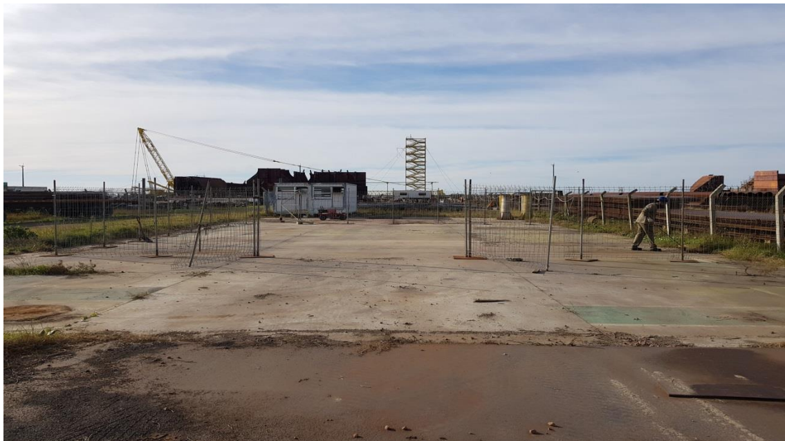
Central de Armazenamento de Cilindros
