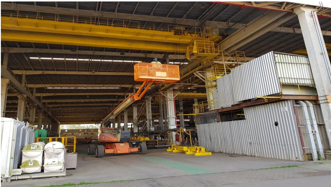
Manutenção Rede de Gases – Testes
