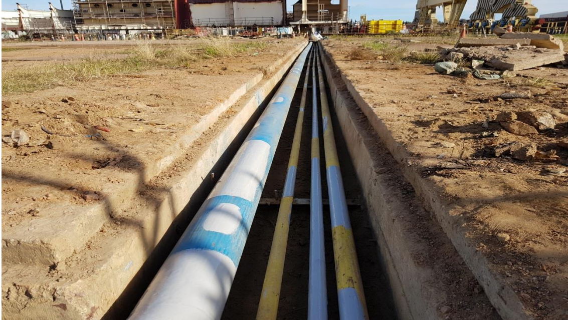
Tratamento e Pintura Tubulação de Gases
