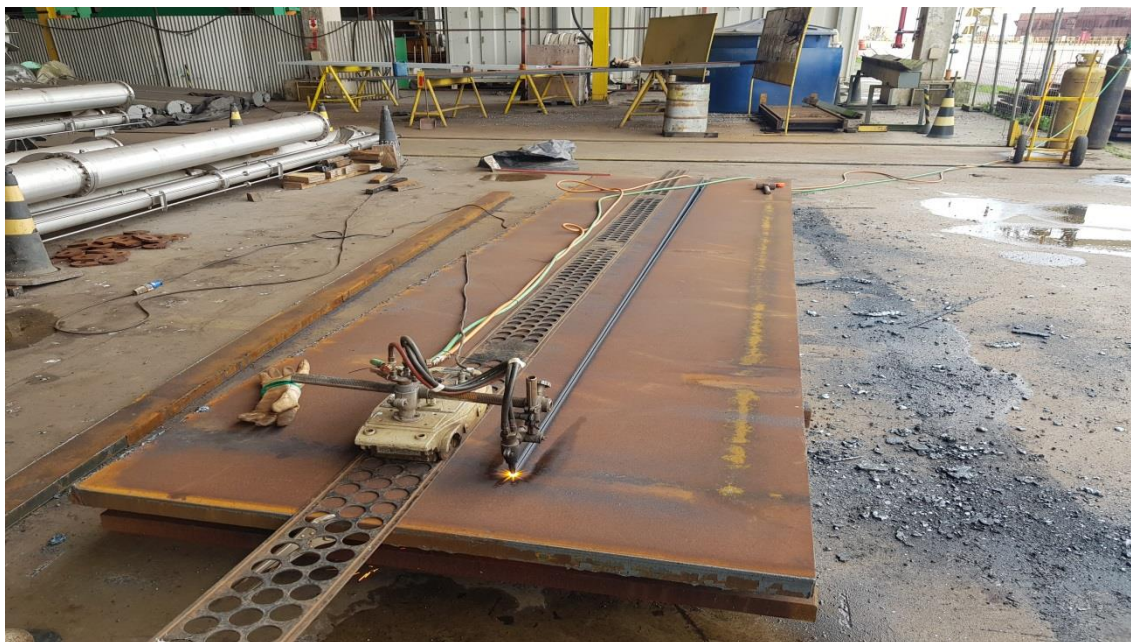
Manutenção Dique – Reforço de Chapa Vigas Coroamento
