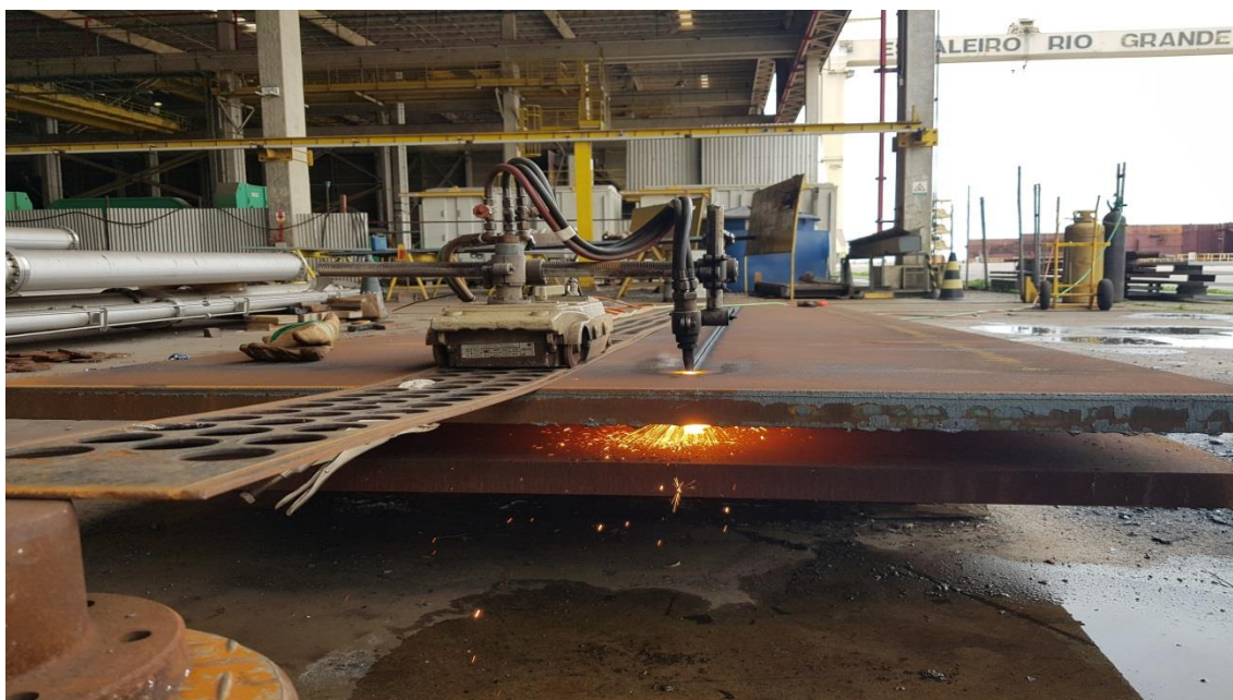
Manutenção Dique – Reforço de Chapa Vigas Coroamento
