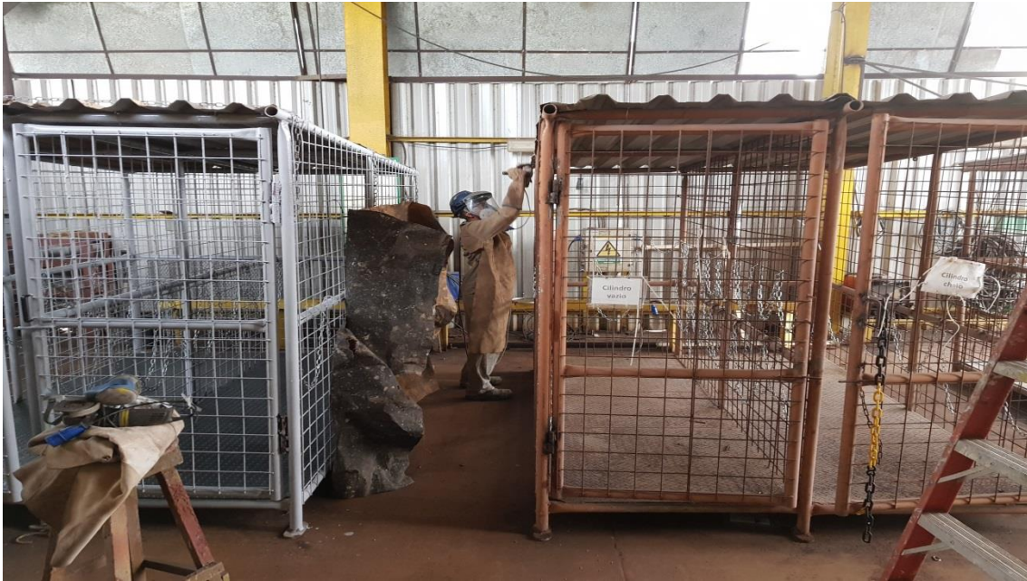
Manutenção Estruturas de Armazenamento de Cilindros
