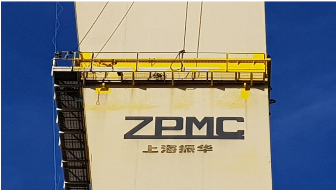
Alpinismo – Tratamento e Pintura Pórtico 600 ton
