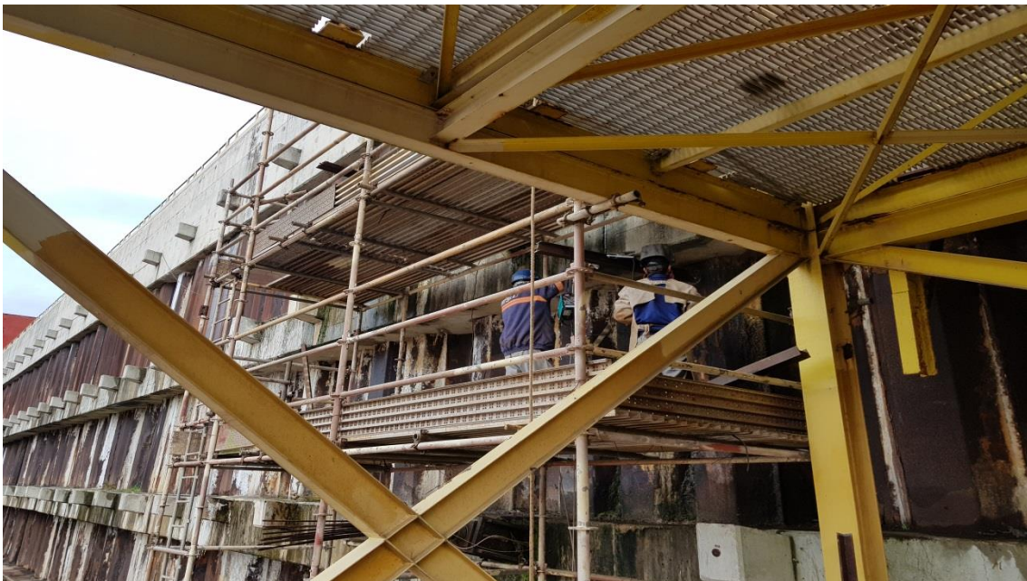
Manutenção Dique – Reforço de Chapa Vigas Coroamento
