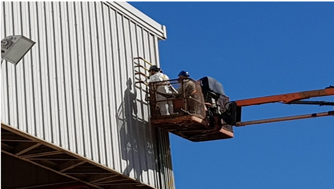
Tratamento e Pintura Tubulação de Gases
