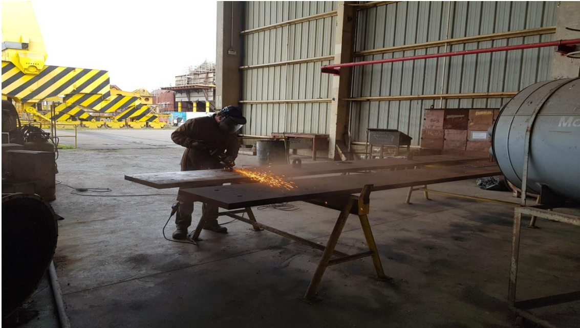
Manutenção Dique – Reforço de Chapa Vigas Coroamento
