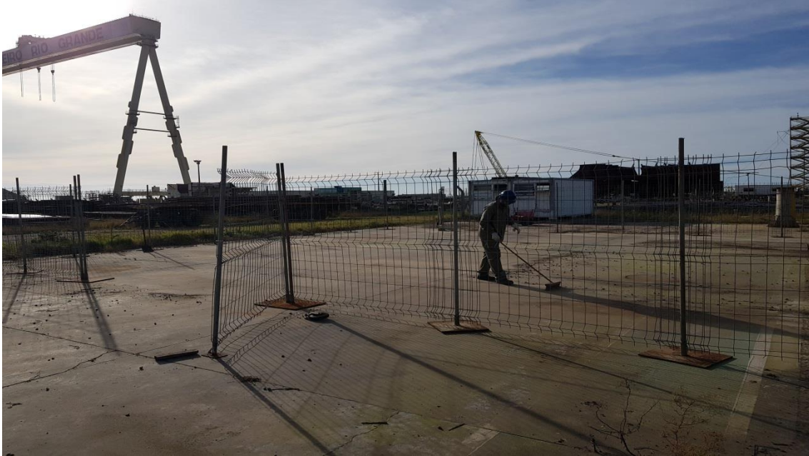
Central de Armazenamento de Cilindros
