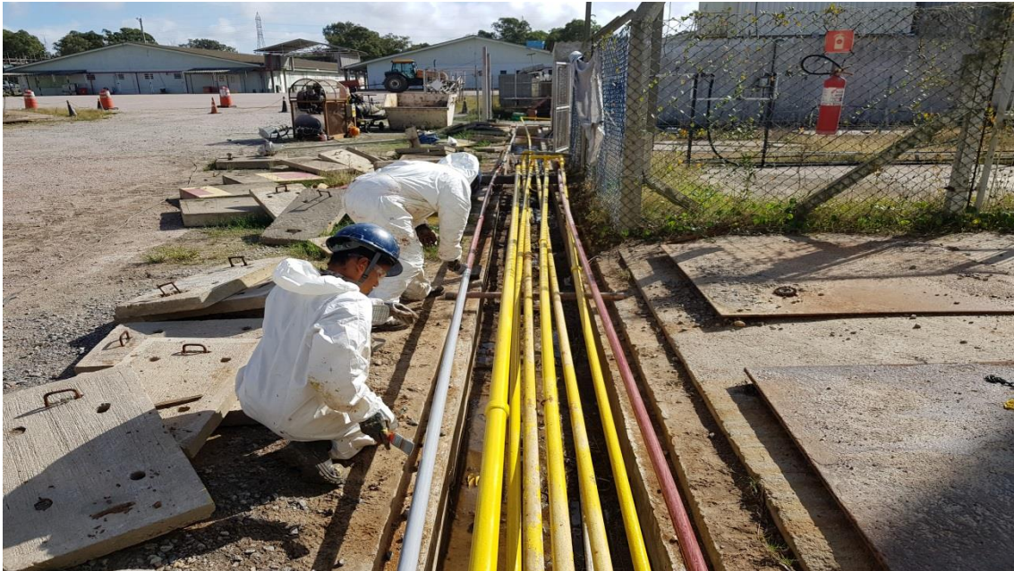
Tratamento e Pintura Tubulação de Gases
