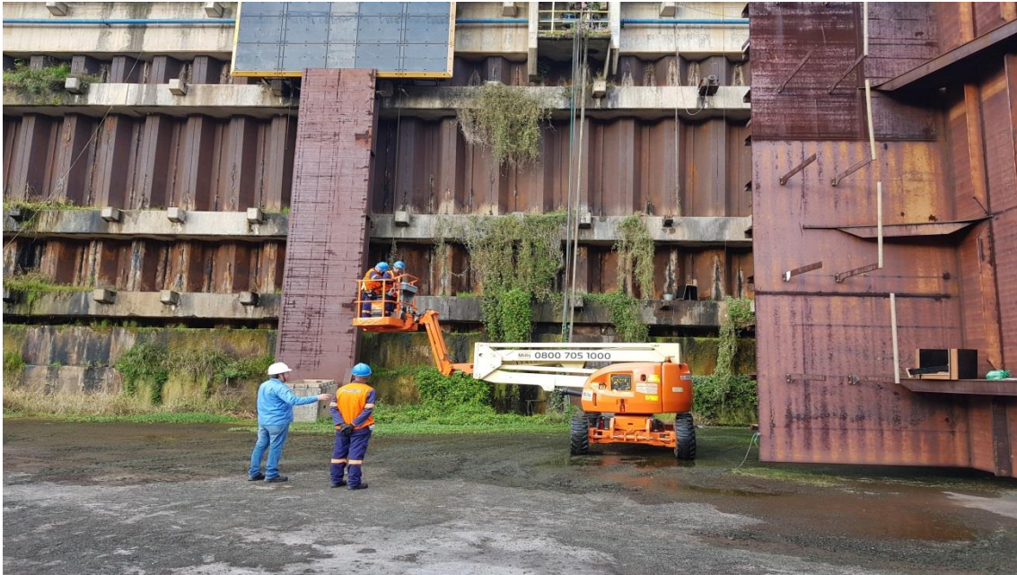
Manutenção Dique – Fechamento Cabeças dos Tirantes
