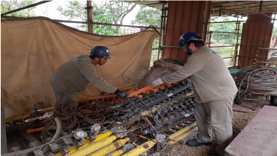
Manutenção Rede de Gases – Manifolds
