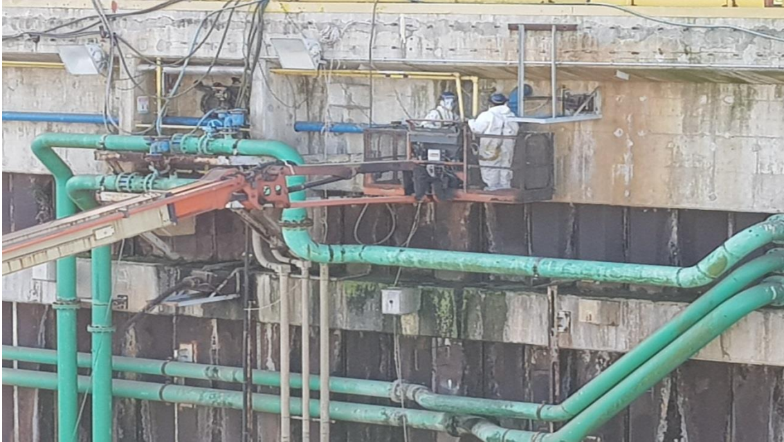
Tratamento e Pintura Tubulação de Gases
