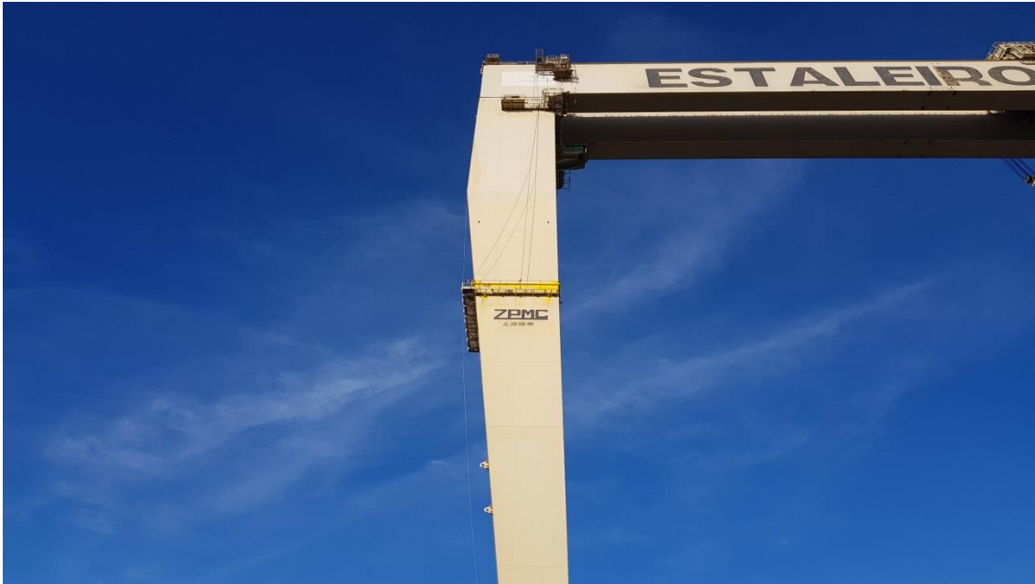
Alpinismo – Tratamento e Pintura Pórtico 600 ton
