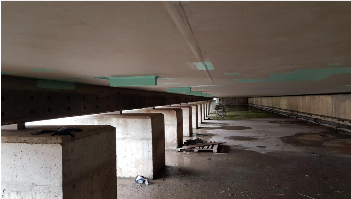
Manutenção Porta Batel
