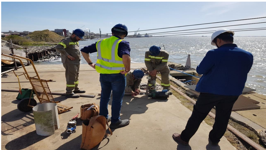
Atracação – Execução de Serviços
