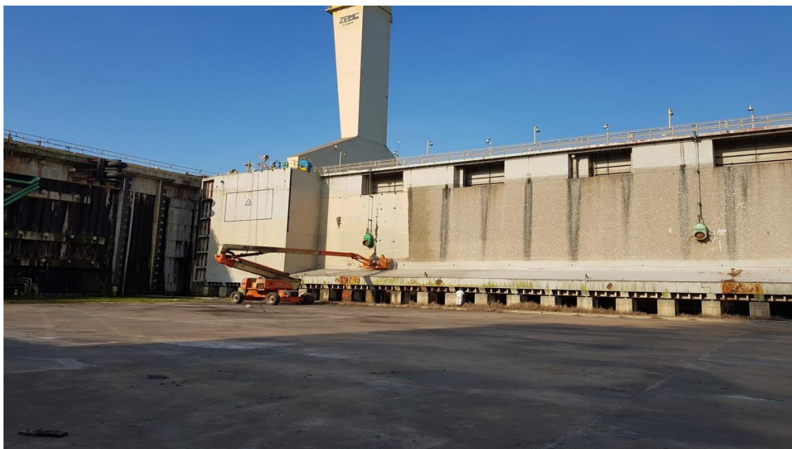
Manutenção Porta Batel
