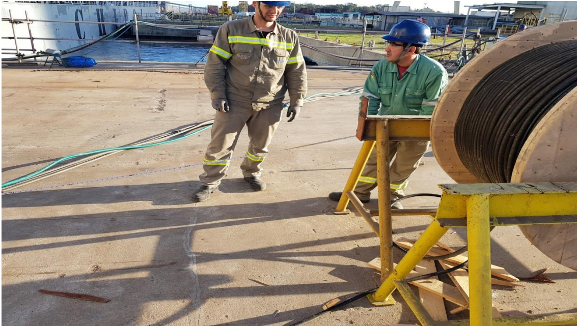
Atracação – Execução de Serviços
