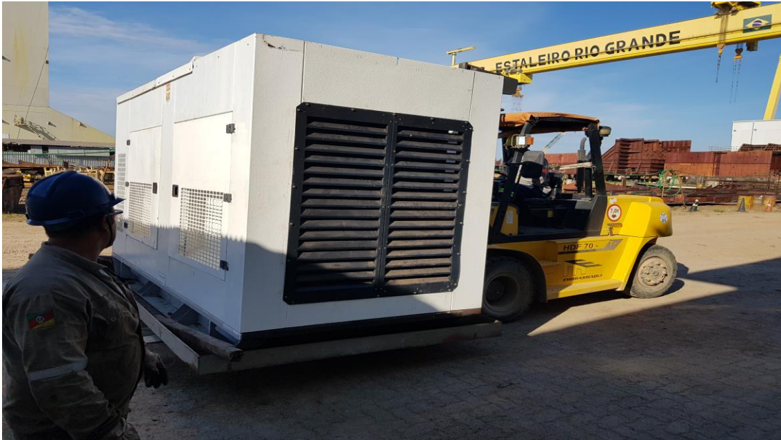
Manutenção Geradores de Emergência
