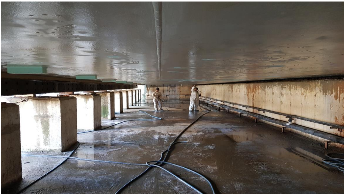
Manutenção Porta Batel
