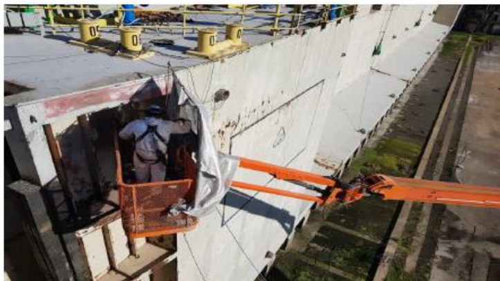
Manutenção Porta Batel
