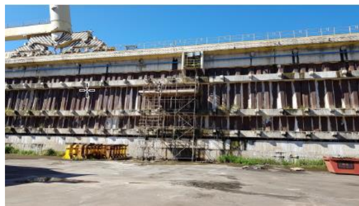
Manutenção Dique Seco
