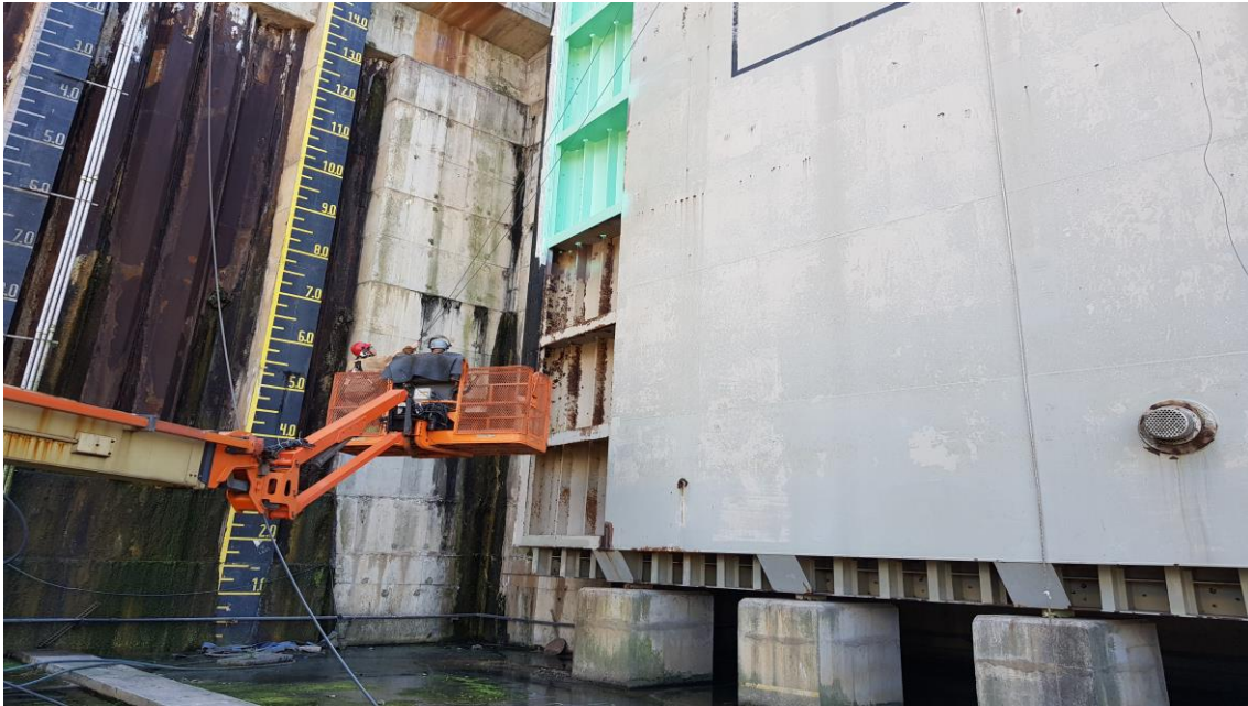
Manutenção Porta Batel
