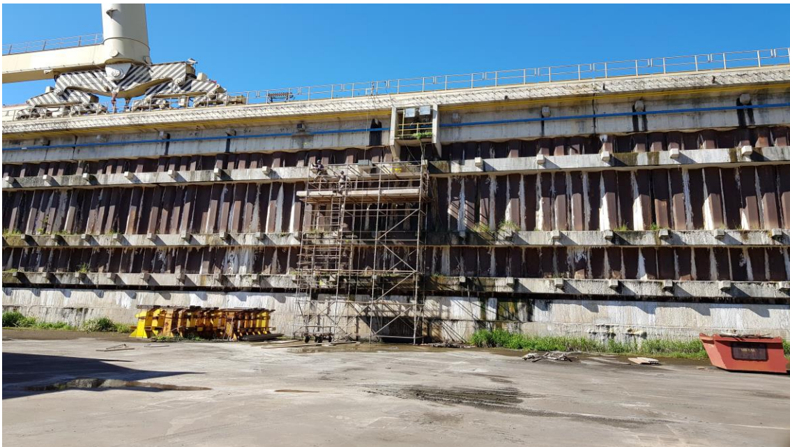
Manutenção Dique Seco
