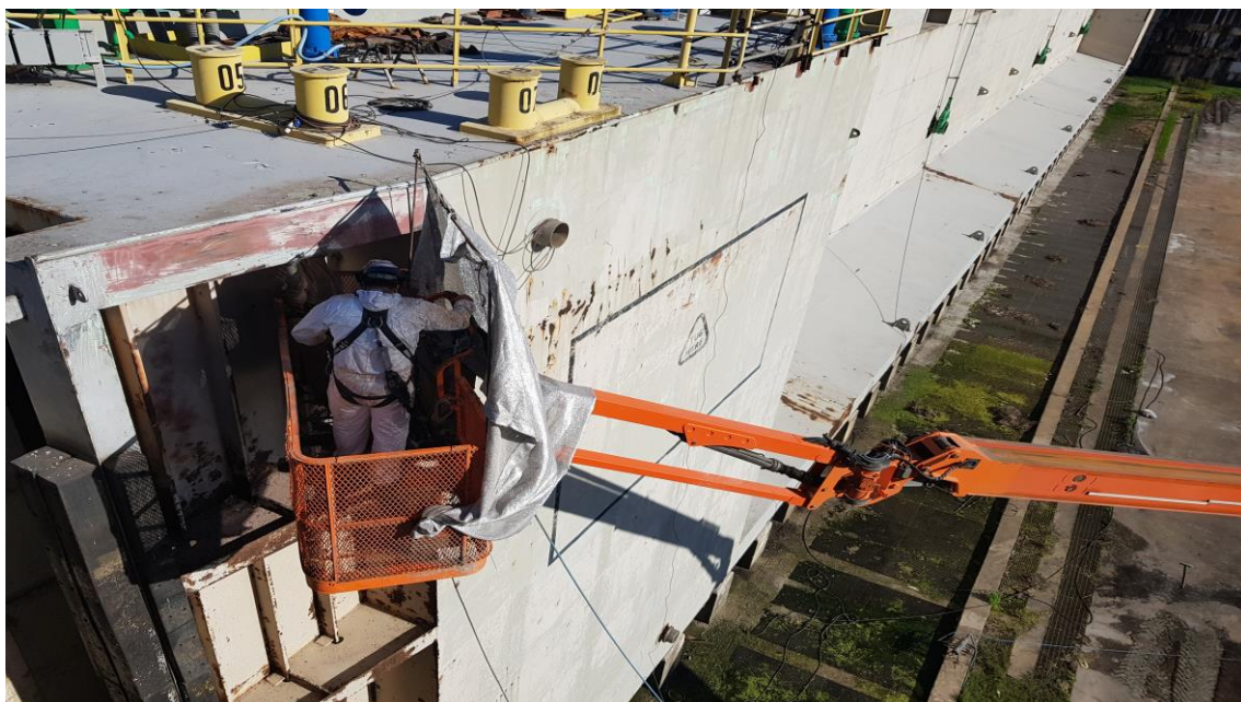
Manutenção Porta Batel
