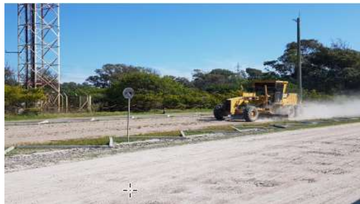
Manutenção Acessos Estaleiro
