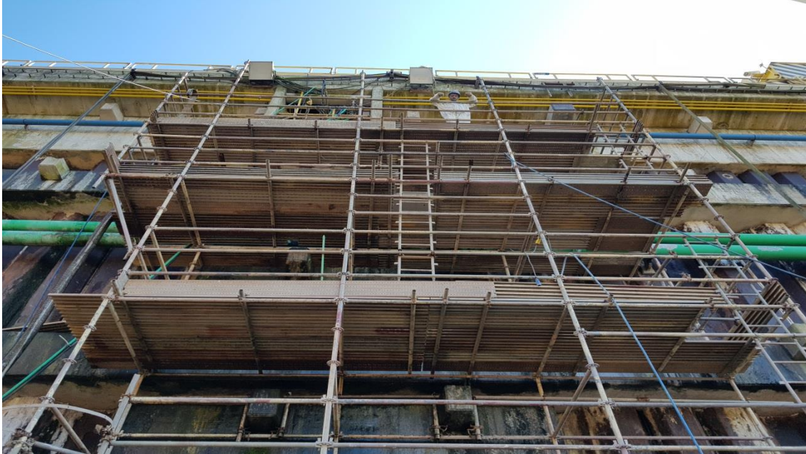
Manutenção Dique Seco
