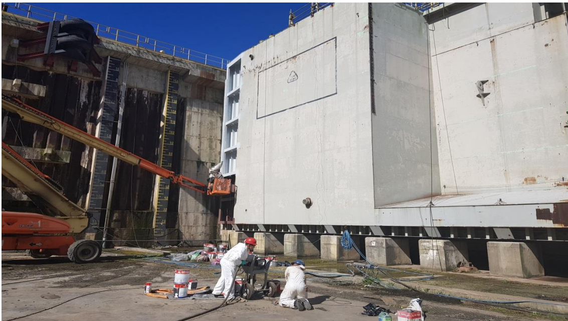
Manutenção Porta Batel
