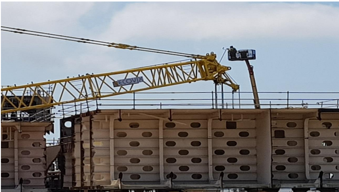
Manutenção Guindaste Sany
