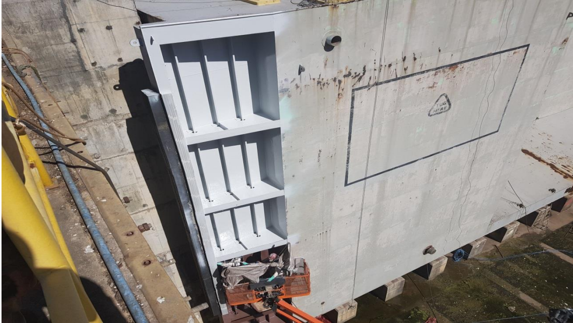
Manutenção Porta Batel
