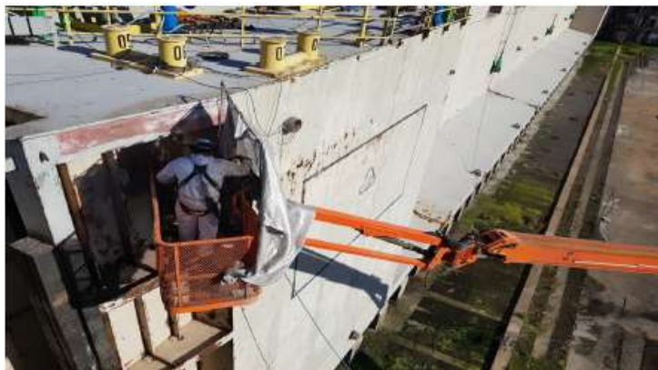
Manutenção Porta Batel
