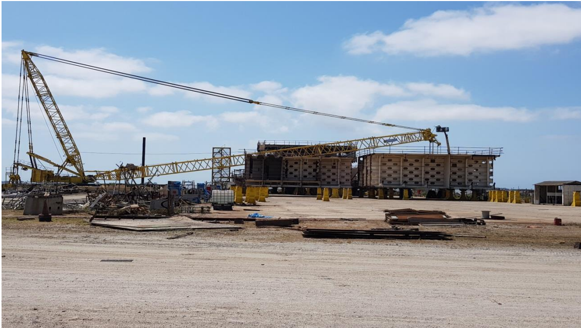
Manutenção Guindaste Sany
