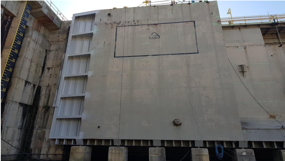
Manutenção Porta Batel
