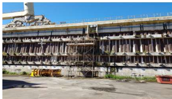
Manutenção DiQue Seco
