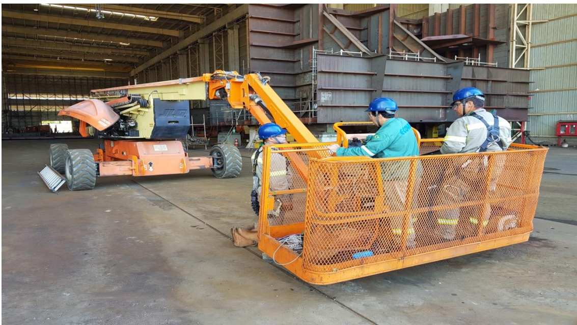
Manutenção Plataforma de Trabalho Aéreo – PTA
