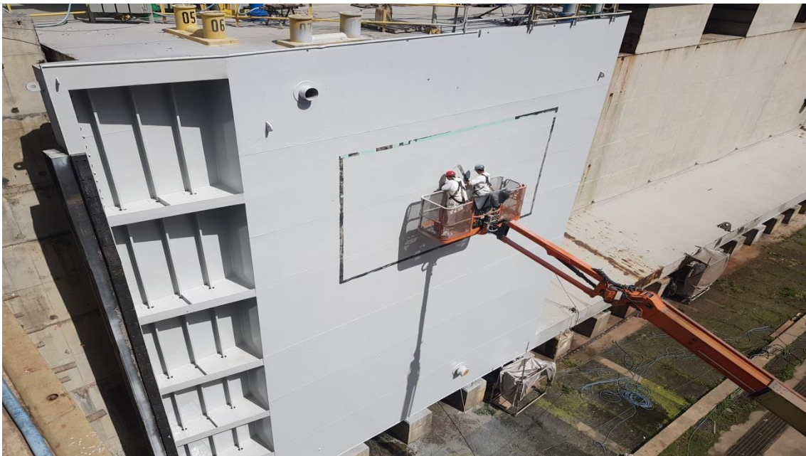
Manutenção Porta Batel
