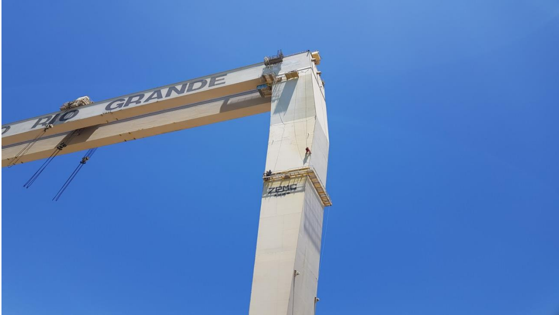
Manutenção Pórtico 600 ton
