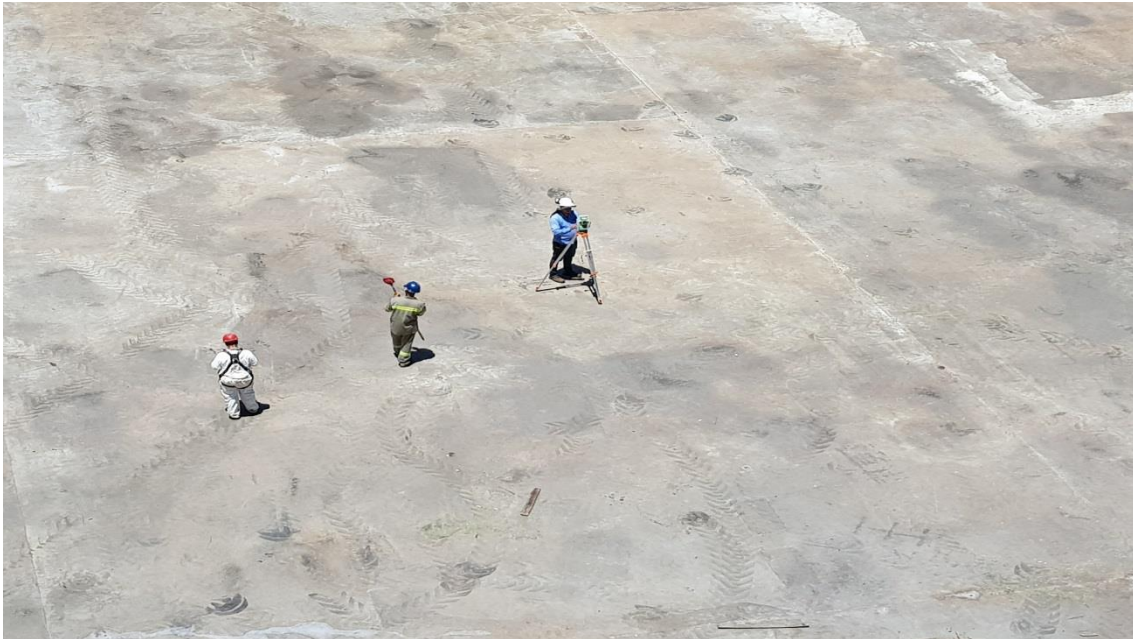
Monitoramento Dique Seco
