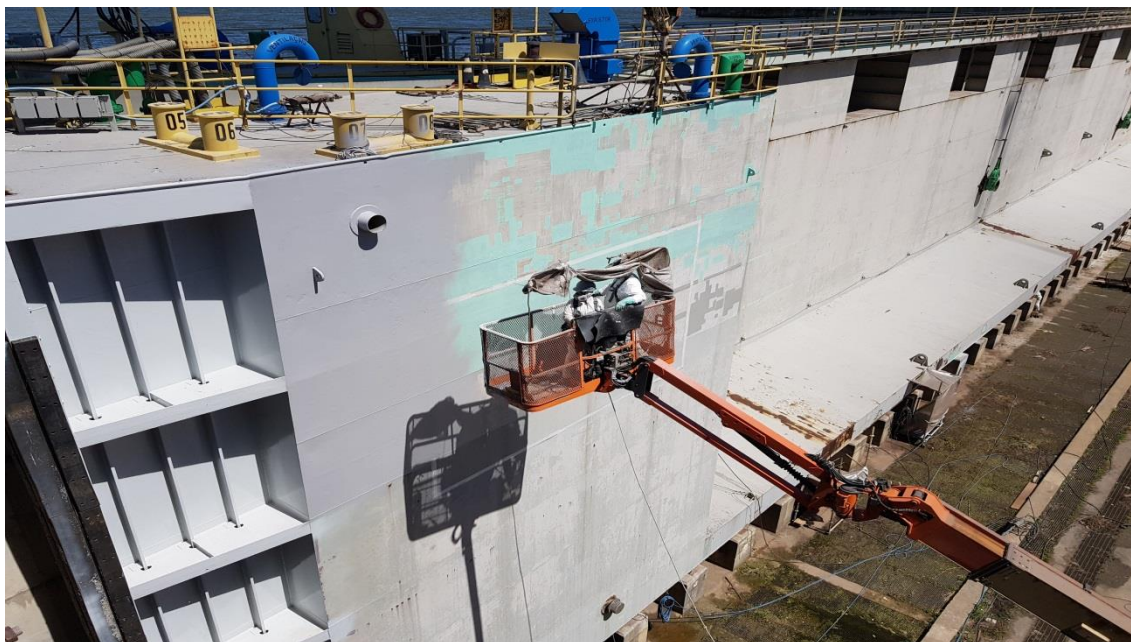
Manutenção Porta Batel
