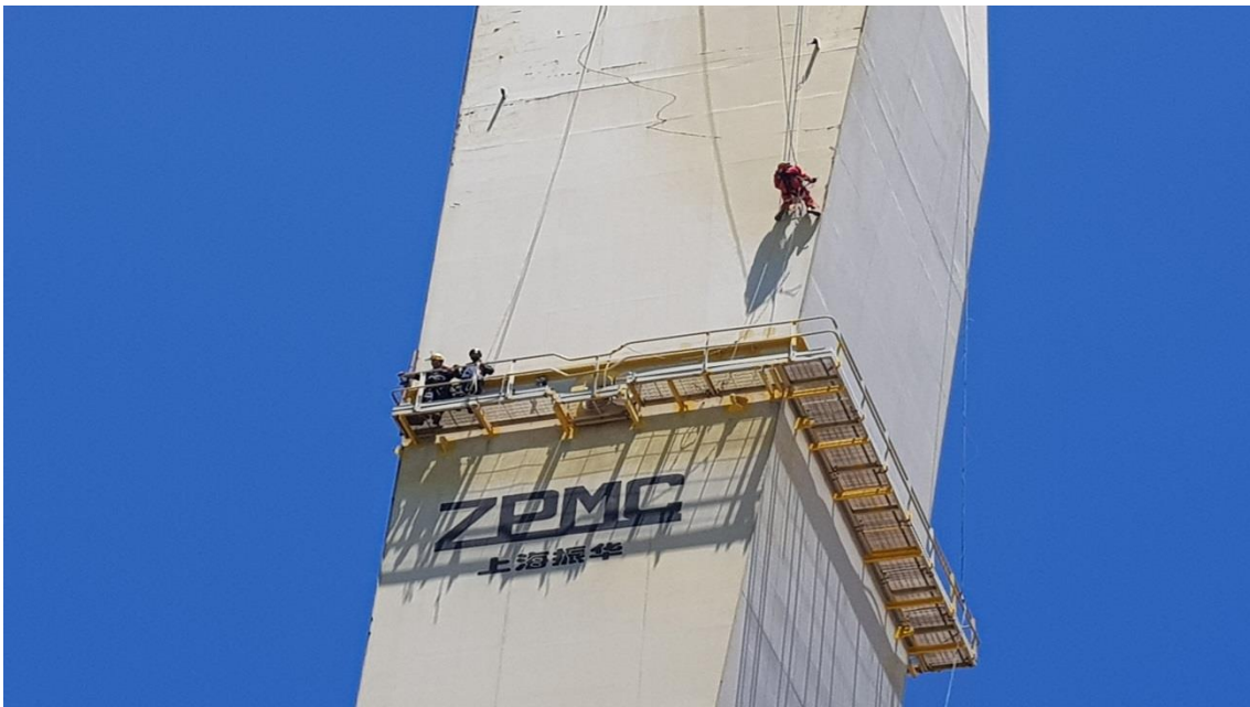
Manutenção Pórtico 600 ton
