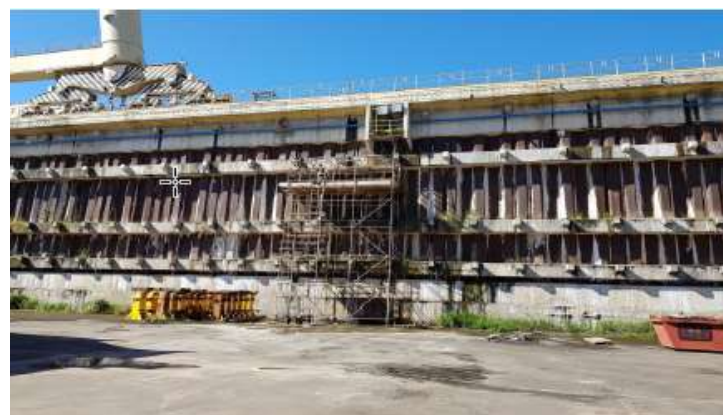
Manutenção Dique Seco
