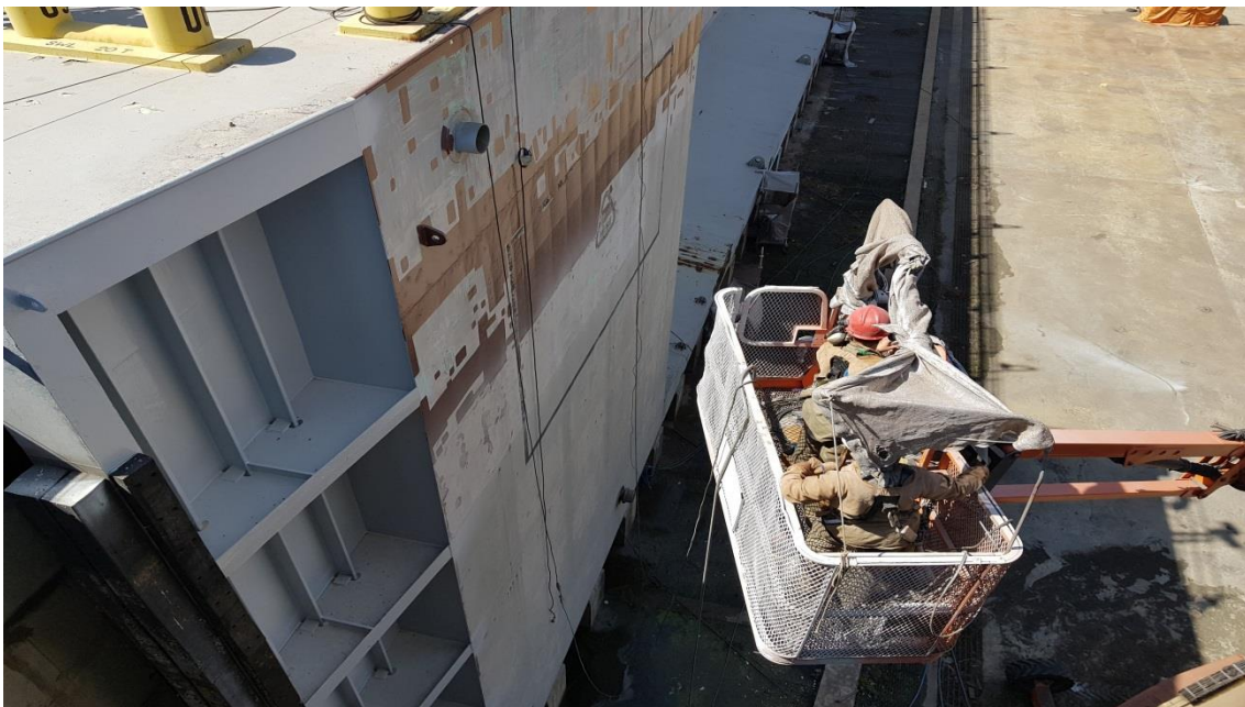
Manutenção Porta Batel
