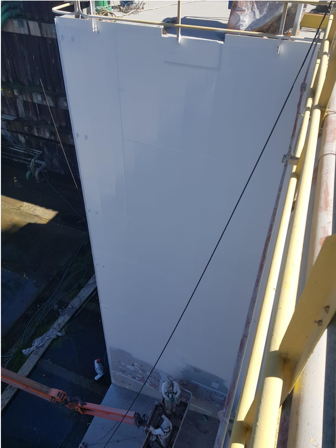
Manutenção Porta Batel
