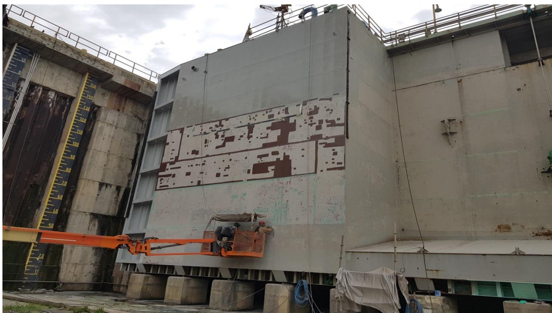
Manutenção Porta Batel
