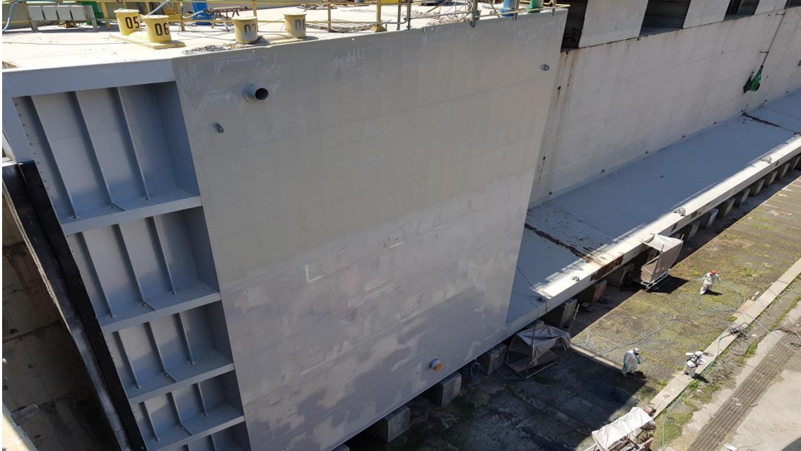
Manutenção Porta Batel
