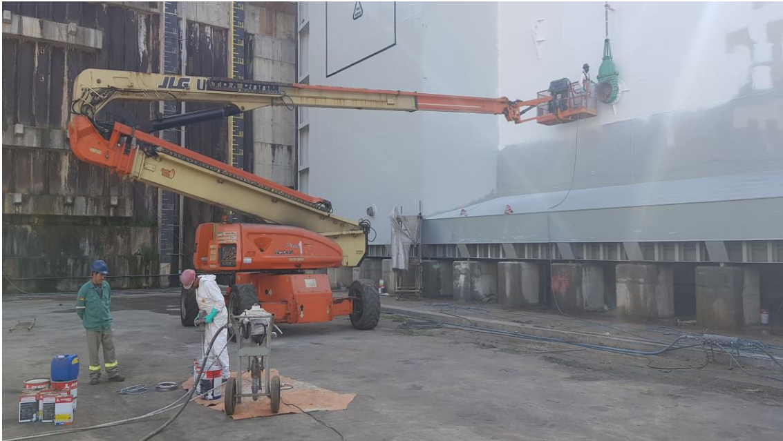
Tratamento e Pintura Porta Batel
