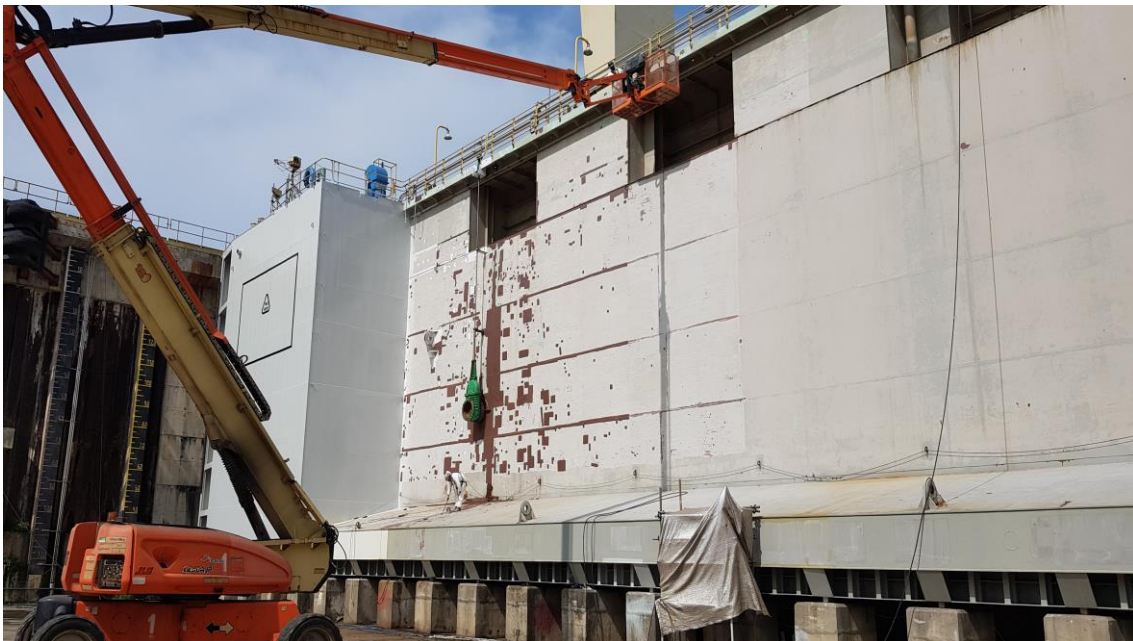
Tratamento e Pintura Porta Batel
