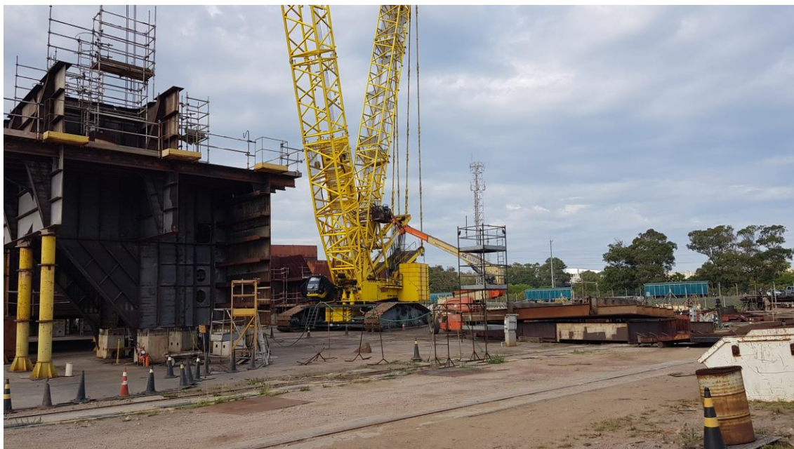
Manutenção Guindaste Sany 750 ton
