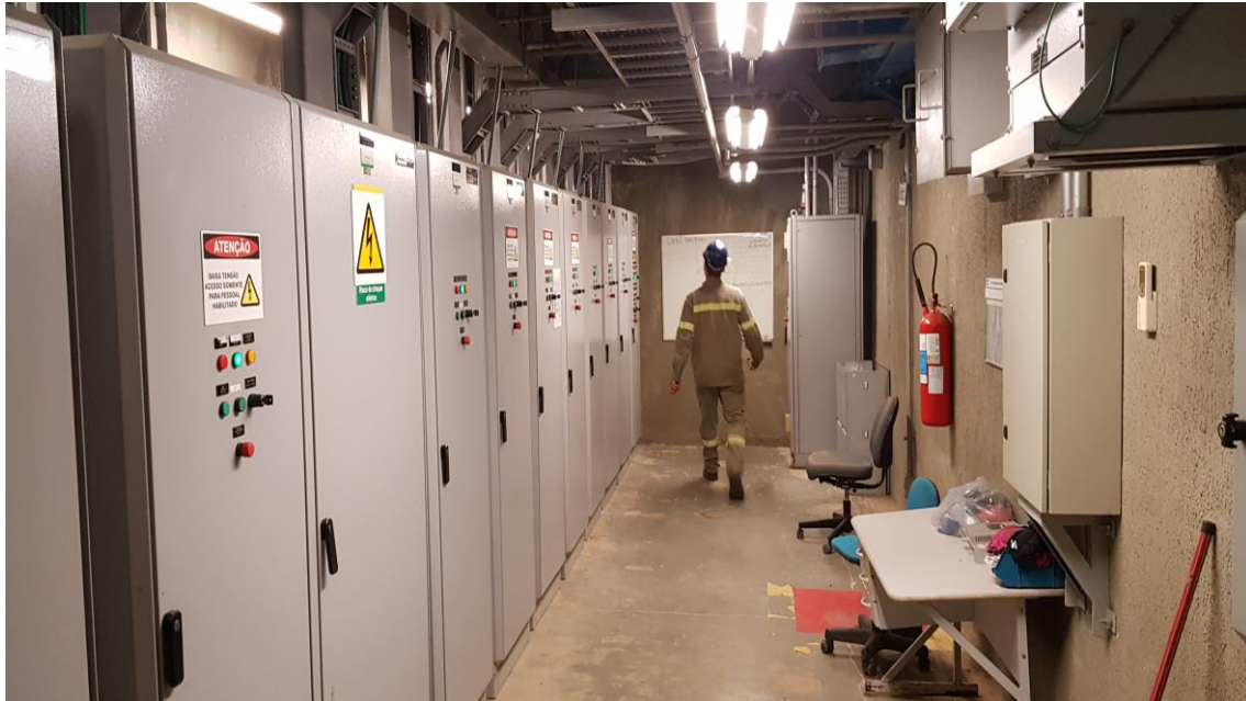
Manutenção Casa de Bombas do Dique
