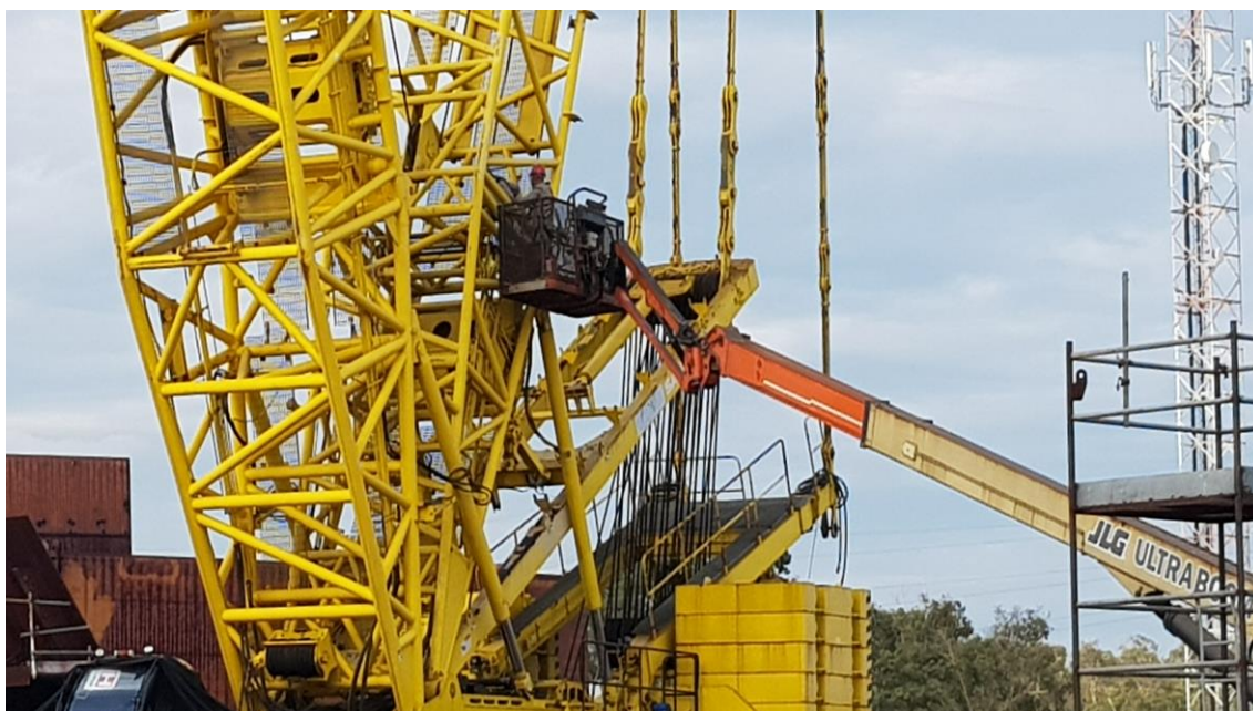
Manutenção Guindaste Sany 750 ton
