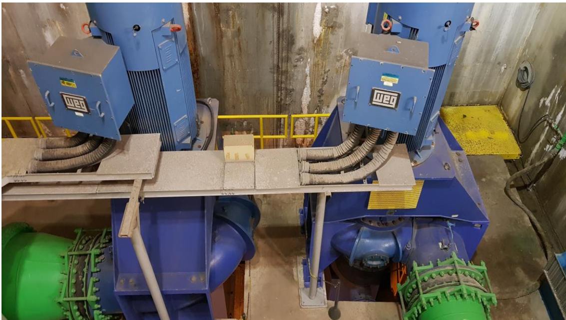
Manutenção Casa de Bombas do Dique
