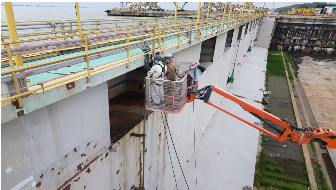
Tratamento e Pintura Porta Batel
