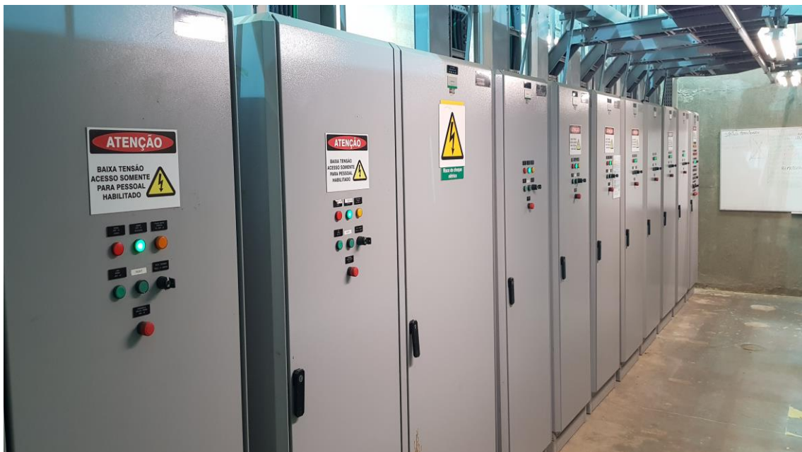
Manutenção Casa de Bombas do Dique
