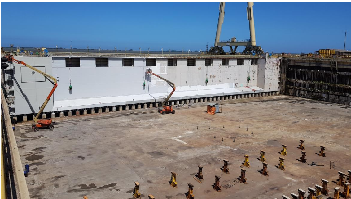
Tratamento e Pintura Porta Batel
