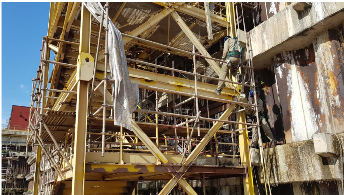
Manutenção Escadas de Acesso
