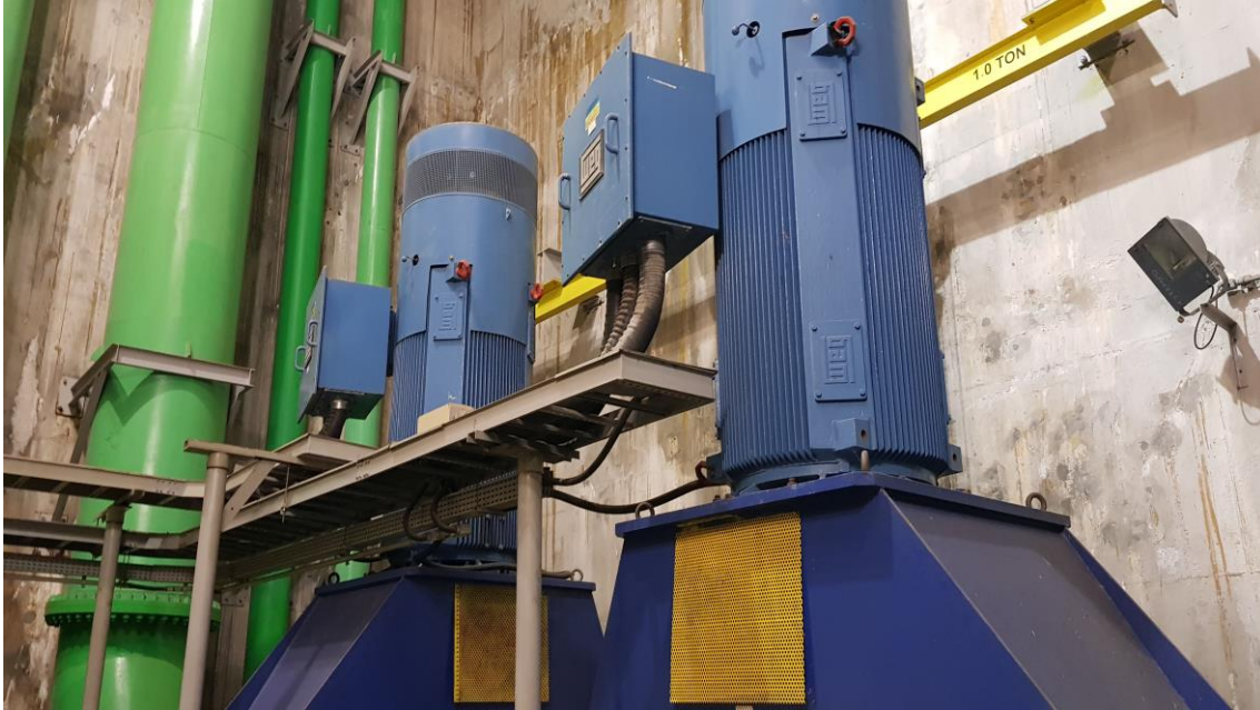
Manutenção Casa de Bombas do Dique
