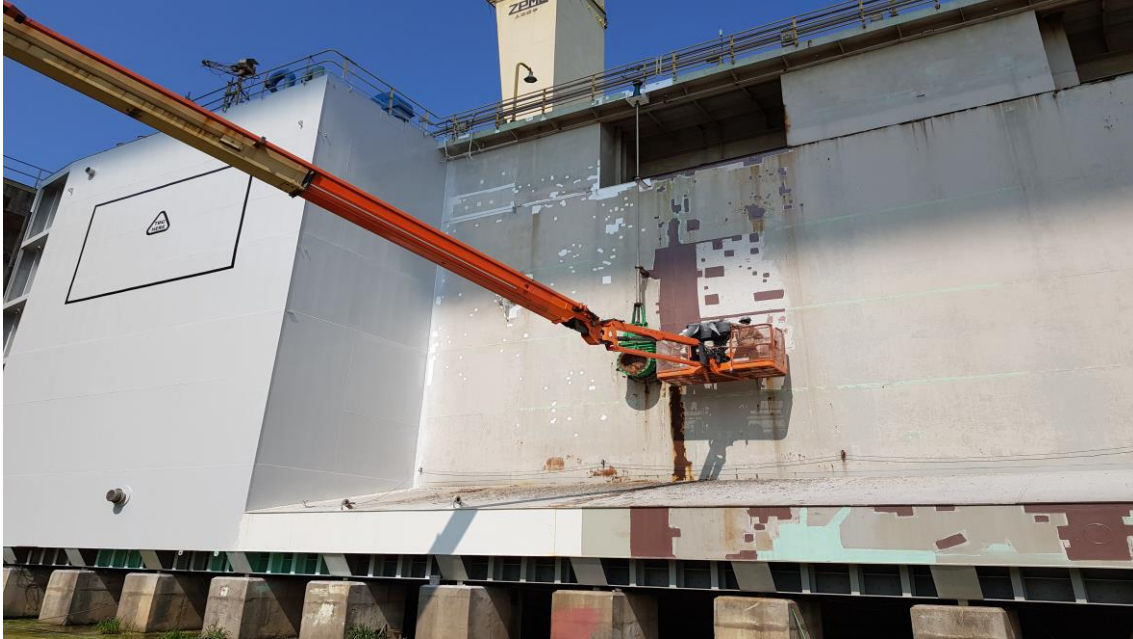
Tratamento e Pintura Porta Batel
