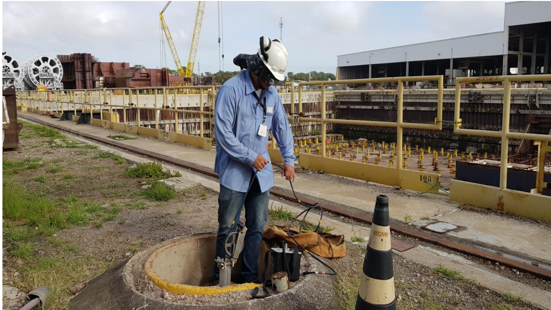
Monitoramento Geotécnico do Dique Seco
