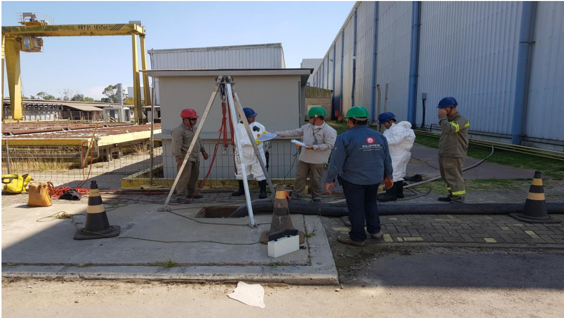
Manutenção Sistemas do Estaleiro
