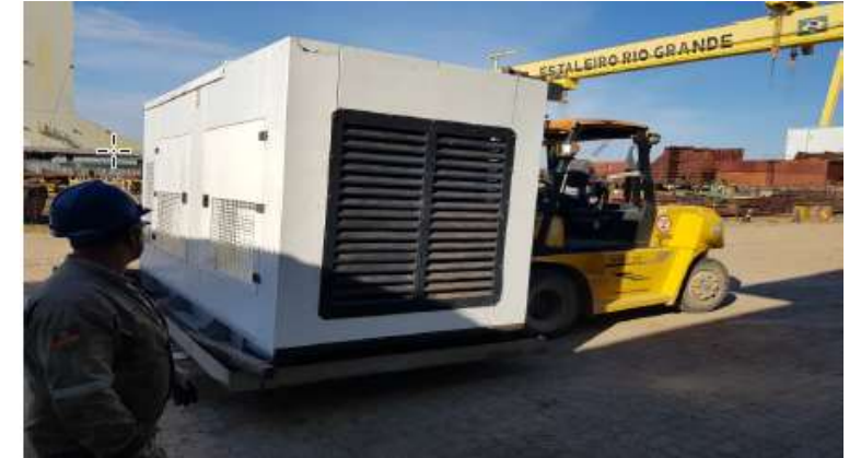
Manutenção Geradores de Emergência
