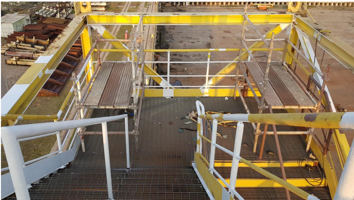
Manutenção Escada de Acesso Dique
