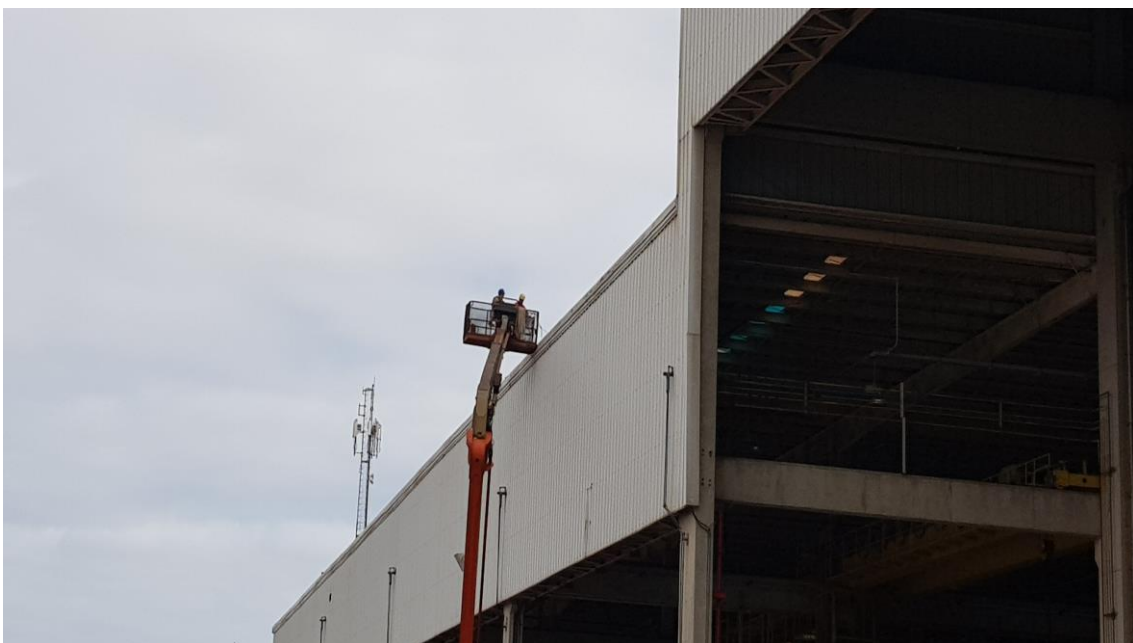
Manutenção Telhados Oficinas
