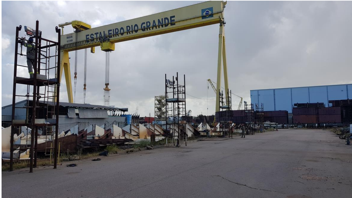
Iluminação Apoio Corte de Sucata
