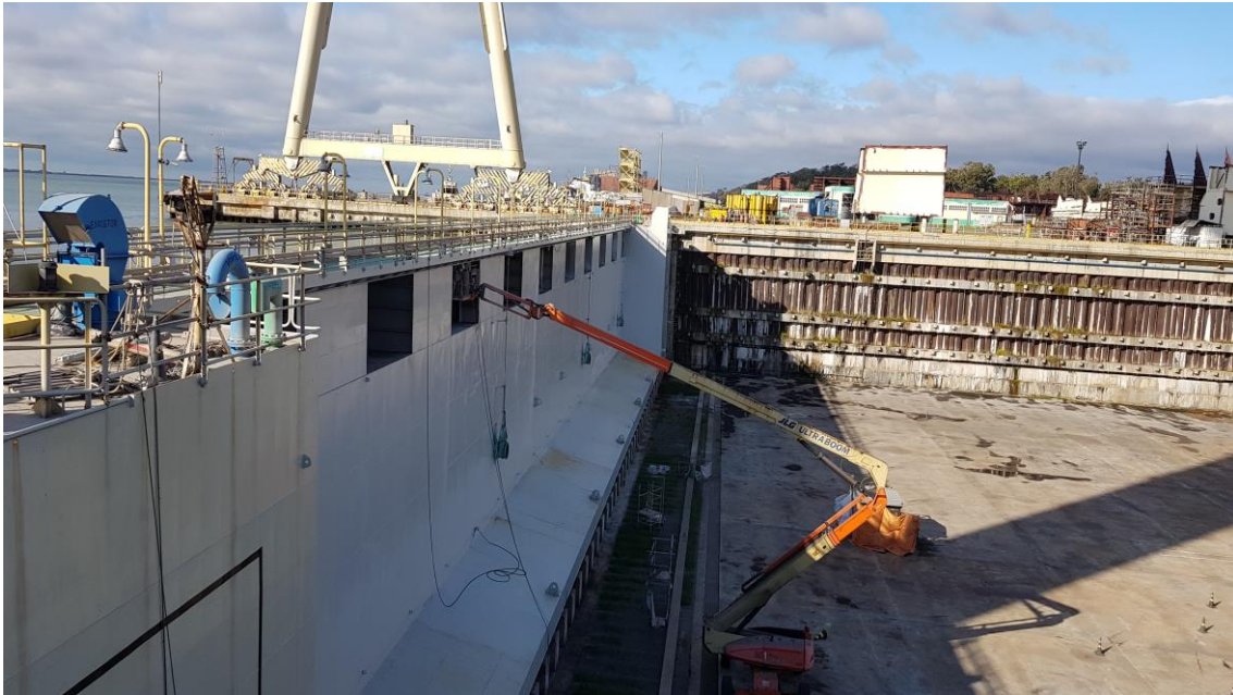
Tratamento e Pintura Porta Batel
