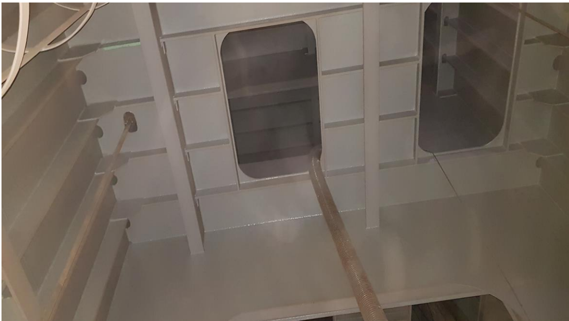
Tratamento e Pintura Porta Batel – Tanque
