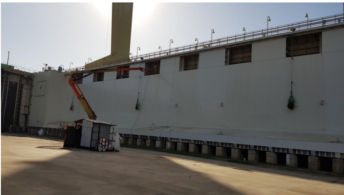
Tratamento e Pintura Porta Batel
