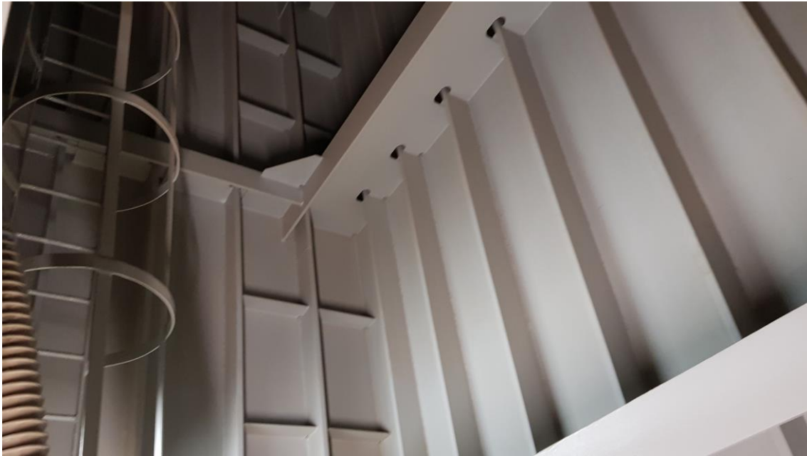
Tratamento e Pintura Porta Batel – Tanque
