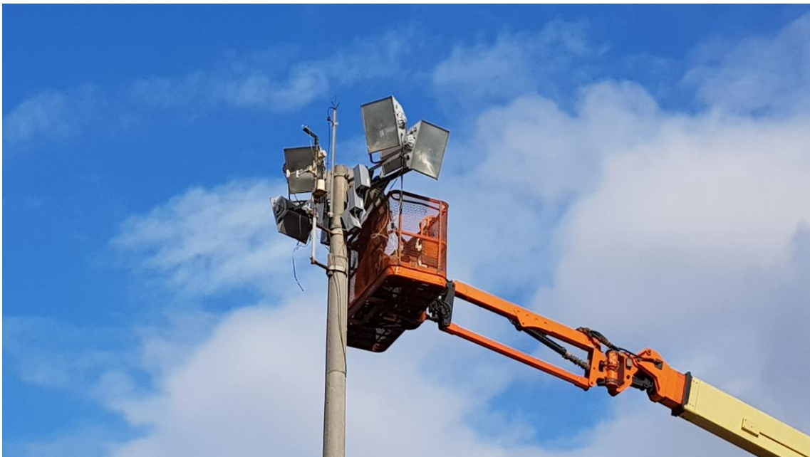
Manutenção Iluminação Externa
