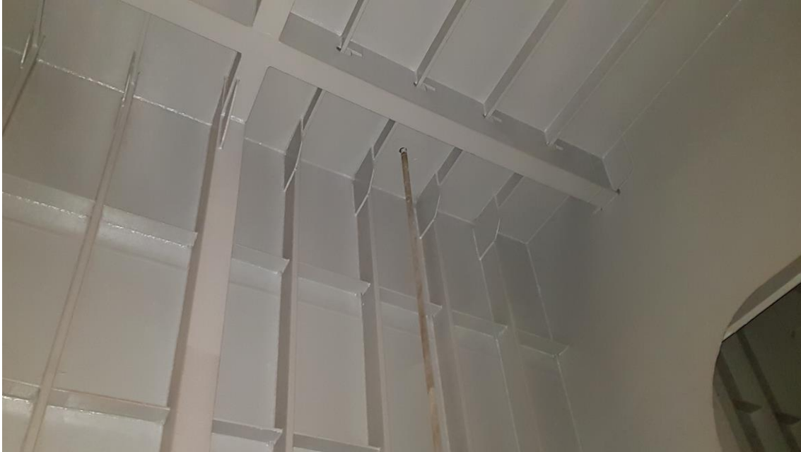
Tratamento e Pintura Porta Batel – Tanque
