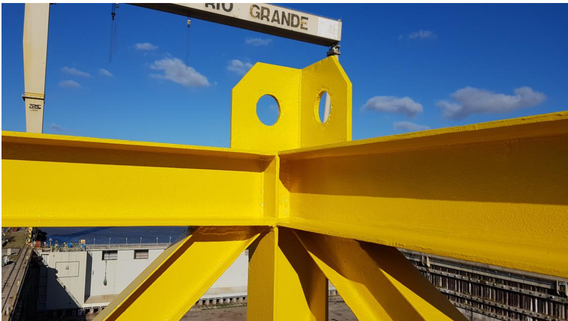
Manutenção Escada de Acesso Dique
