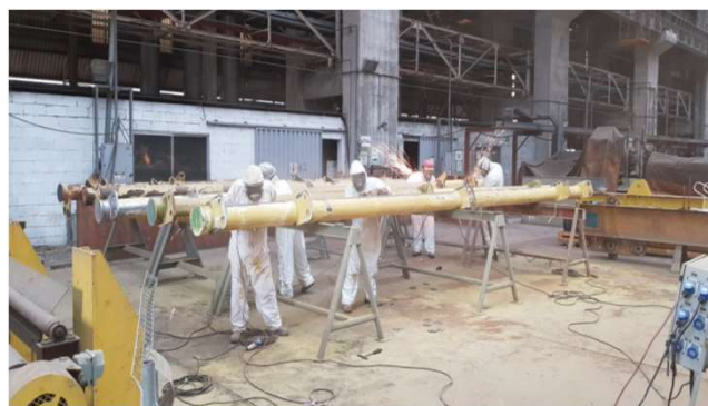
Tratamento e pintura de equipamentos
