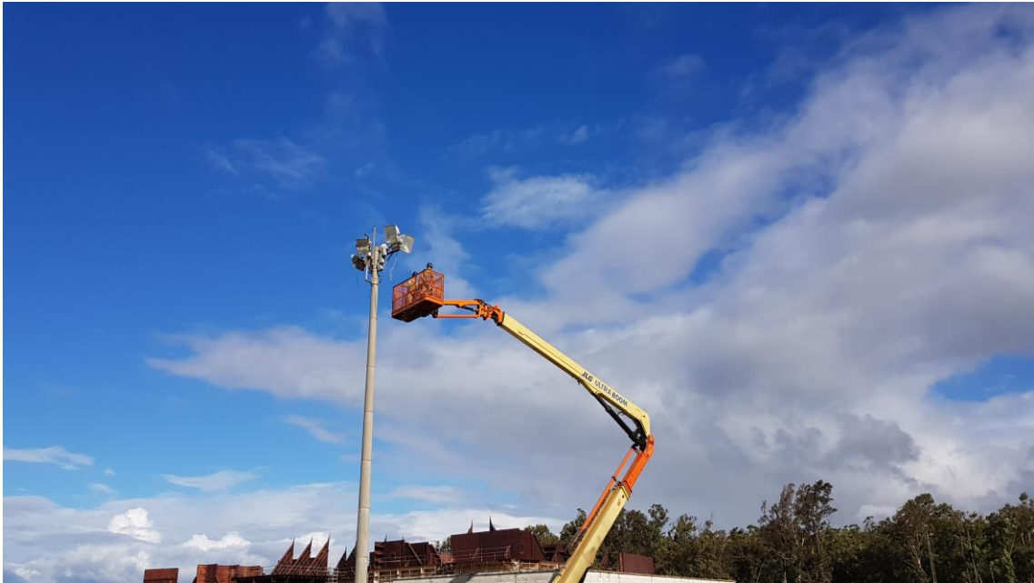
Manutenção Iluminação Externa
