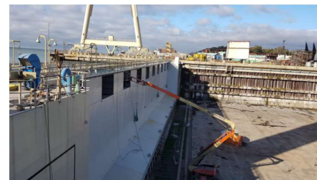
Tratamento e pintura porta Batel
