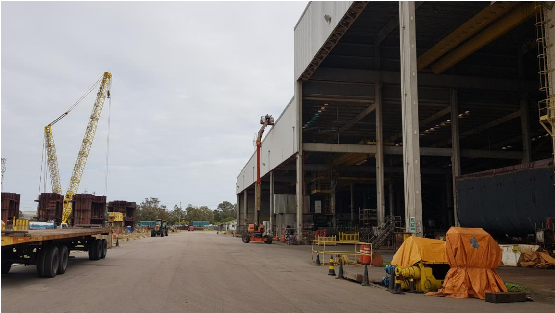
Manutenção Telhados Oficinas
