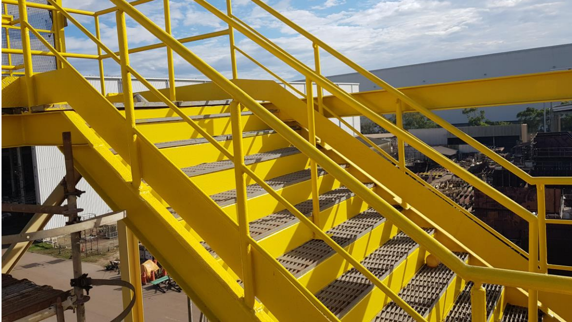
Manutenção Escada de Acesso Dique
