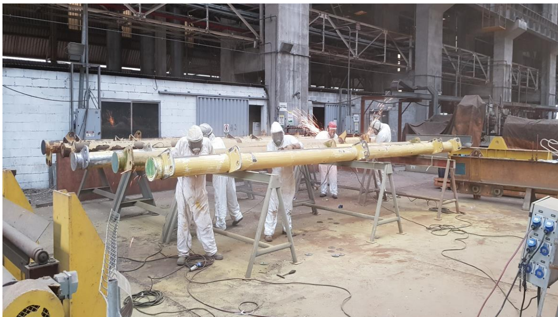
Tratamento e Pintura – Equipamentos
