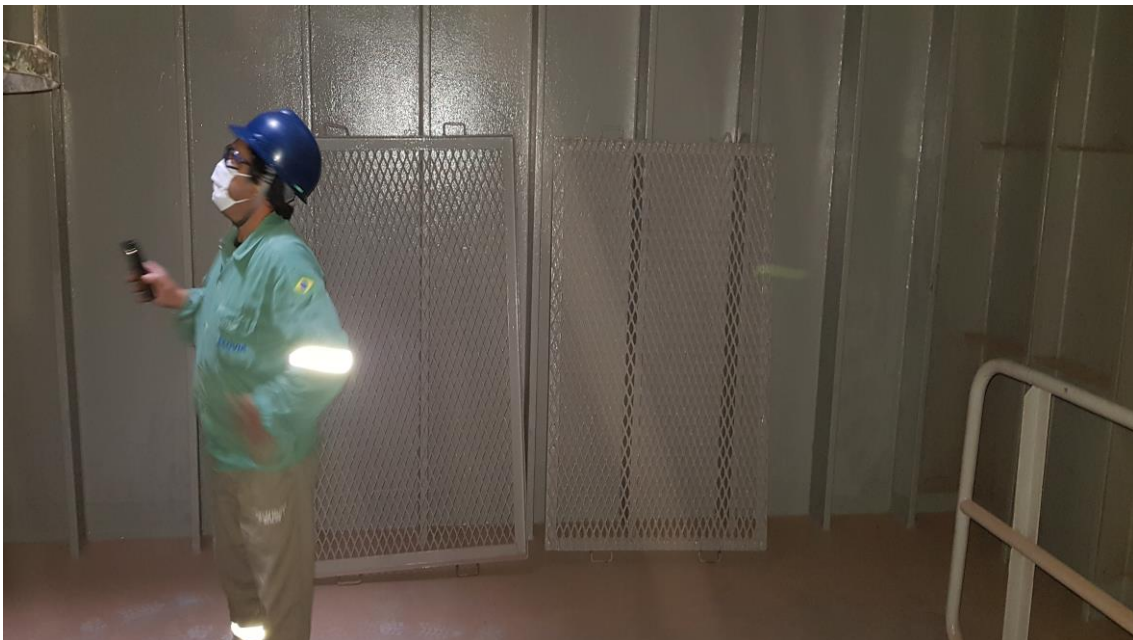
Tratamento e Pintura Porta Batel – Tanque
