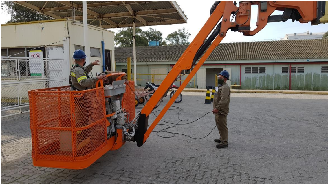
Manutenção Iluminação Externa
