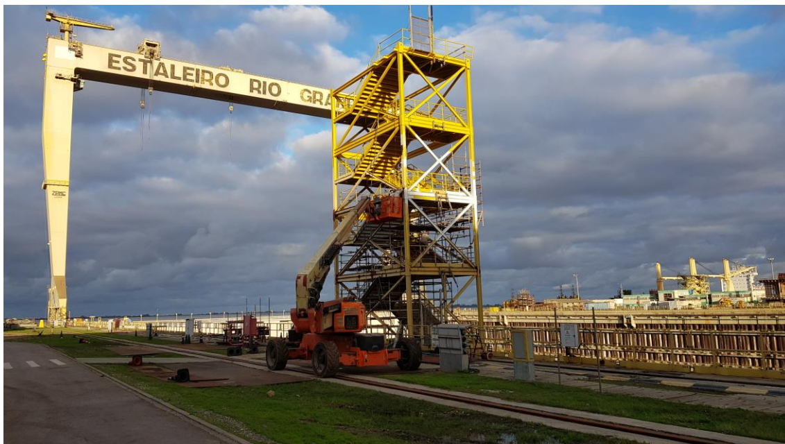
Manutenção Escada de Acesso Dique
