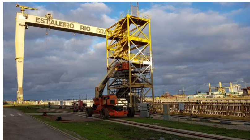
Manutenção escada de Acesso Dique
