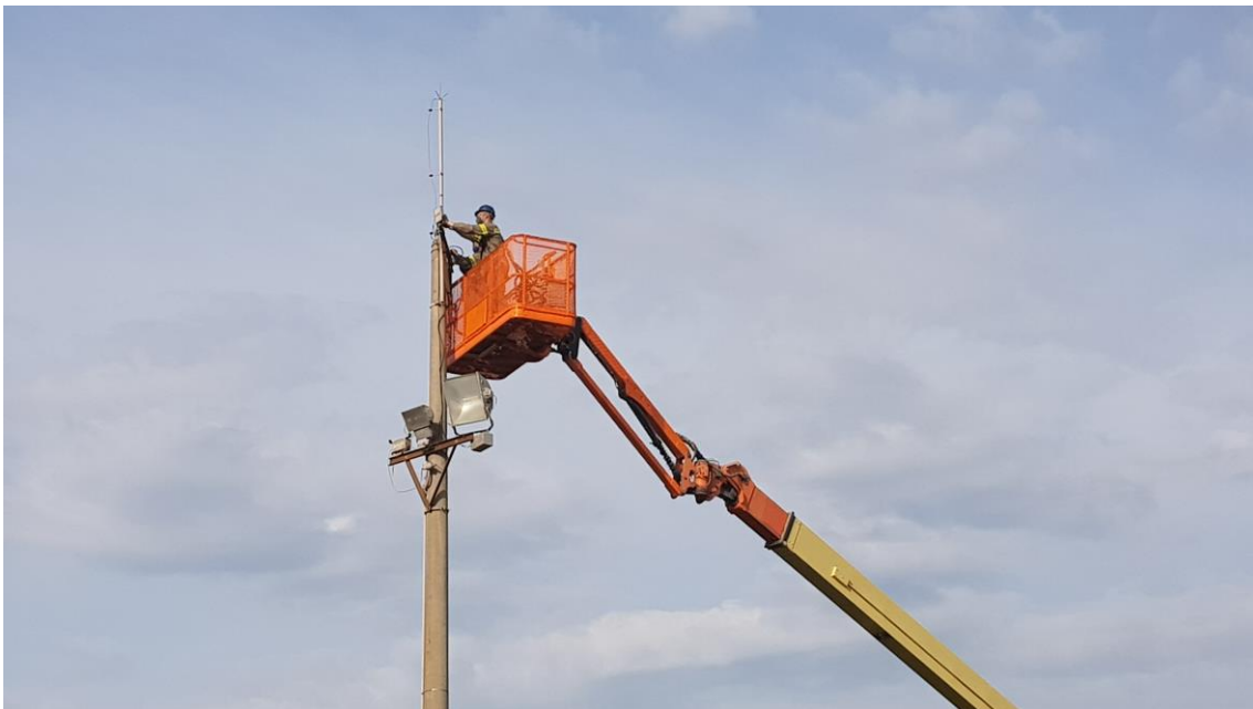
Manutenção Iluminação Externa
