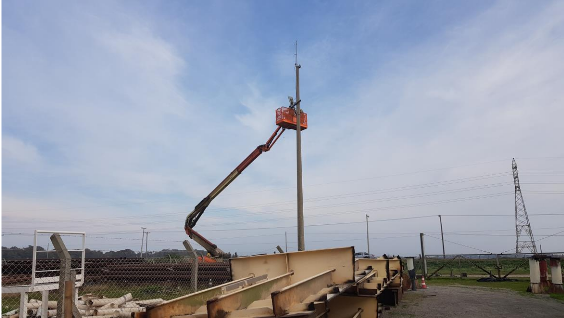
Manutenção Iluminação Externa
