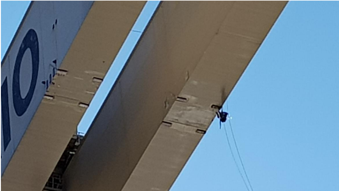
Manutenção Pórtico 600 ton – Alpinismo
