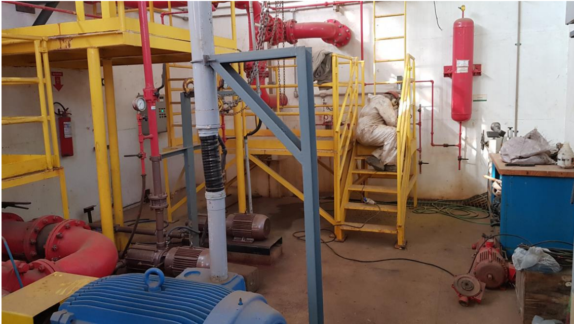
Manutenção Casa de Bomba Combate Incêndio
