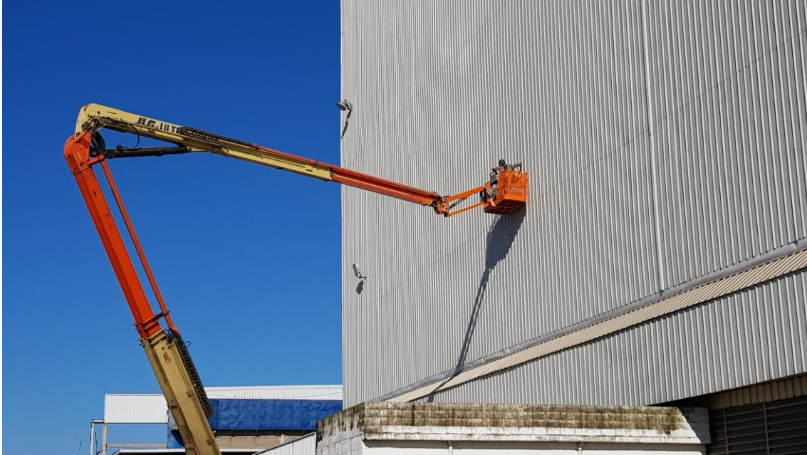
Manutenção Iluminação Externa
