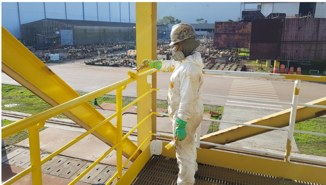
Manutenção Escada de Acesso Dique
