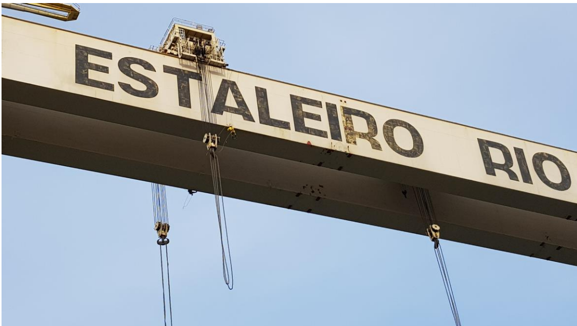
Manutenção Pórtico 600 ton – Alpinismo
