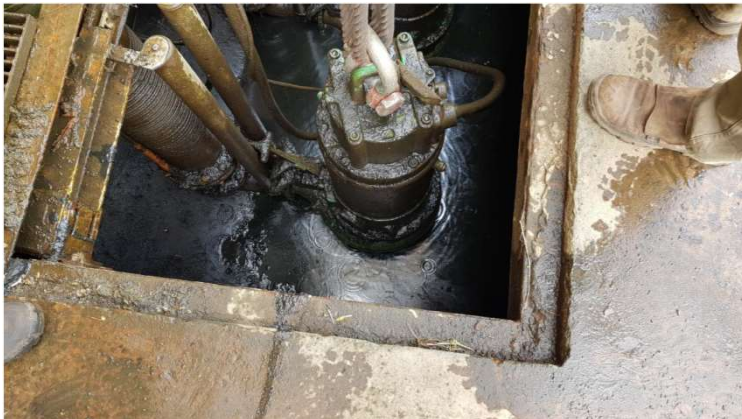
Manutenção Sistemas de Drenagem Dique
