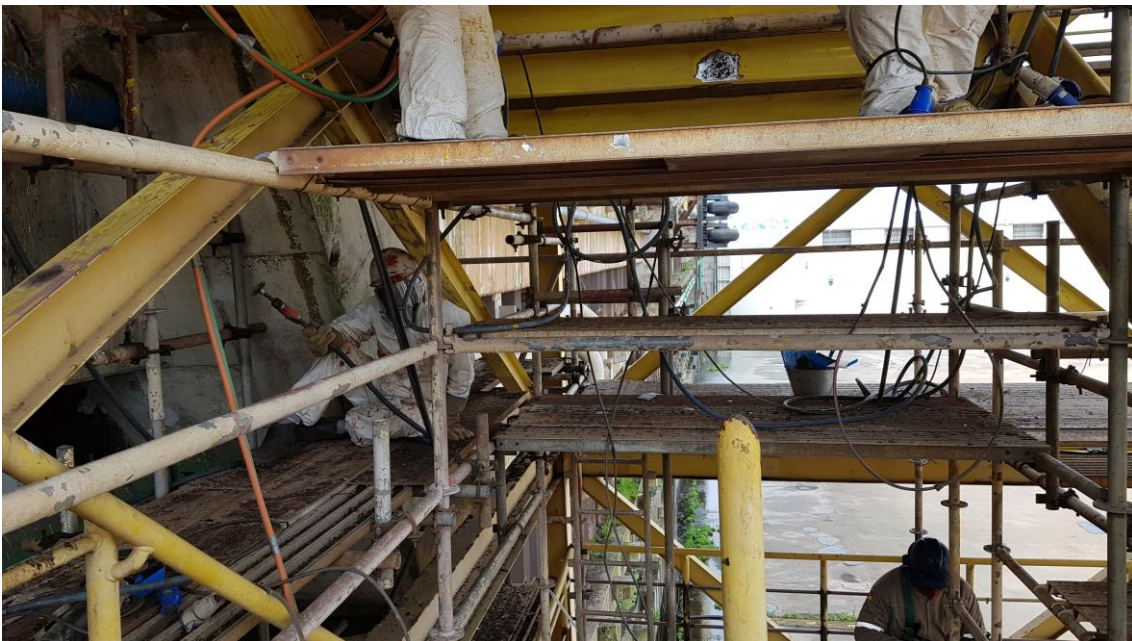
Manutenção Escadas de Acesso
