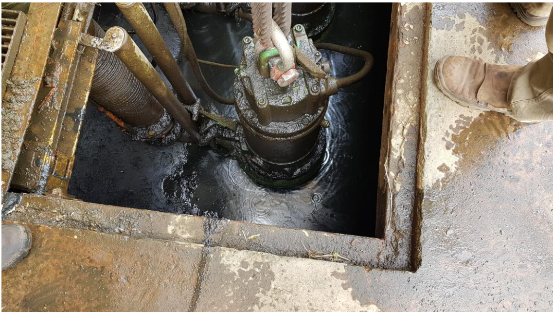
Manutenção Sistema de Drenagem Dique
