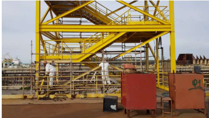
Manutenção Escada Estaleiro
