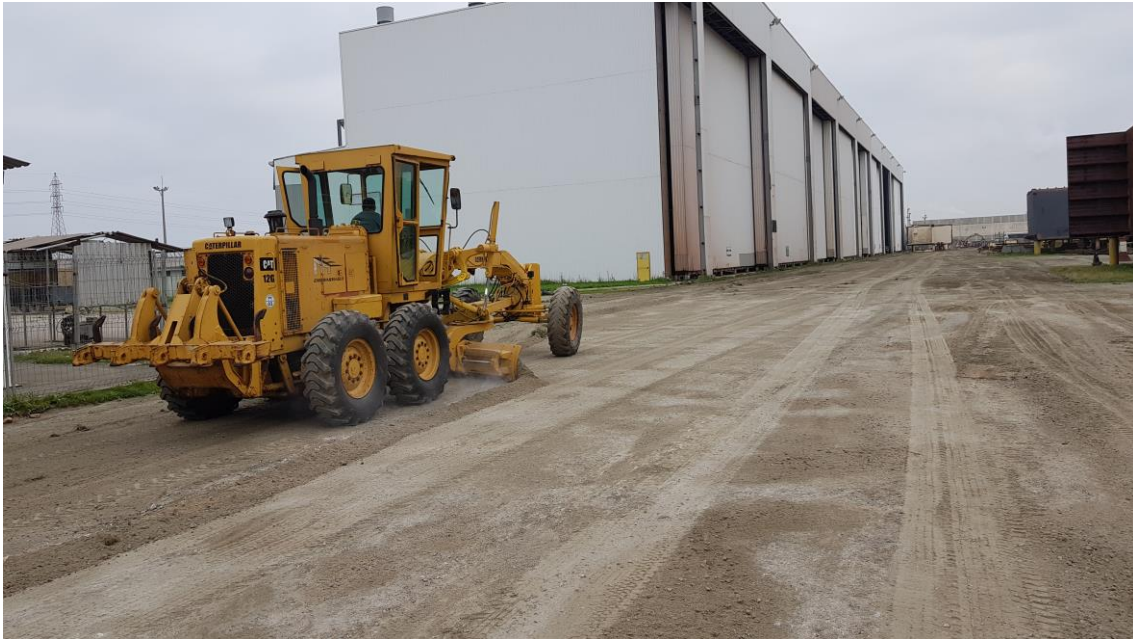
Manutenção Acessos do Estaleiro
