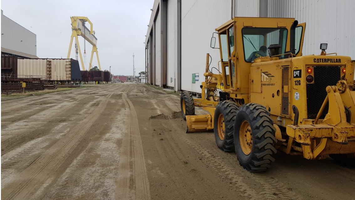
Manutenção Acessos do Estaleiro
