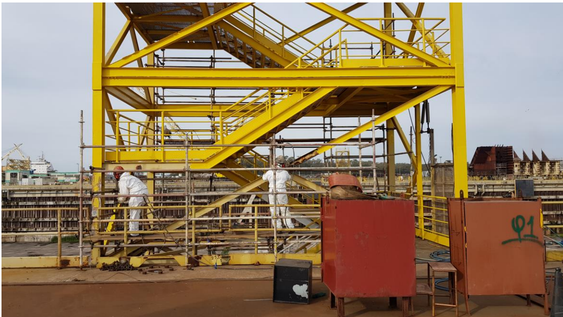
Manutenção Escadas de Acesso
