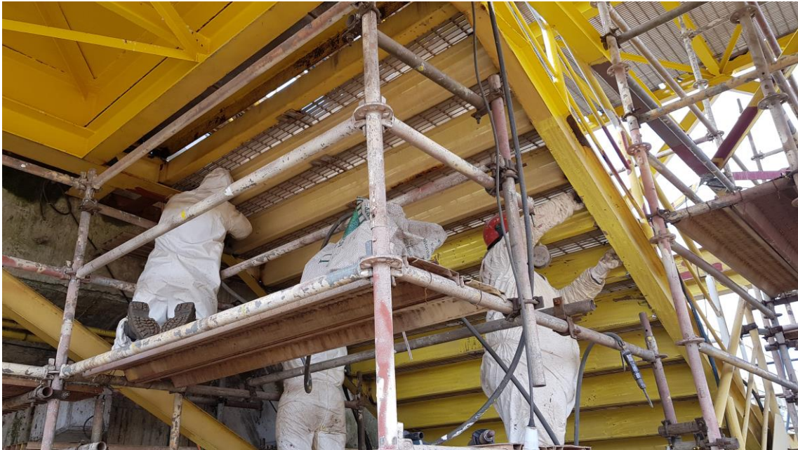
Manutenção Escadas de Acesso
