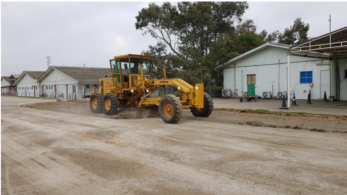
Manutenção Acessos do Estaleiro
