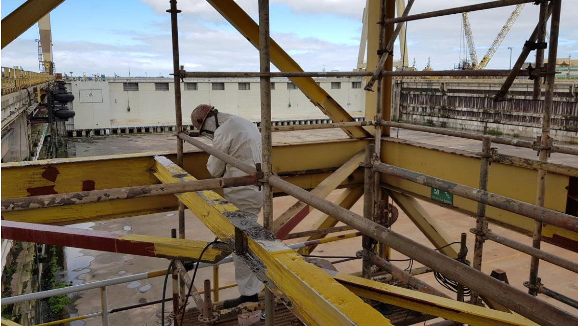
Manutenção Escadas de Acesso
