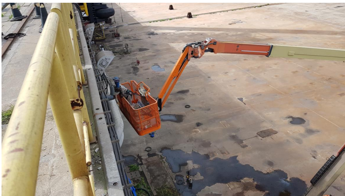
Manutenção Sistema de Drenagem Dique
