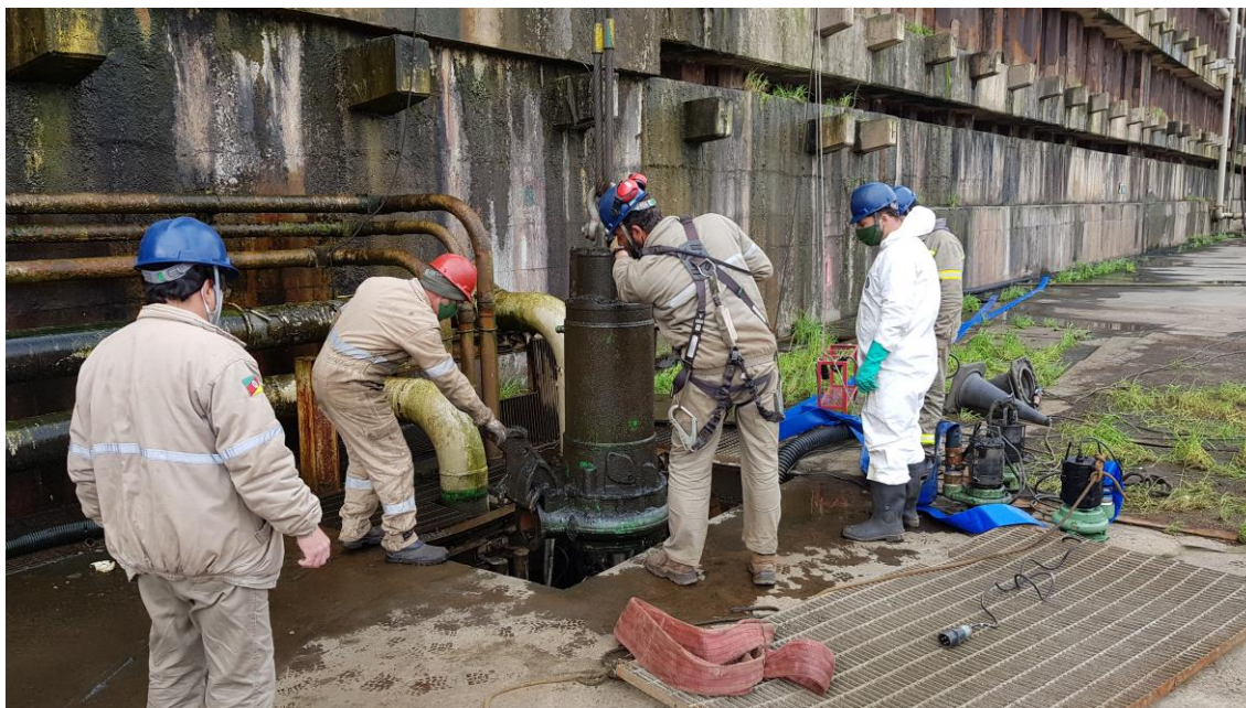
Manutenção Sistema de Drenagem Dique
