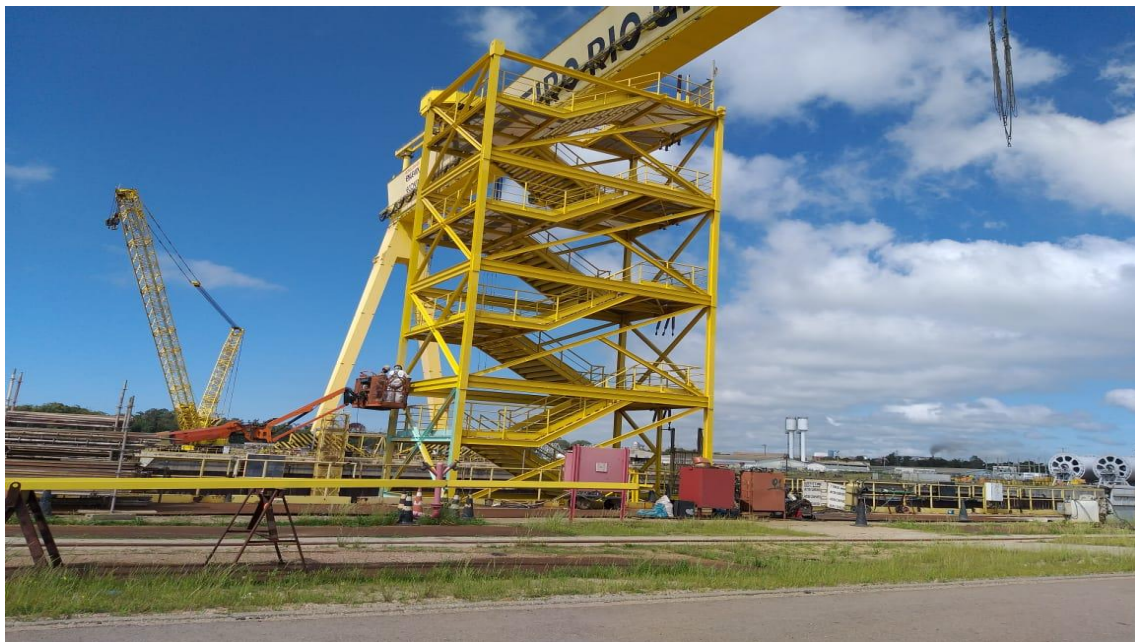
Manutenção escada de acesso
