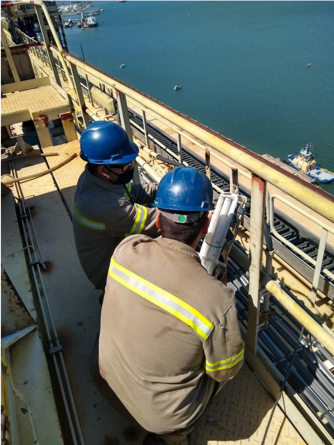
Manutenção Pórtico 600 ton
