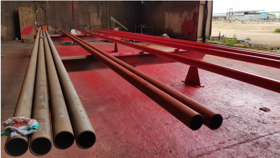
Execução de PPCI – Plano de Prevenção e Proteção Contra Incêndios
