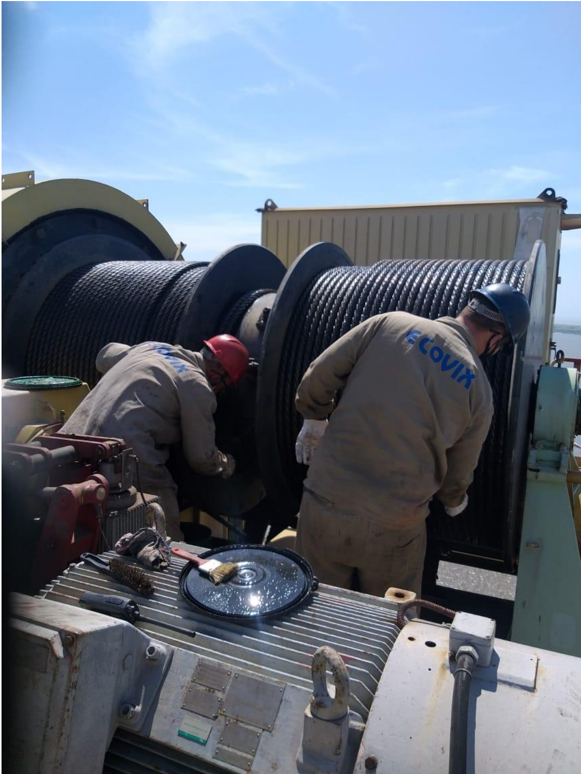
Manutenção Pórtico 600 ton
