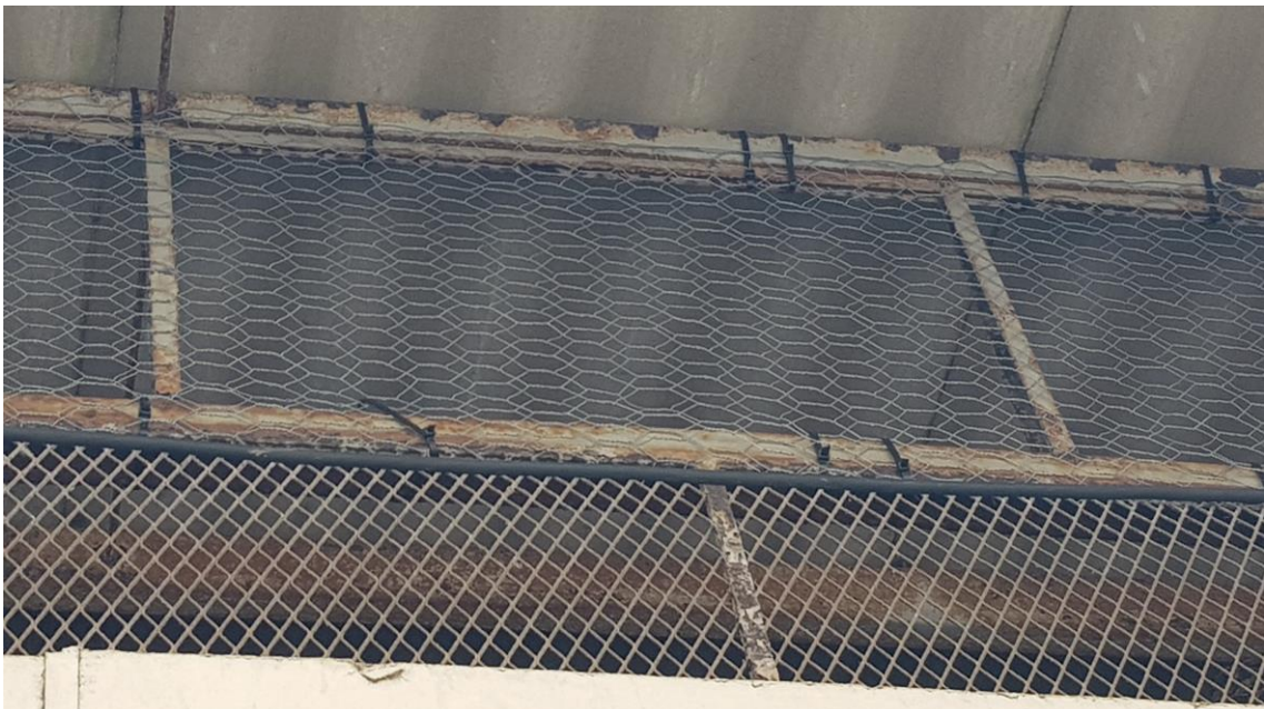
Instalação de proteções contra pombos
