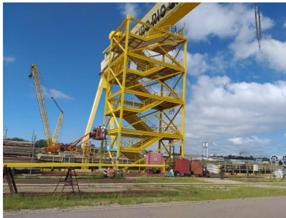
Manutenção Escadas de Acesso
