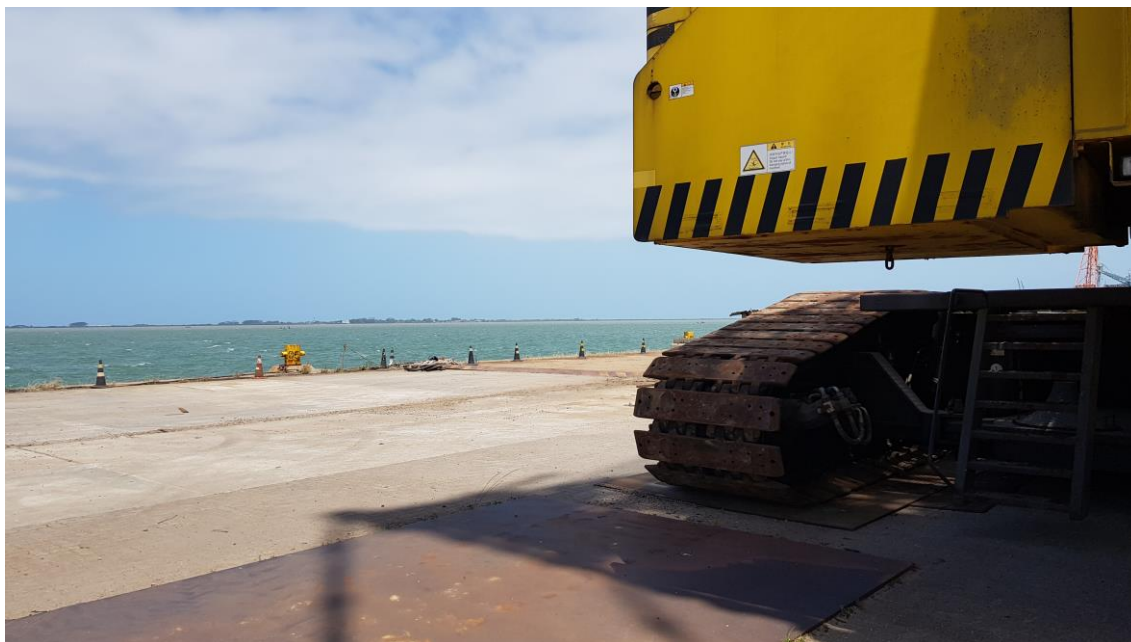
Manutenção Guindaste Sany 750 ton
