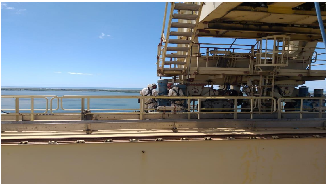
Manutenção Pórtico 600 ton
