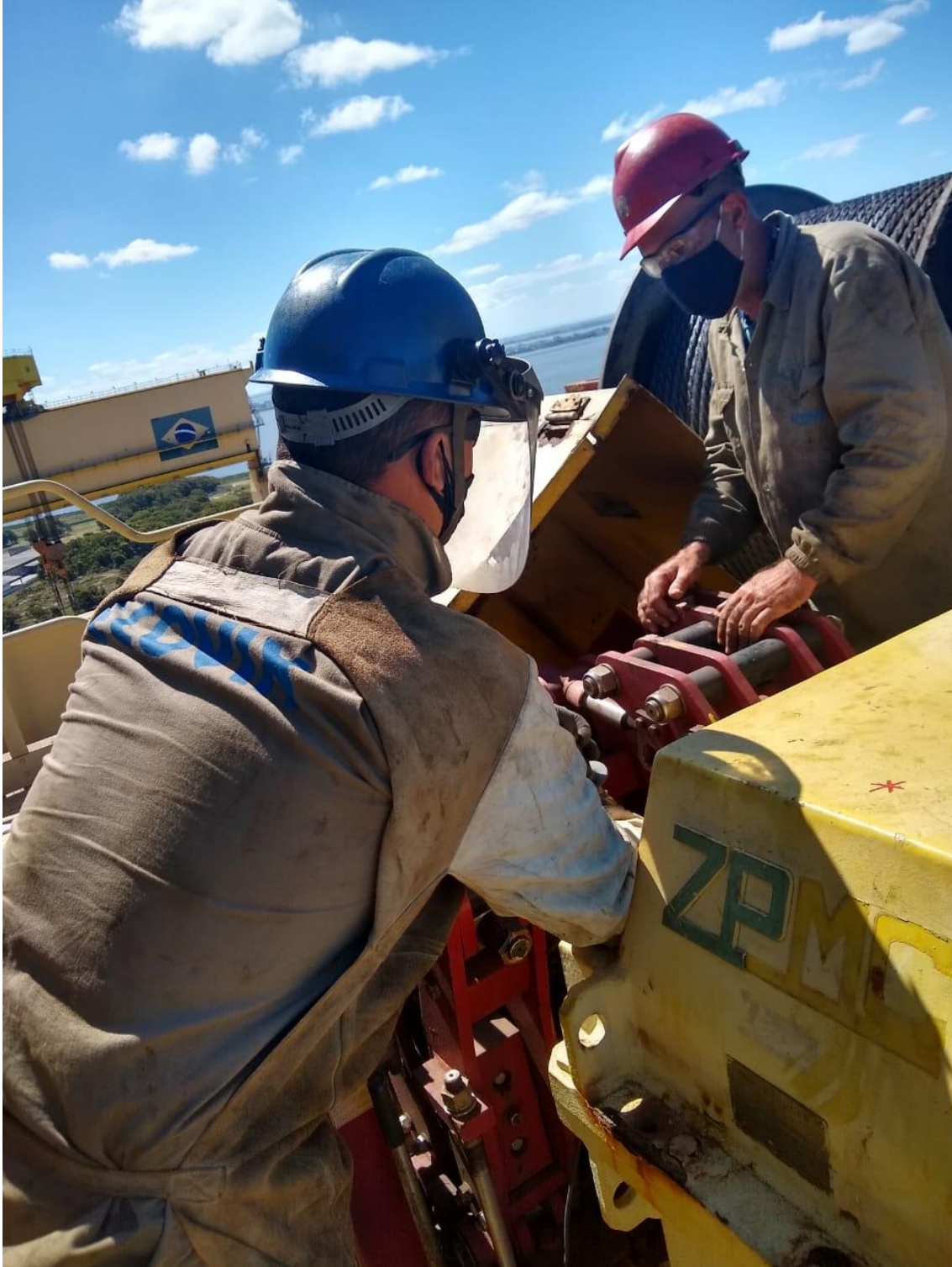
Manutenção Pórtico 600 ton
