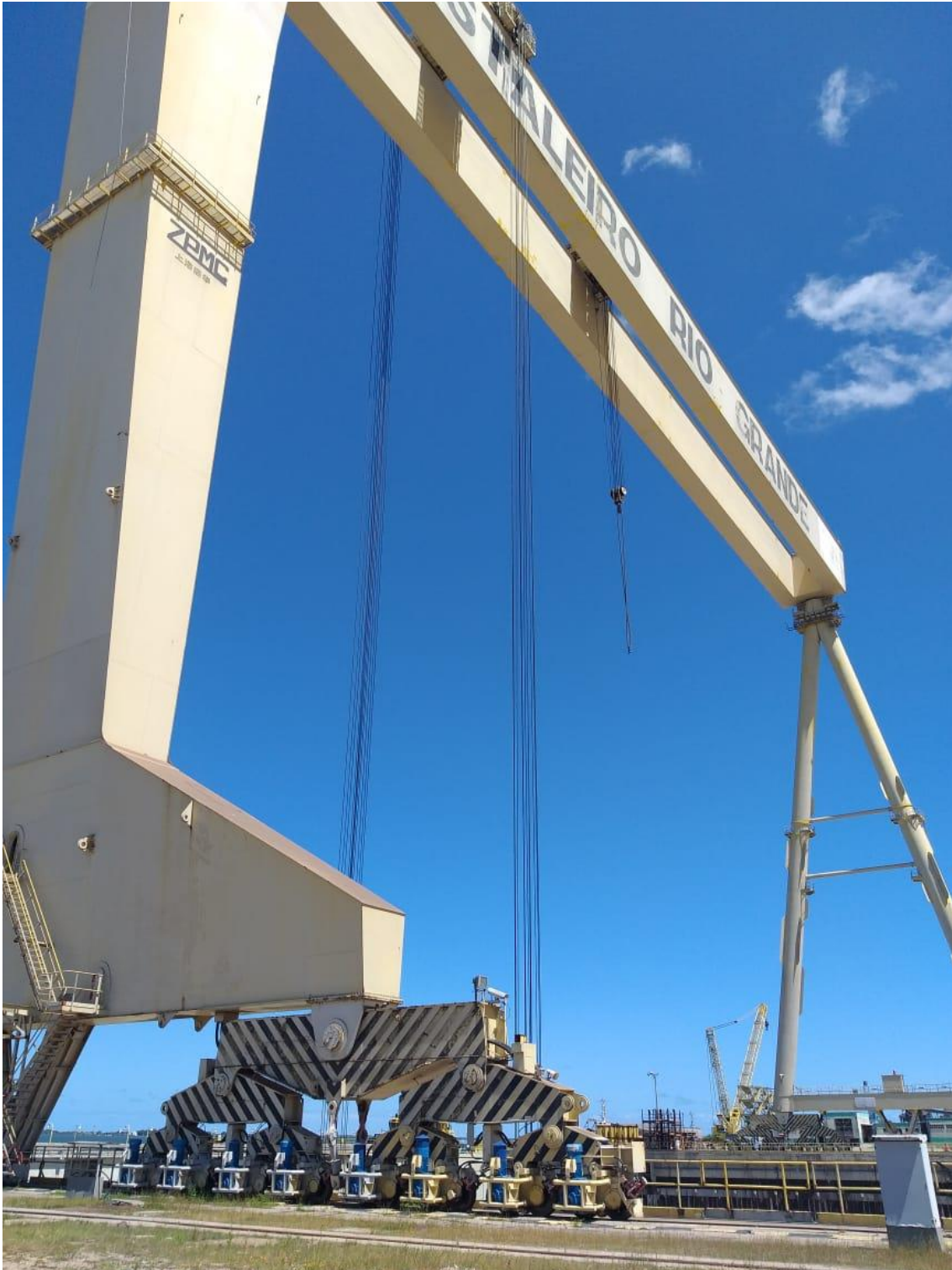
Manutenção Pórtico 600 ton
