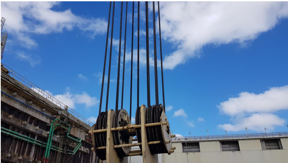
Manutenção Pórtico 600 ton
