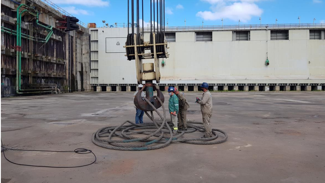
Manutenção Pórtico 600 ton
