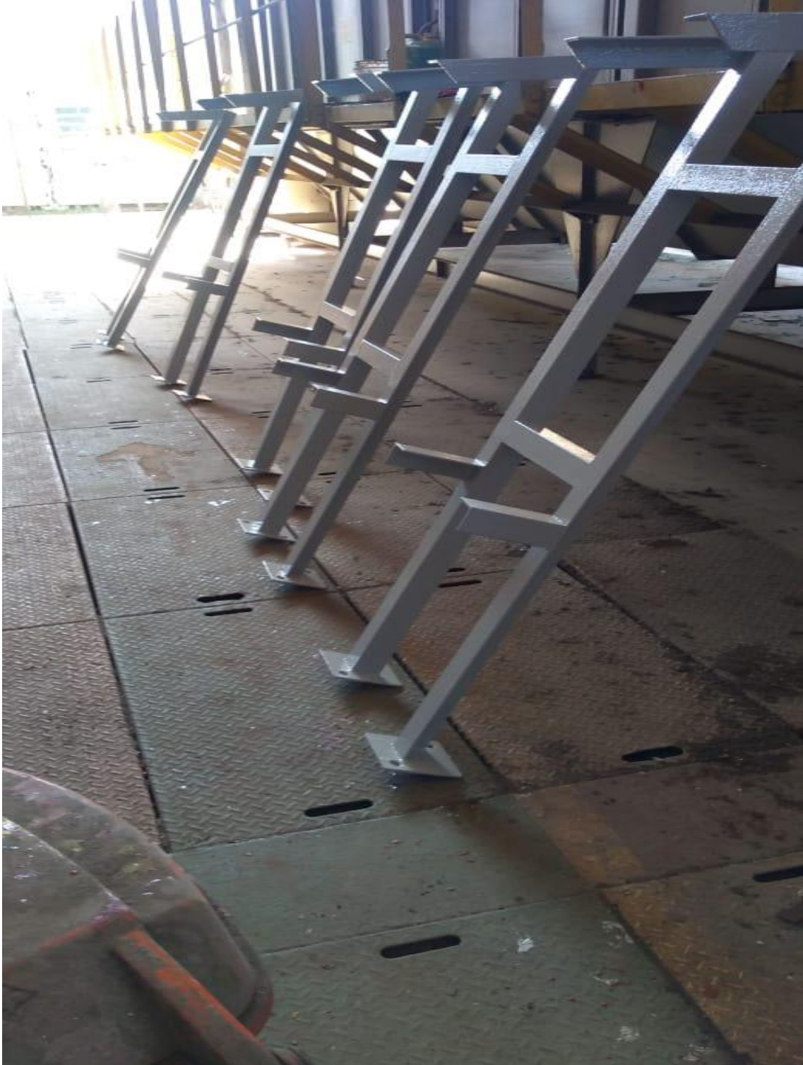
Execução de PPCI – Plano de Prevenção e Proteção Contra Incêndios
