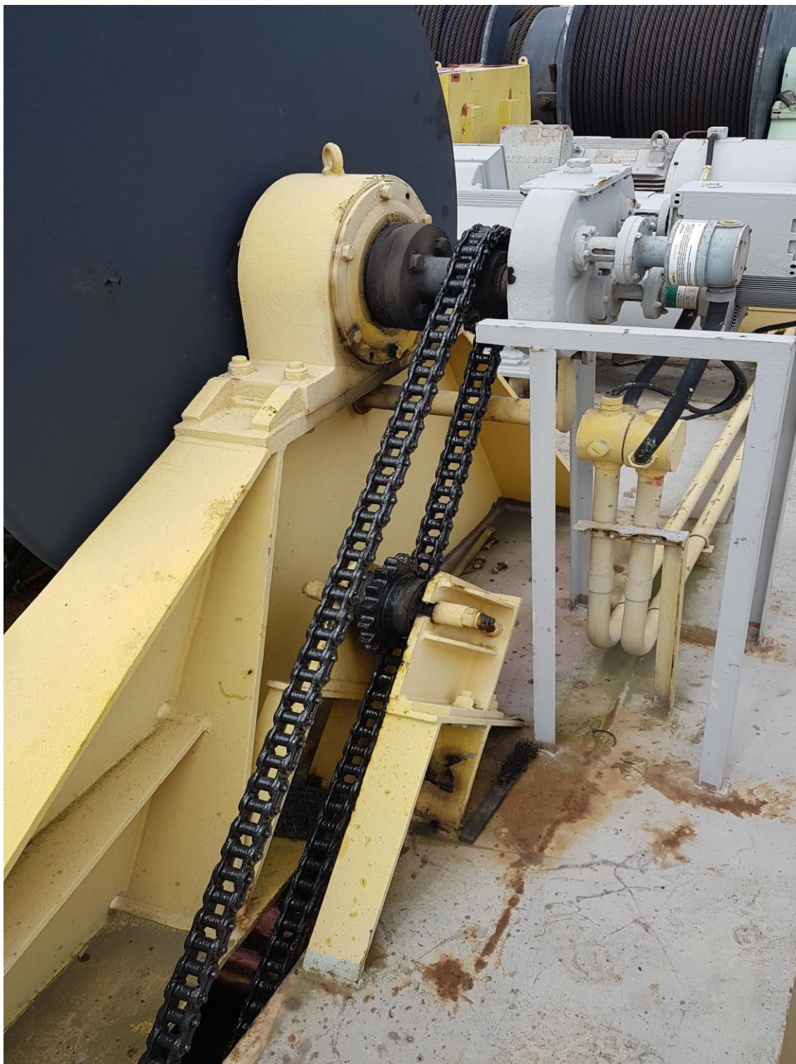
Manutenção Pórtico 600 ton
