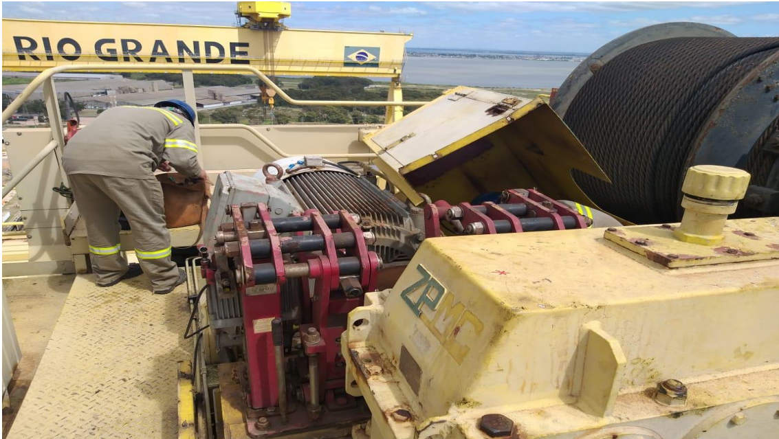
Manutenção Pórtico 600 ton
