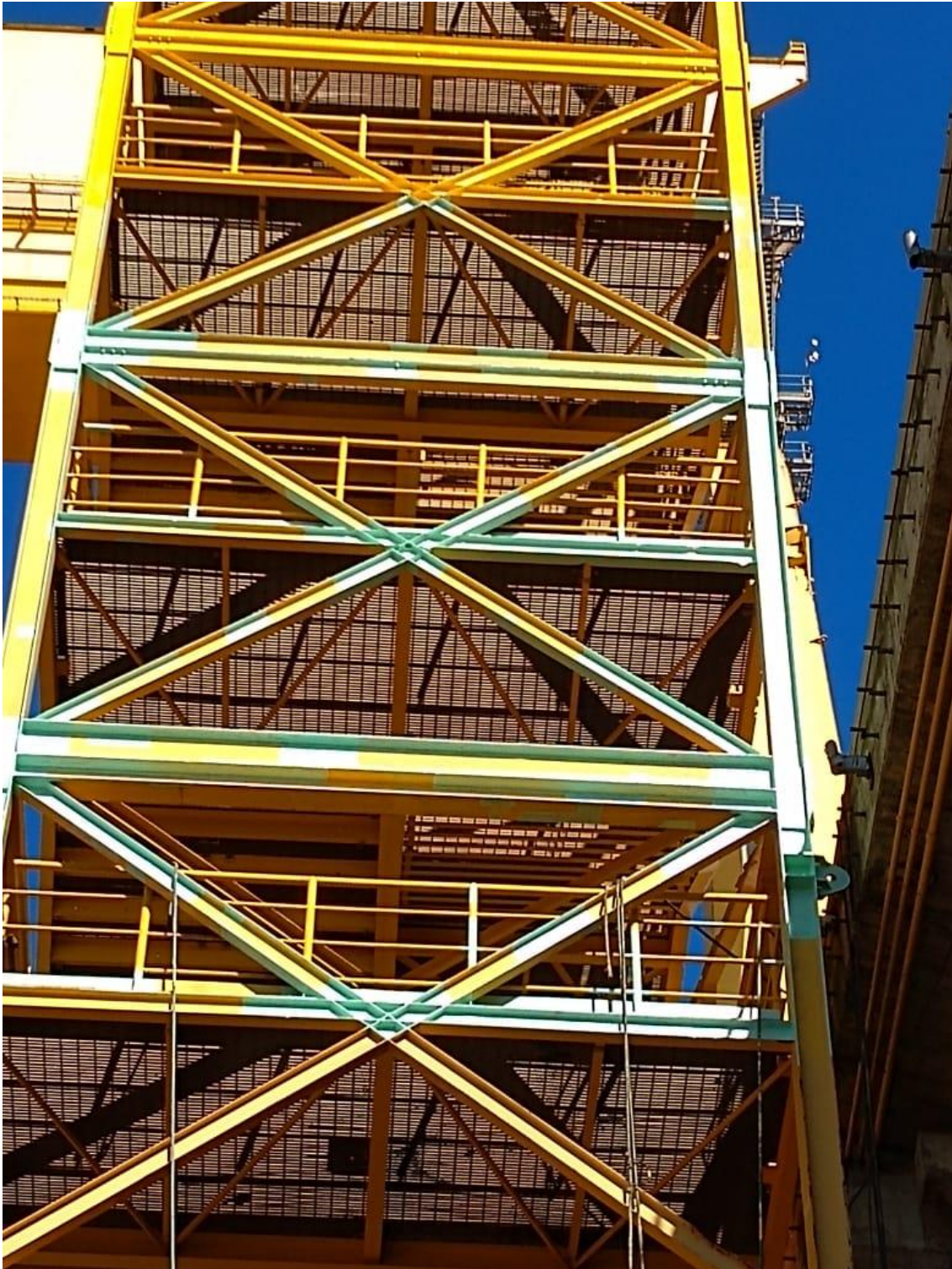
Manutenção escada de acesso
