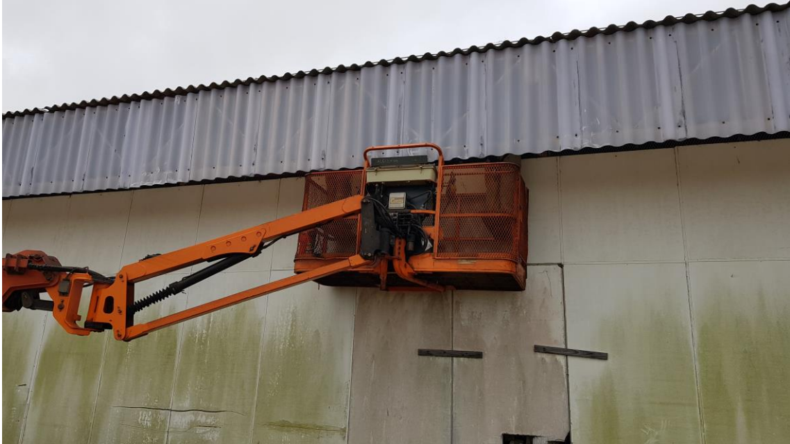
Instalação de proteções contra pombos
