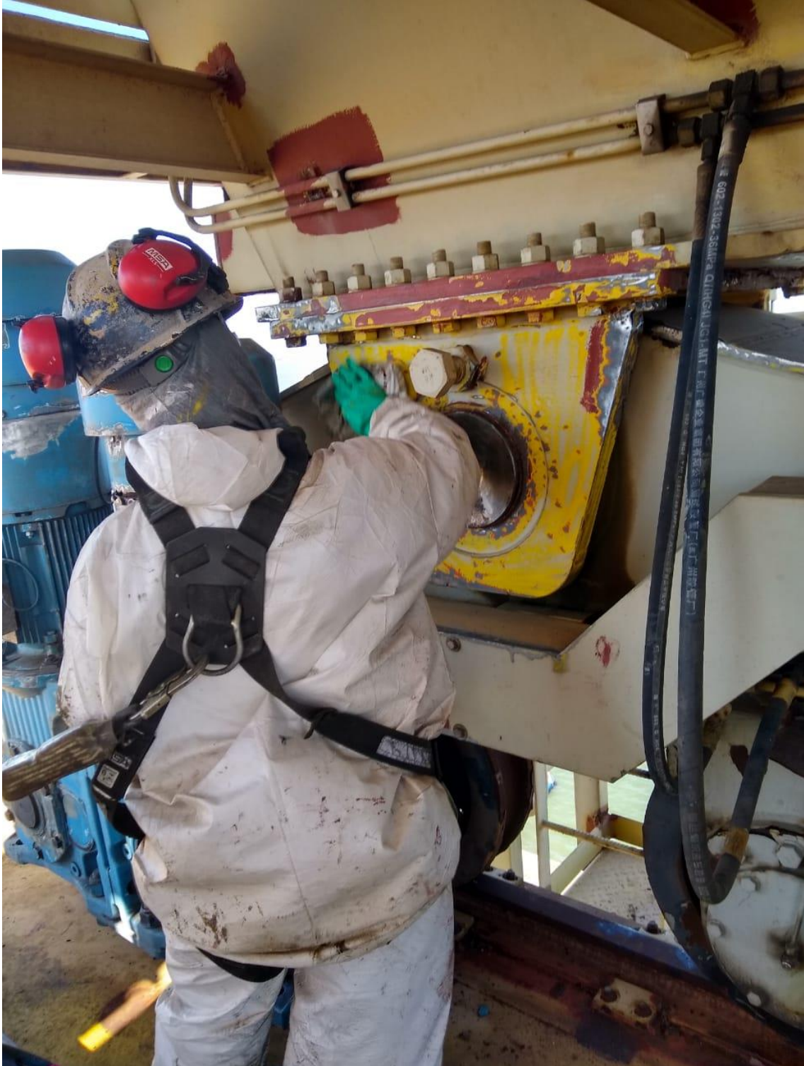
Manutenção Pórtico 600 ton
