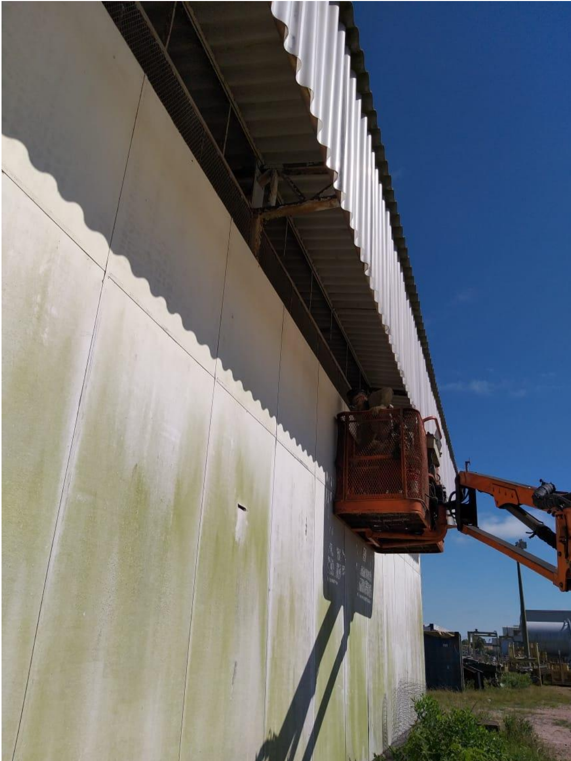
Instalação de proteções contra pombos
