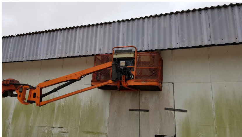
Instalação de proteções contra pombos
