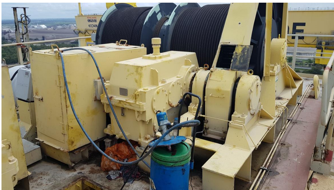
Manutenção Pórtico 600 ton
