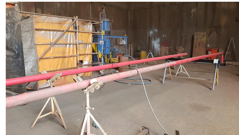
Execução de PPCI
