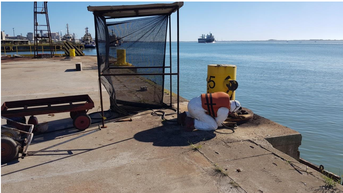
Tratamento e pintura de estruturas
