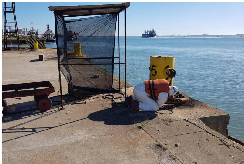
Tratamento e Pintura de Estruturas
