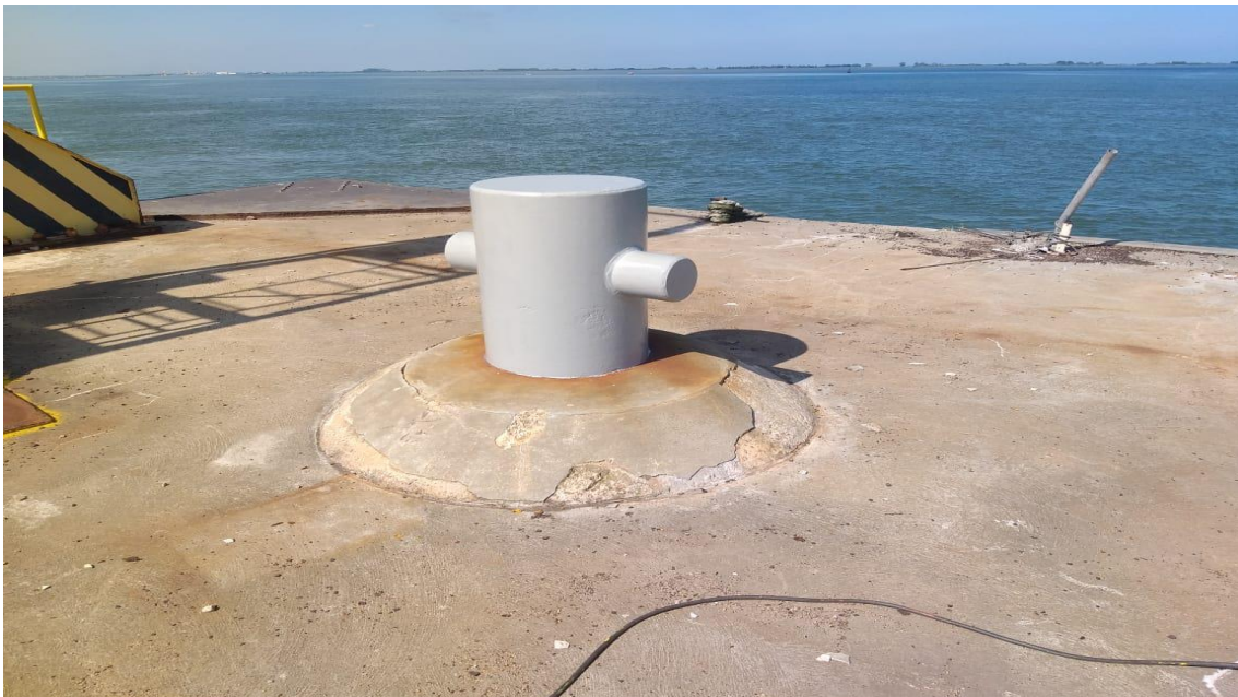
Tratamento e pintura de estruturas
