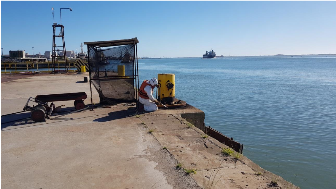
Tratamento e pintura de estruturas
