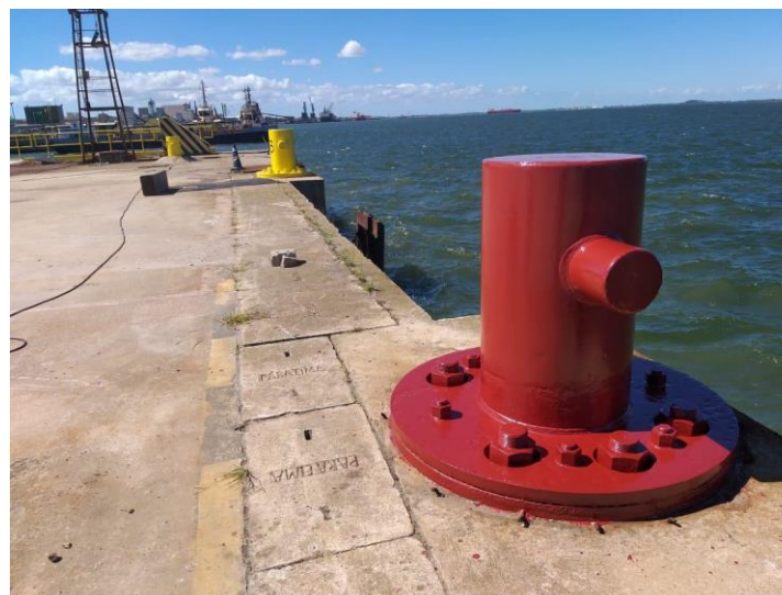
Tratamento e Pintura de Estruturas
