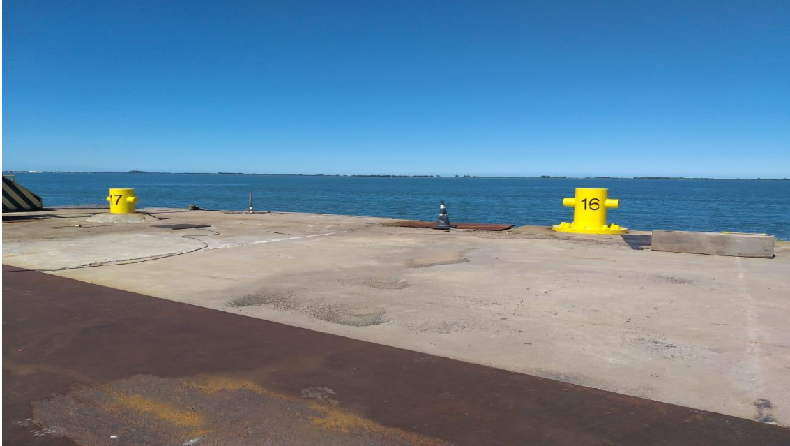
Tratamento e pintura de estruturas
