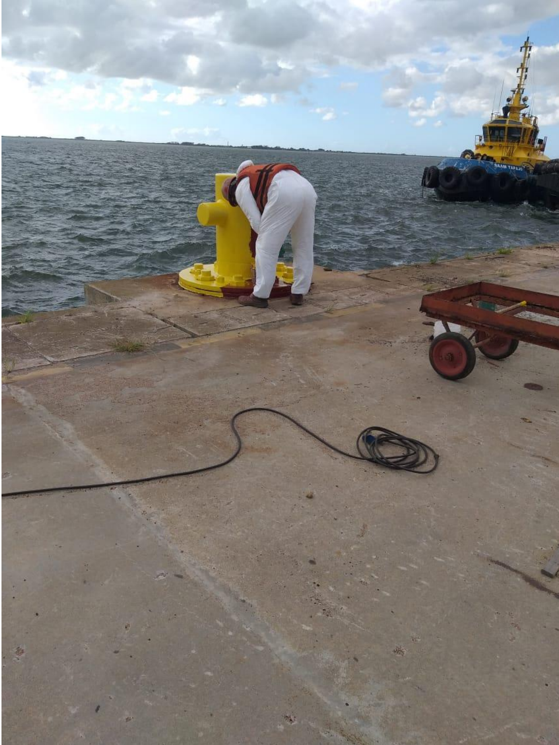
Tratamento e pintura de estruturas
