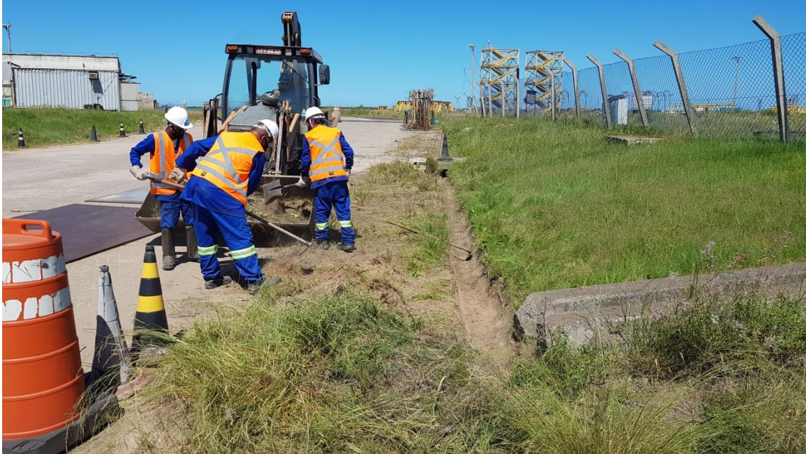
Organização e limpeza de área – Drenagem
