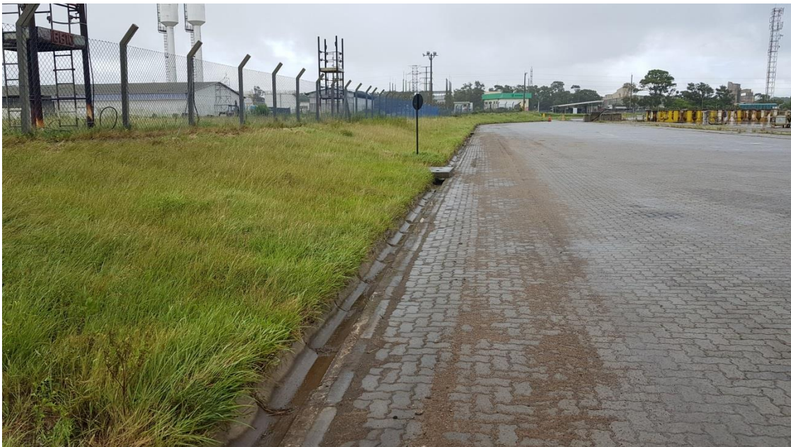
Organização e limpeza de área – Drenagem
