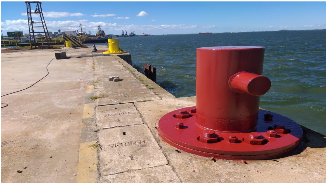
Tratamento e pintura de estruturas
