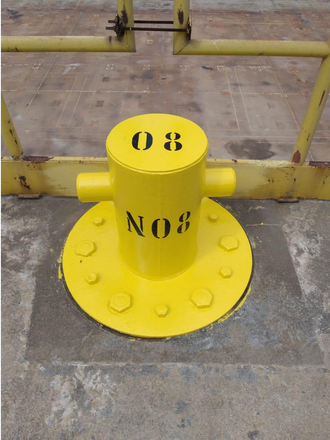
Tratamento e pintura de estruturas
