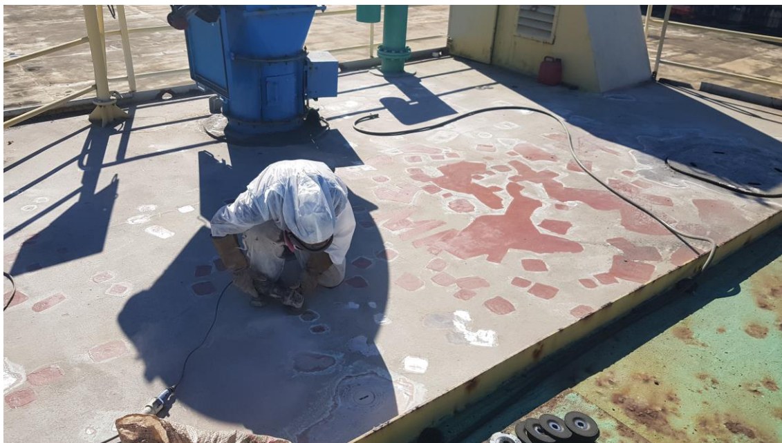
Manutenção Equipamentos – Porta Batel
