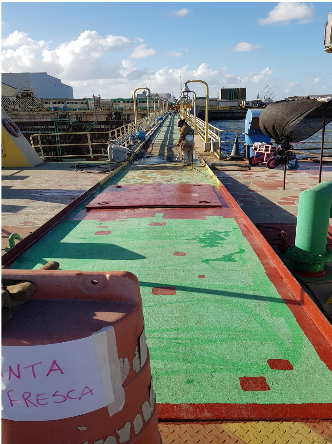
Manutenção Equipamentos – Porta Batel
