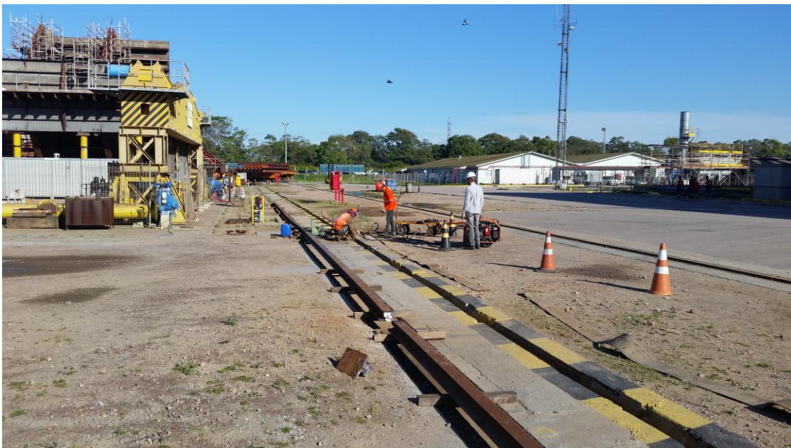
Finalização Pórtico Trilho 600 ton
