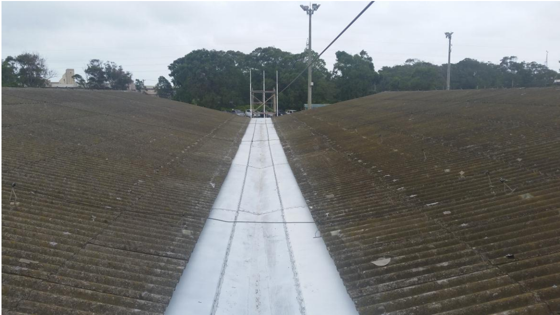
Manutenção Calhas Prédio Administrativo
