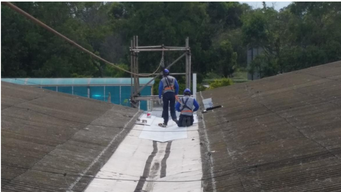
Manutenção Calhas Prédio Administrativo
