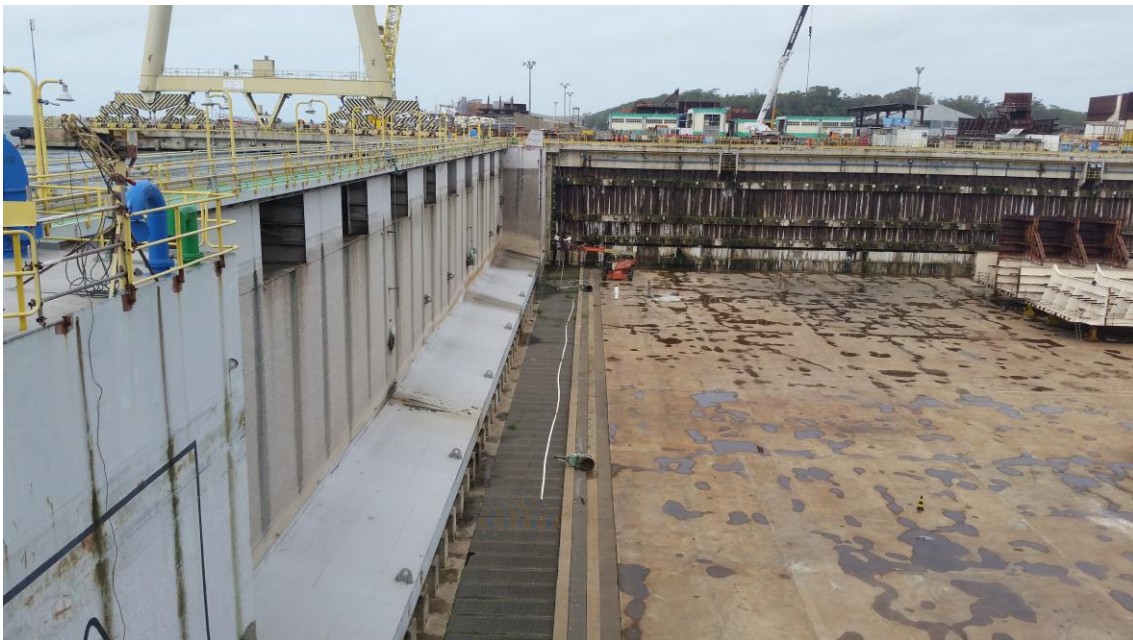
Manutenção Porta Batel
