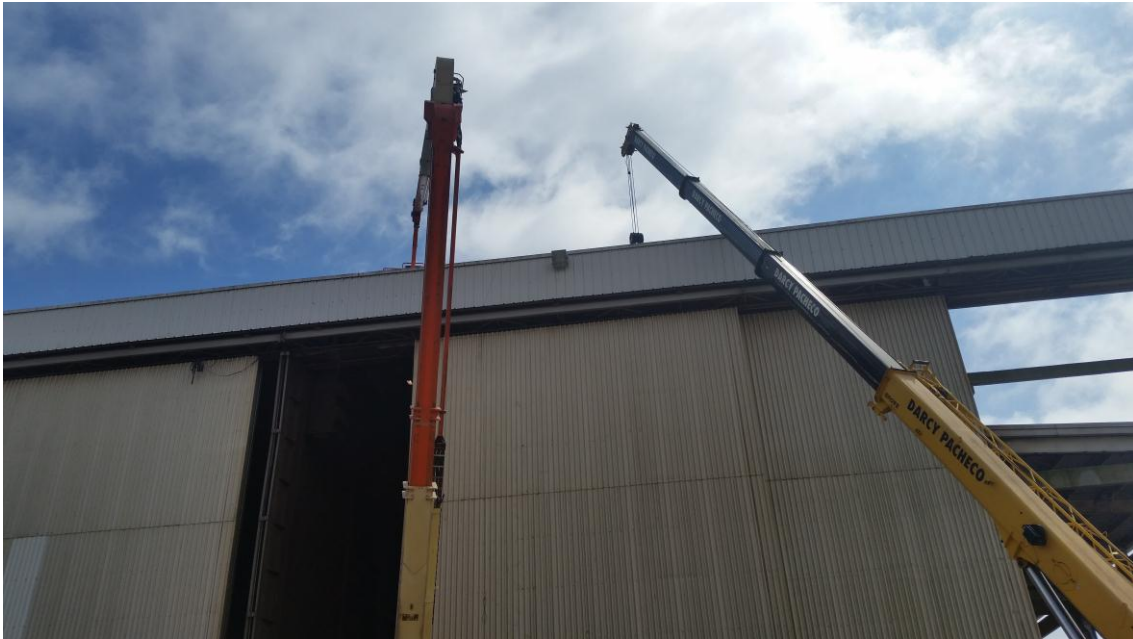
Manutenção Telhados – ERENGE
