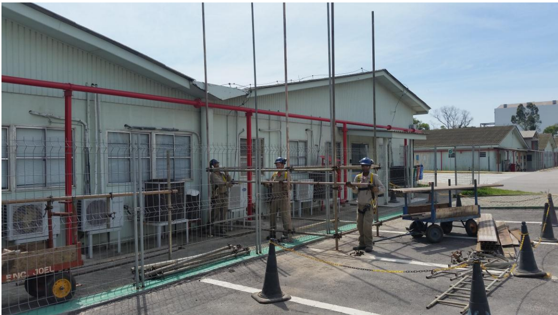
Manutenção Calha Prédio Administrativo
