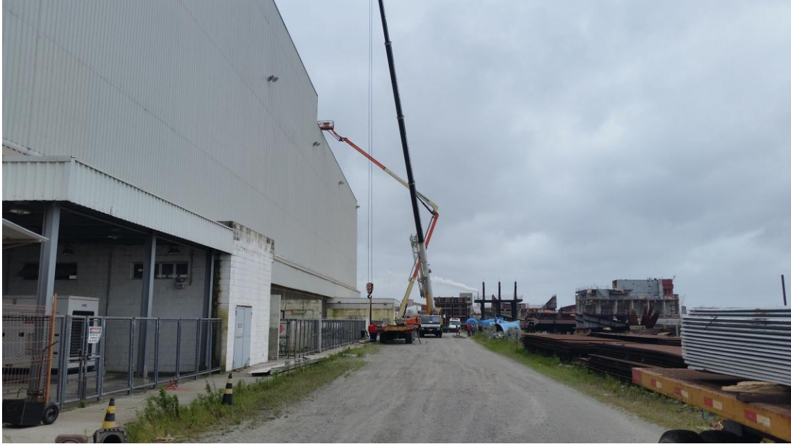
Manutenção Telhados – ERENGE
