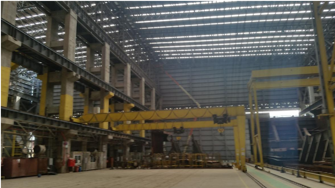
Manutenção Telhados – ERENGE
