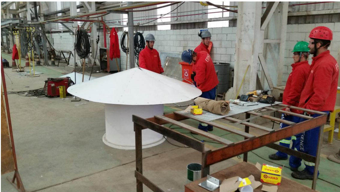
Manutenção Telhados – ERENGE
