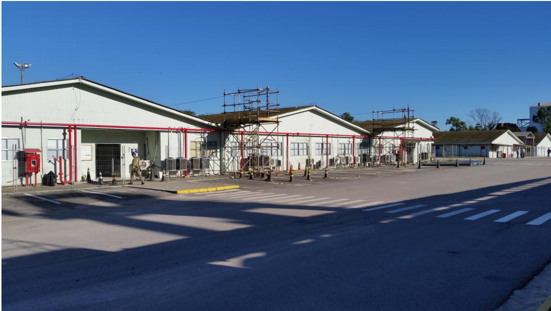
Manutenção Calhas Prédio Administrativo
