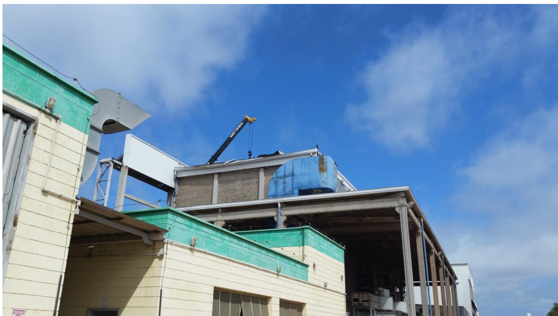
Manutenção Telhados – ERENGE
