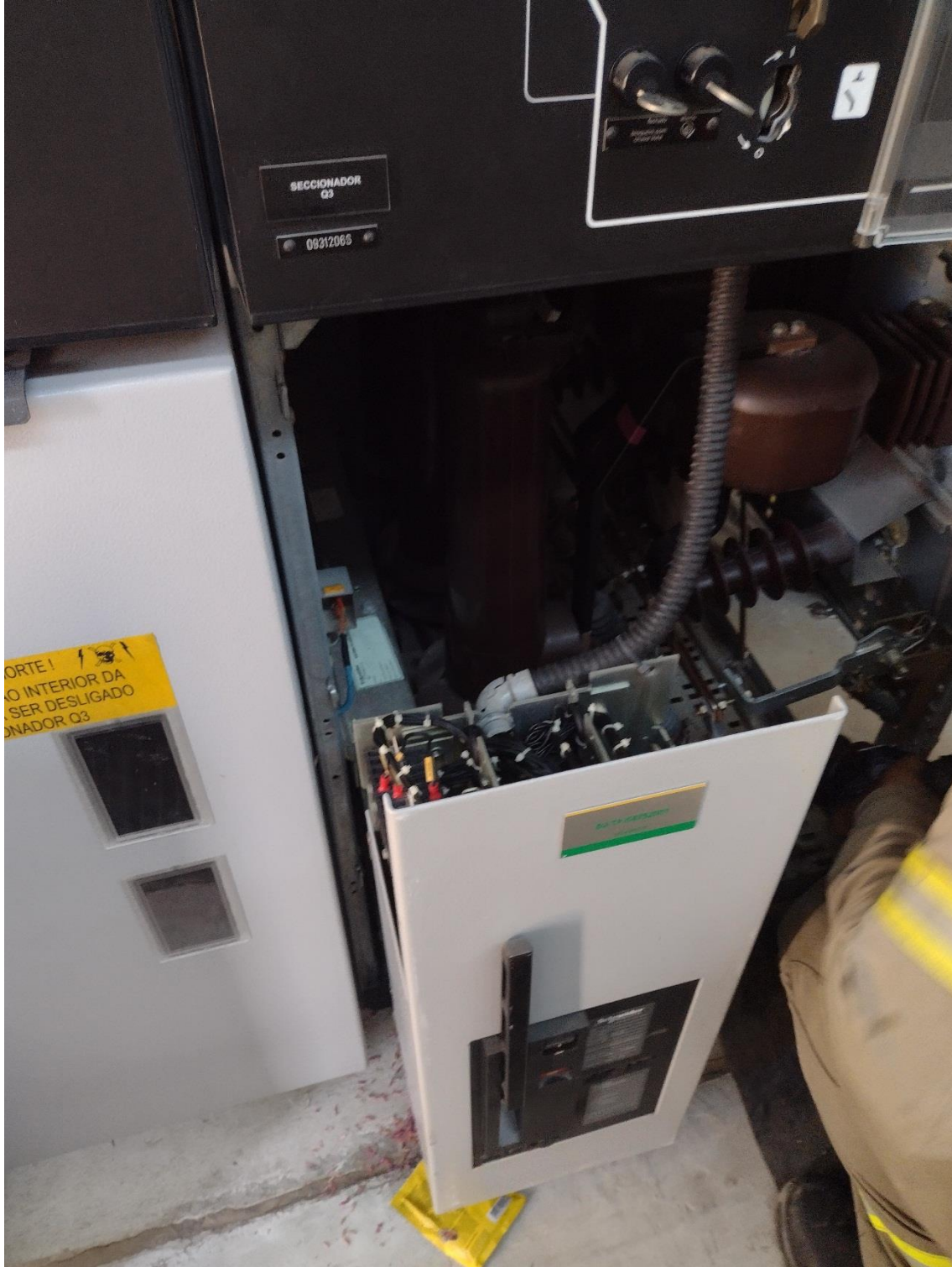
Manutenção de Equipamentos e Estruturas
