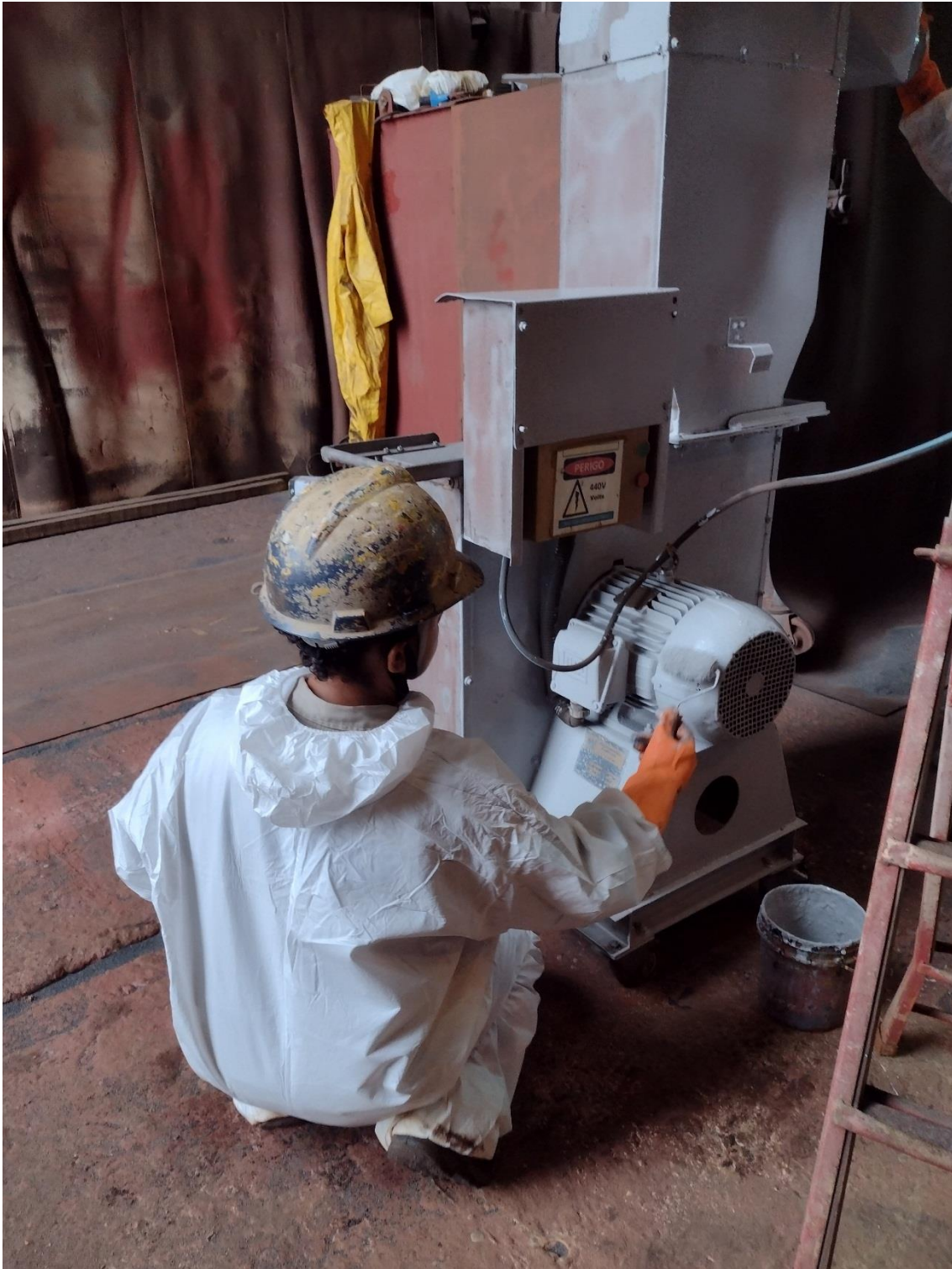
Manutenção de Equipamentos e Estruturas
