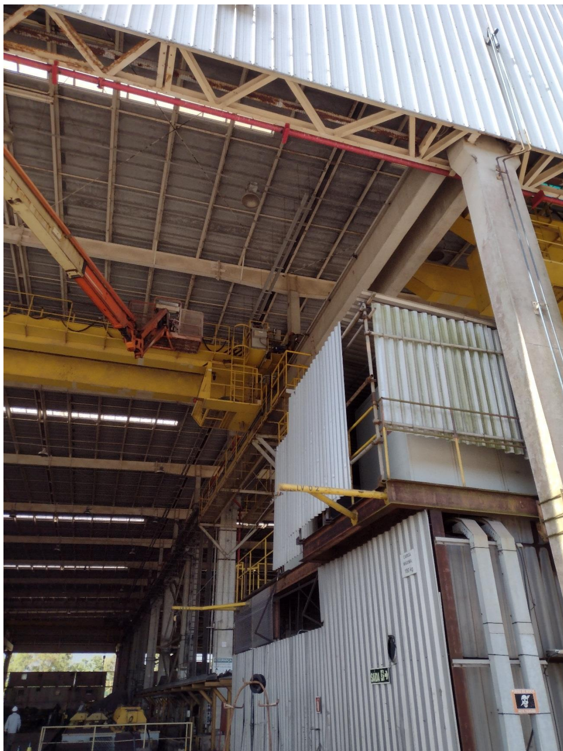
Manutenção de Equipamentos e Estruturas
