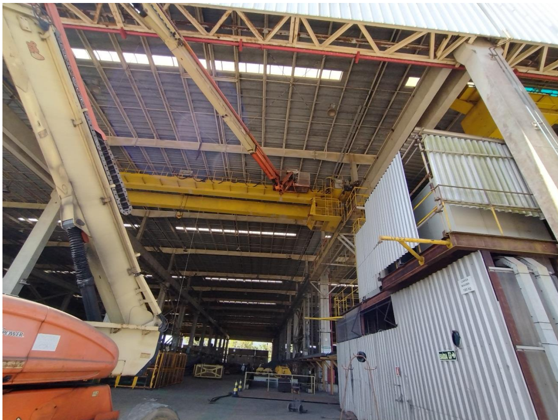
Manutenção de Equipamentos e Estruturas
