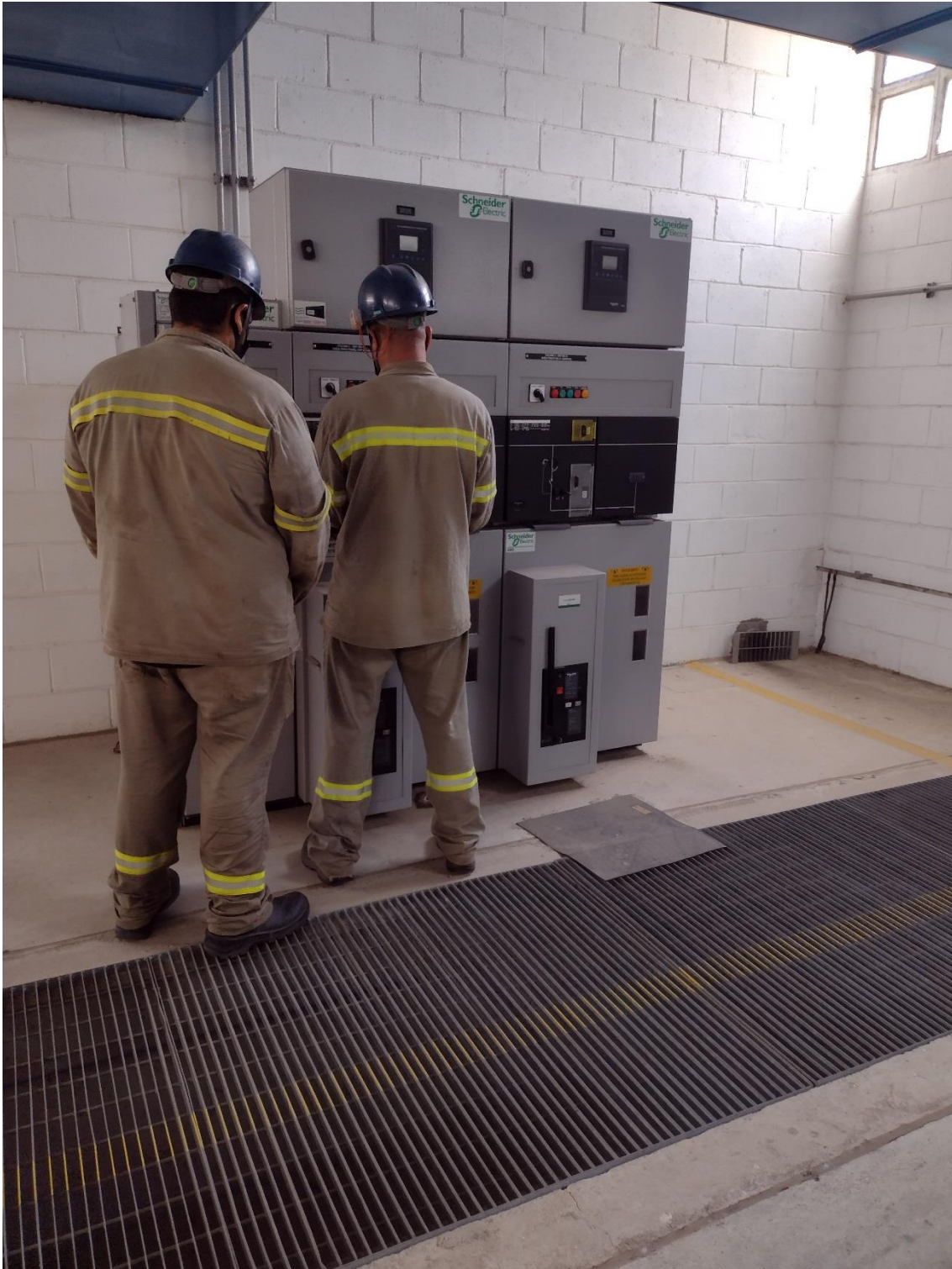
Manutenção de Equipamentos e Estruturas
