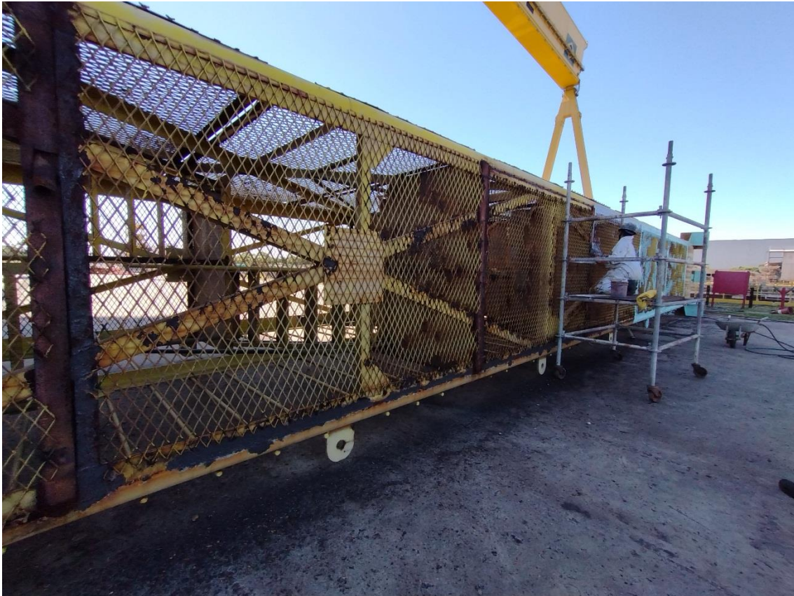
Manutenção de Equipamentos e Estruturas
