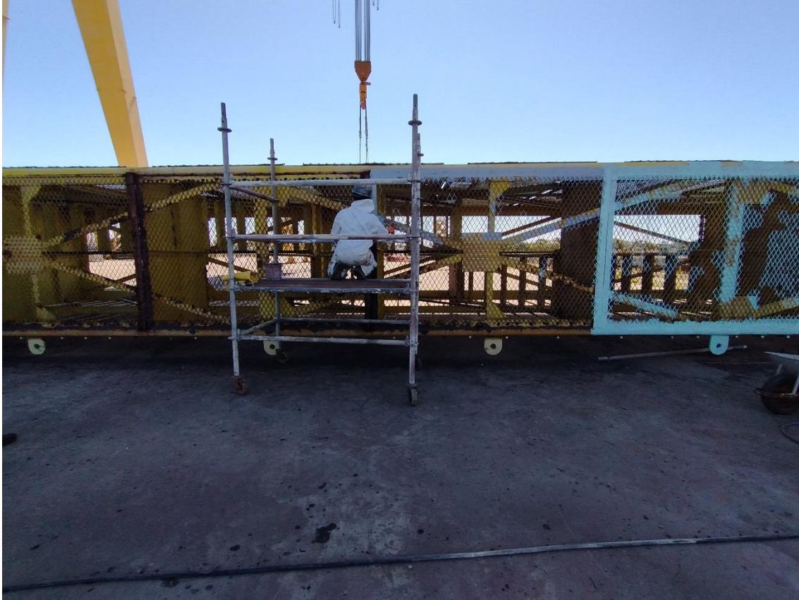
Manutenção de Equipamentos e Estruturas
