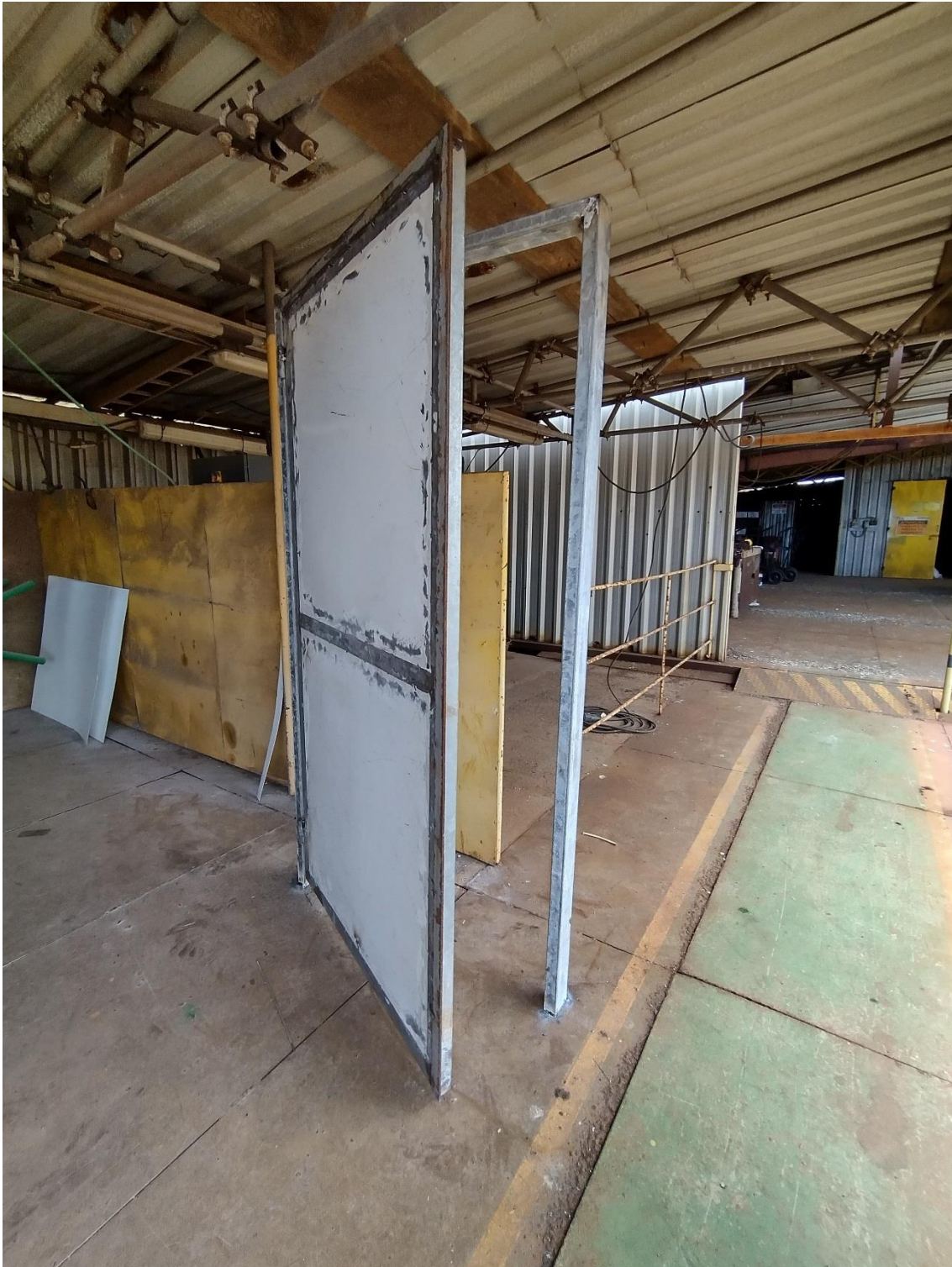
Manutenção de Equipamentos e Estruturas
