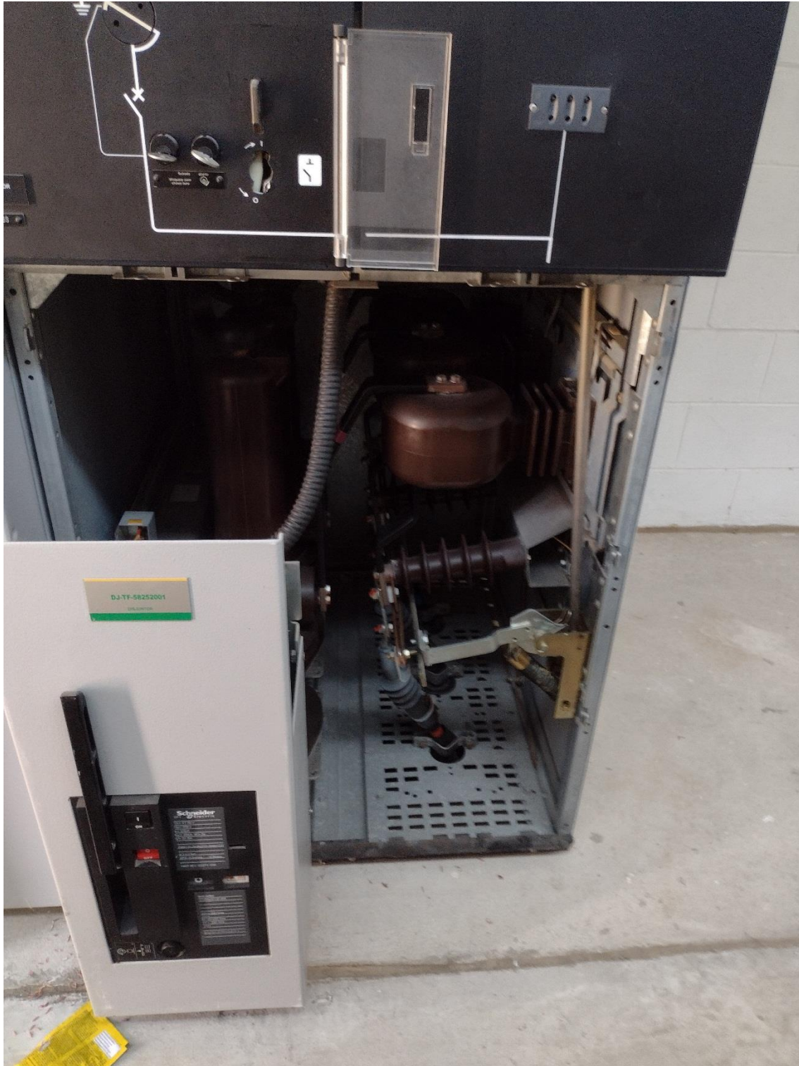
Manutenção de Equipamentos e Estruturas
