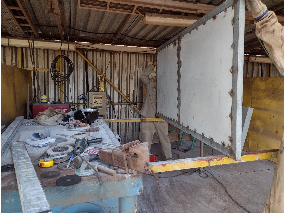
Manutenção de Equipamentos e Estruturas
