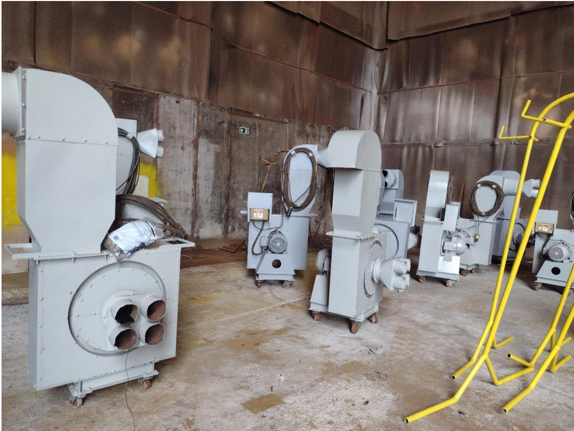
Manutenção de Equipamentos e Estruturas
