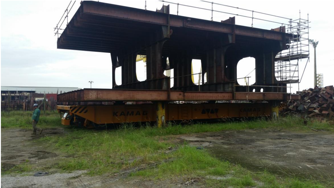
Movimentação de blocos Kamag – Corte P72
