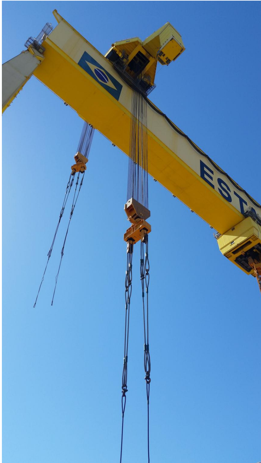
Preservação Pórtico 2000 ton
