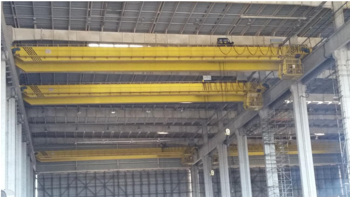
Manutenção Pontes Oficinas
