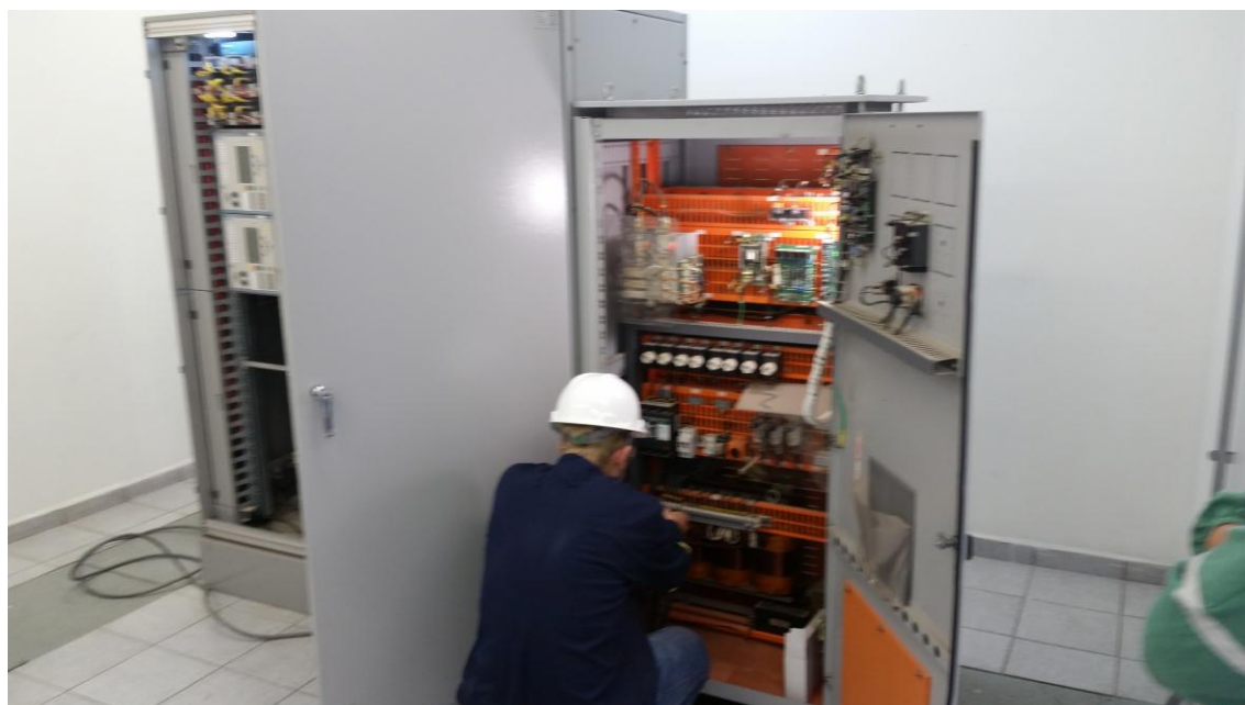
Manutenção Subestação Principal
