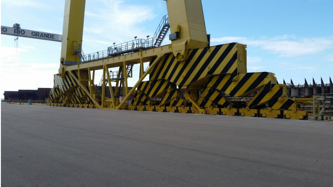
Preservação e Manutenção Pórtico 2000 ton e 600 ton.
