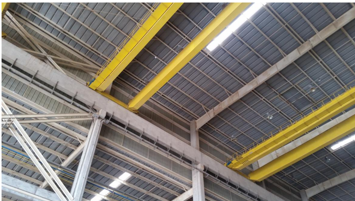
Manutenção Pontes Oficinas
