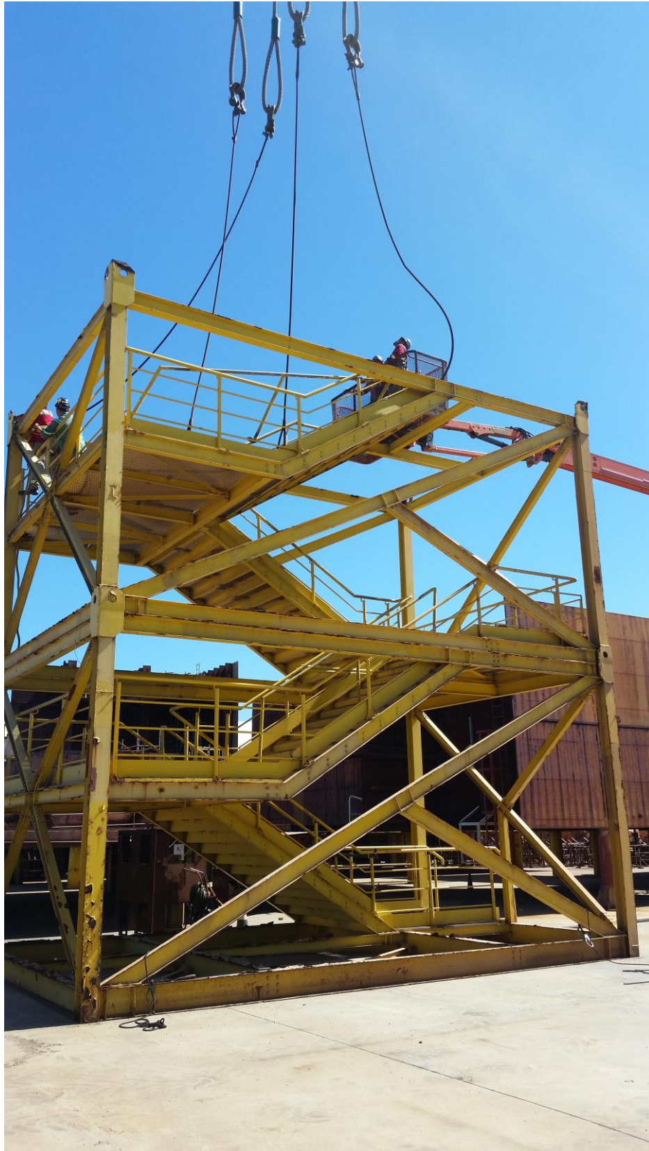
Movimentação Pórtico 2000 ton
