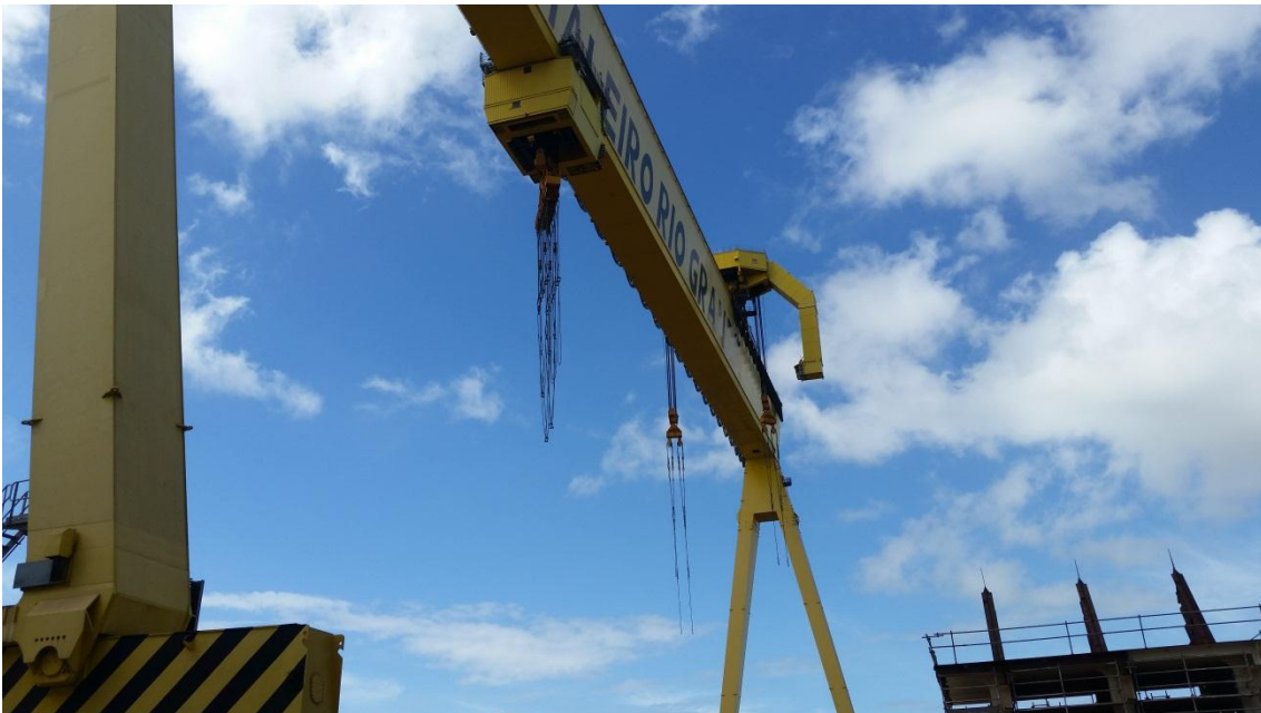
Preservação e Manutenção Pórtico 2000 ton e 600 ton.
