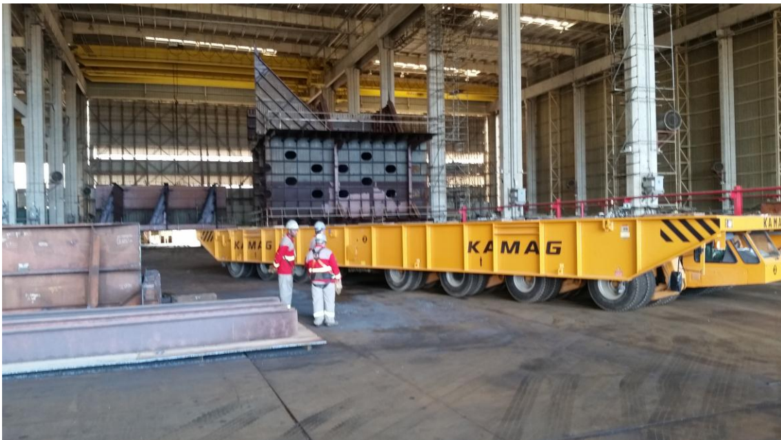
Movimentação de blocos Kamag – Corte P72
