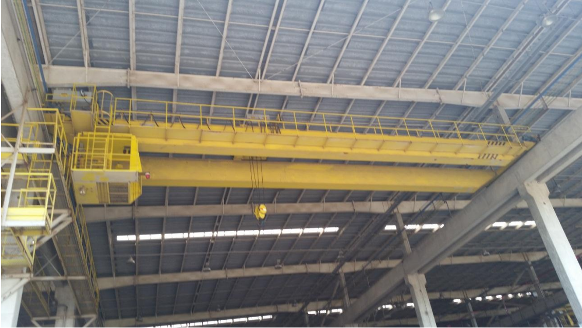
Manutenção Pontes Oficinas
