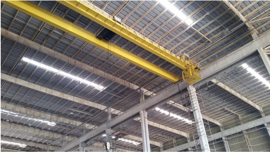
Manutenção Pontes Oficinas
