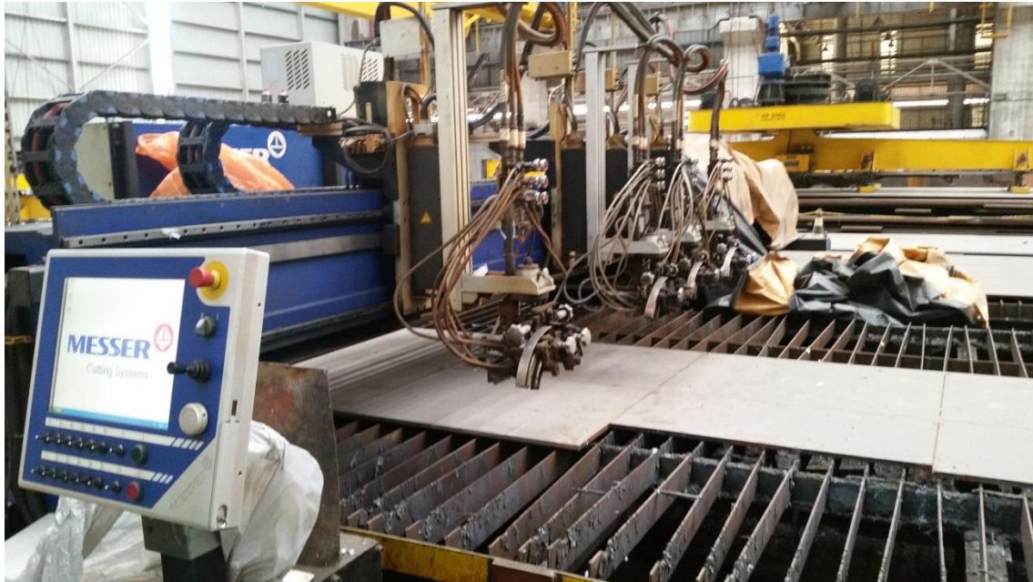
Manutenção Equipamentos Corte – Oficinas ERG 2
