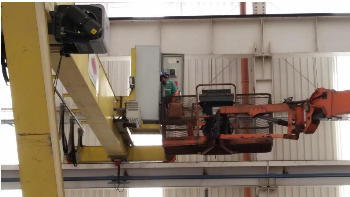
Manutenção Semi-Pórticos
