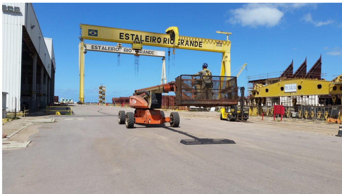
Manutenção Plataforma Elevatória – PTA
