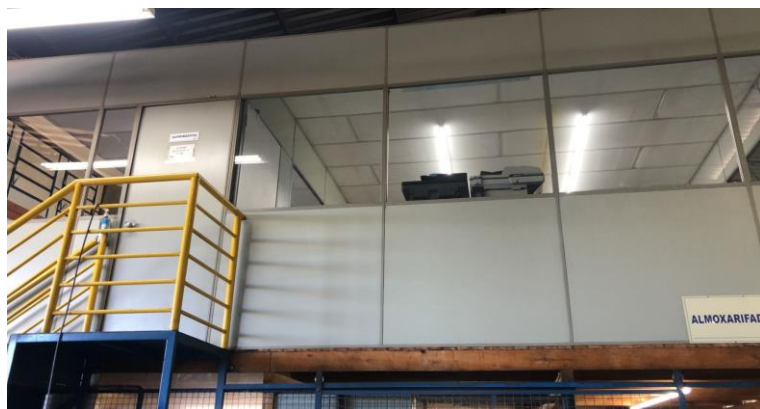
Sala de suprimentos, engenharia e outros serviços indiretos
