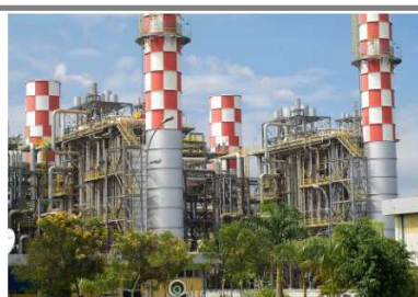
EDF Norte Fluminense Macaé / RJ
