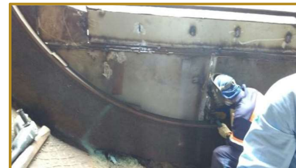
Soldagem de trincas na entrada do Tambor
