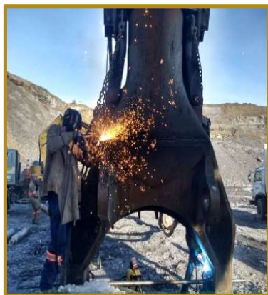
Processo de eliminação da trinca
