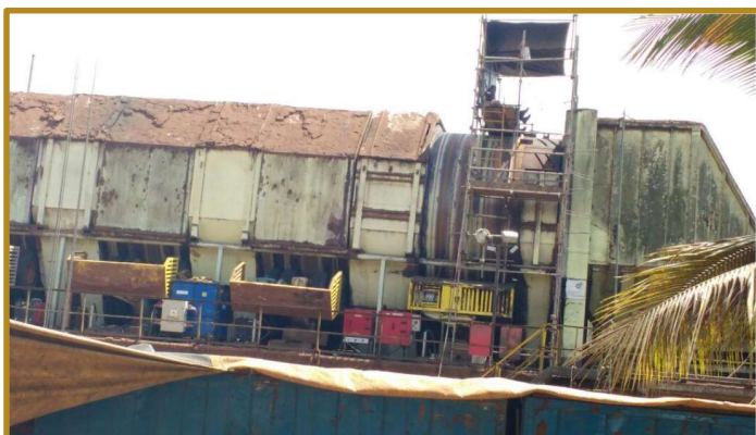
Vista de Tambor Descascador de Toras
