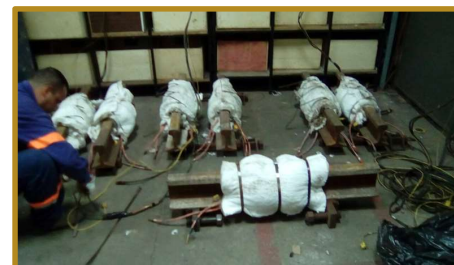
Montagem de Resistências Elétricas e Isolamento Térmico
