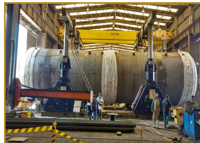
Montagem de Isolamento Térmico
