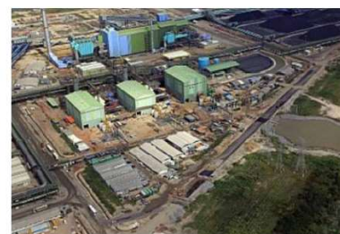
Thyssen Krupp / CSA Rio de Janeiro / RJ
