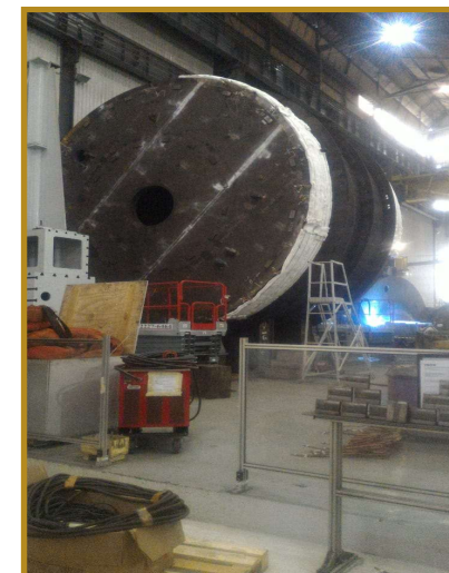
Montagem de Isolamento Térmico
