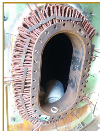
Montagem das Resistências na Janela de Inspeção
