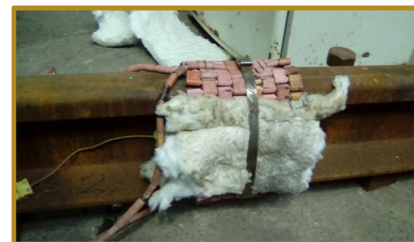
Montagem de Resistências Elétricas e Isolamento Térmico
