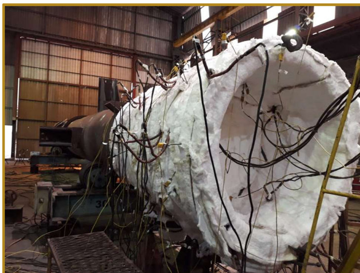
Tratamento Térmico da Solda Corpo / Cabeçote do Trocador de Calor
