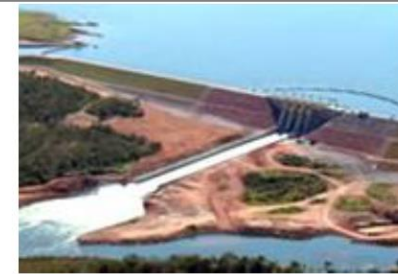
Tractebel - UHE Ponte de Pedra Campinápolis / MT
