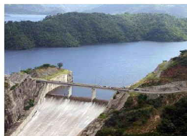
Central Hidroeléctrica de Monción República Dominicana
