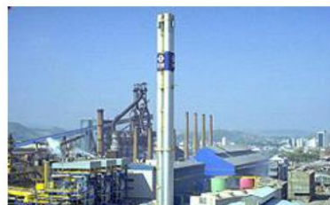
CSN – Central Termelétrica Volta Redonda / RJ
