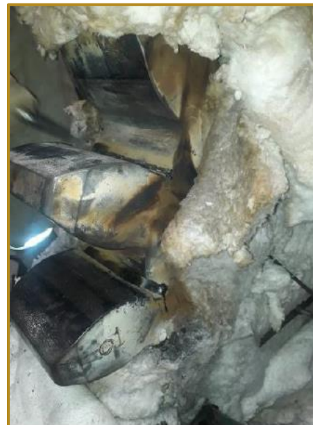
5. Soldagem em fase de finalização
