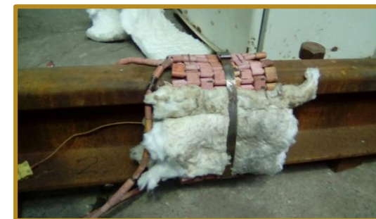
Montagem de Resistências Elétricas e Isolamento Térmico
