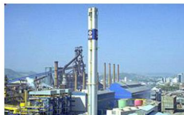
CSN – Central Termelétrica Volta Redonda / RJ
