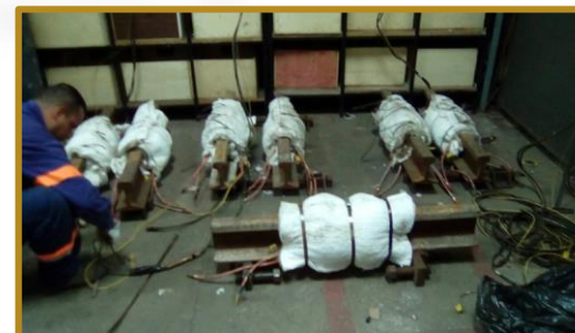
Montagem de Resistências Elétricas e Isolamento Térmico
