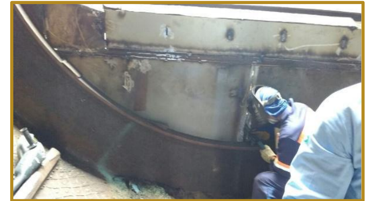
Soldagem de trincas na entrada do Tambor
