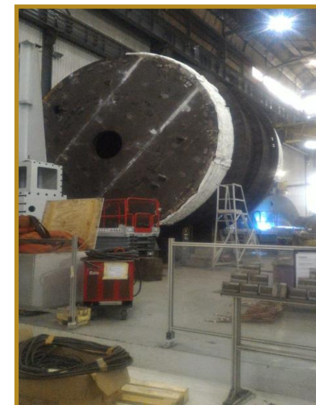
Montagem de Isolamento Térmico
