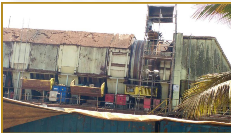
Vista de Tambor Descascador de Toras
