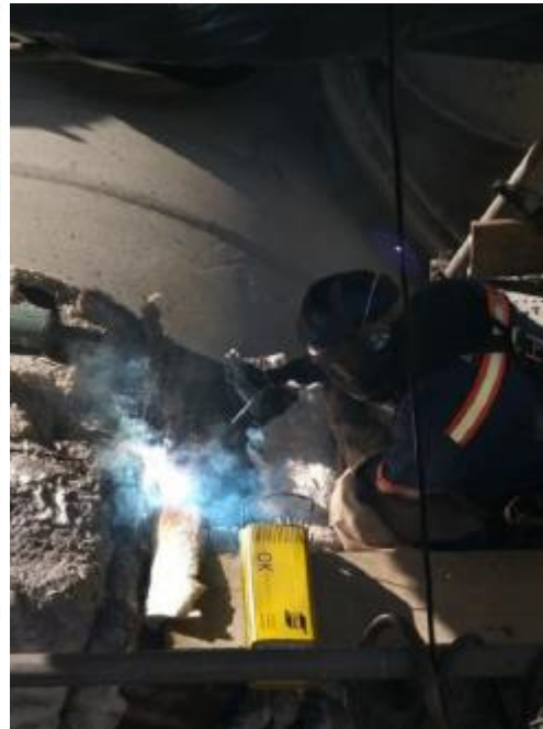
Vista da soldagem da trinca conforme procedimento
