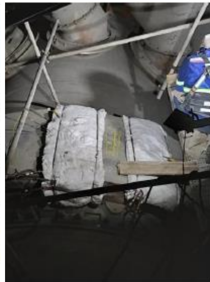
Vista da montagem do sistema de aquecimento
