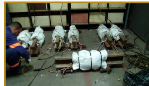
Montagem de Resistências Elétricas e Isolamento Térmico
