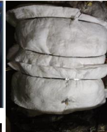
Pós-aquecimento da solda acabada
