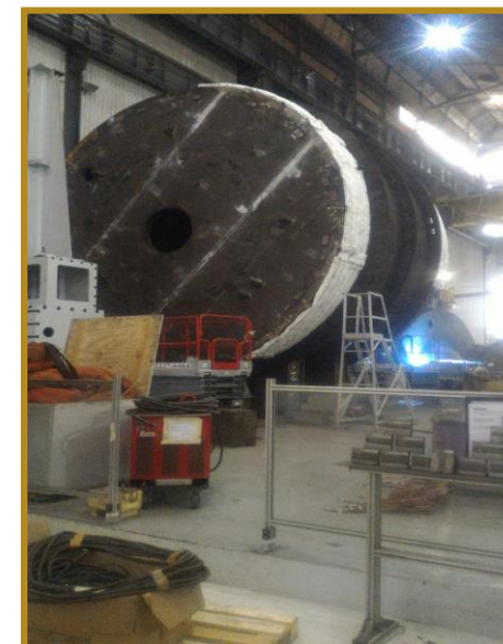
Montagem de Isolamento Térmico
