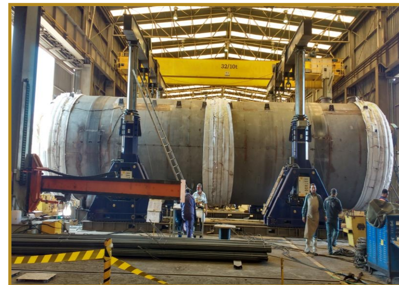
Montagem de Isolamento Térmico
