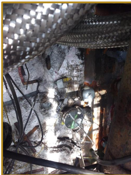
Montagem de Isolamento Térmico no Costado do Alto-Forno
