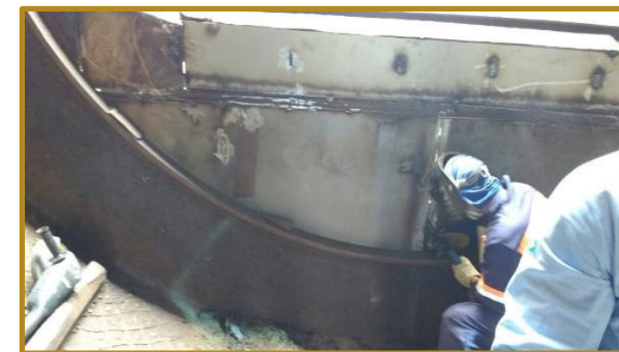
Soldagem de trincas na entrada do Tambor
