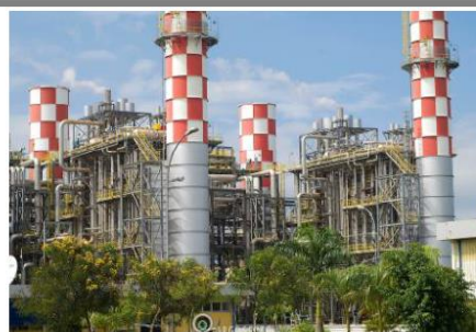
EDF Norte Fluminense Macaé / RJ
