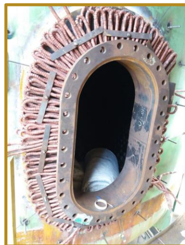
Montagem das Resistências na Janela de Inspeção
