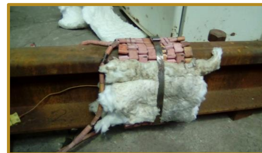
Montagem de Resistências Elétricas e Isolamento Térmico
