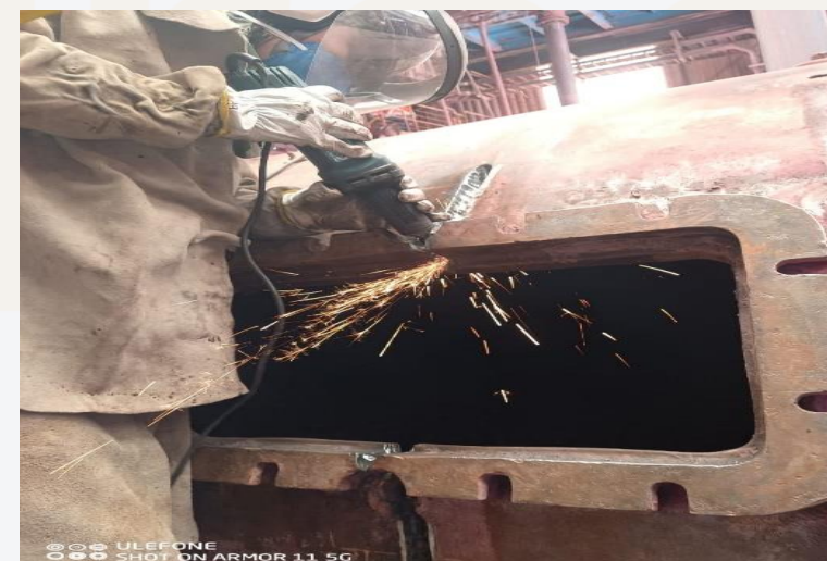
Obra Nexa Resources
