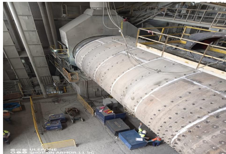
Obra CSN Cimentos
