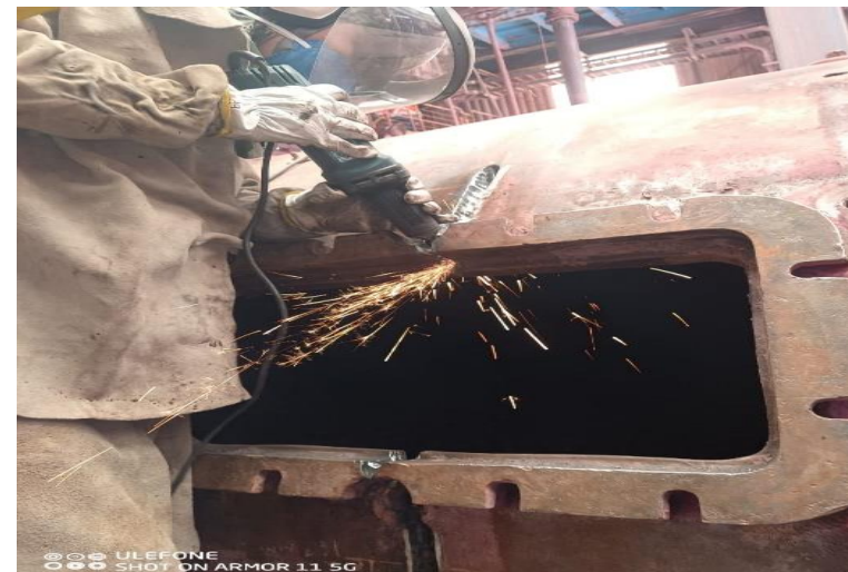
Obra Nexa Resources
