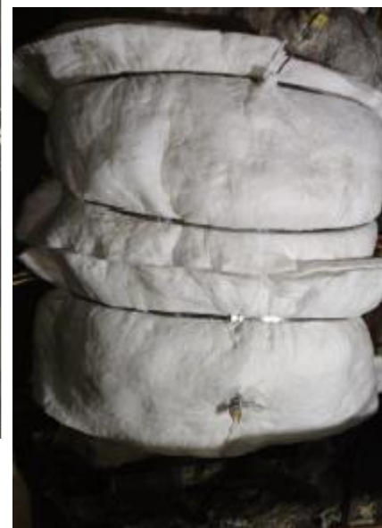
Pós-aquecimento da solda acabada
