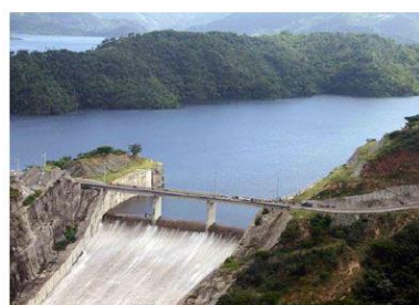
Central Hidroeléctrica de Monción República Dominicana
