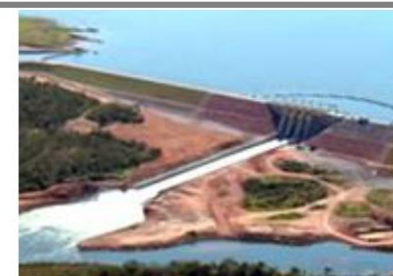
Tractebel - UHE Ponte de Pedra Campinápolis / MT
