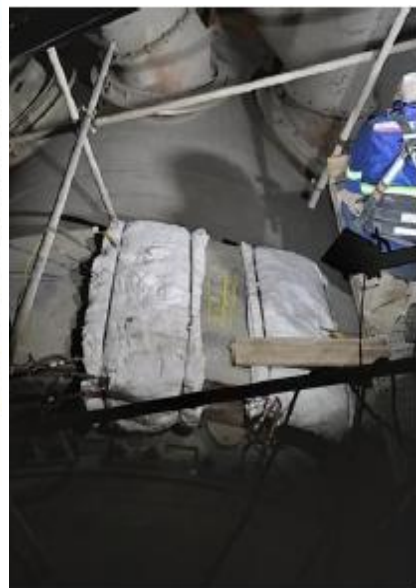
Vista da montagem do sistema de aquecimento
