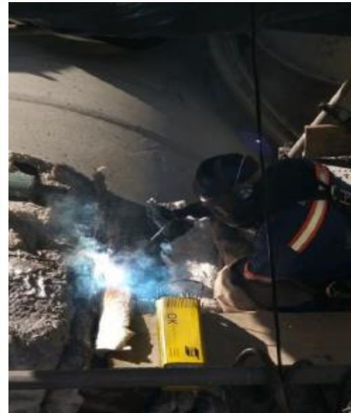
Vista da soldagem da trinca conforme procedimento
