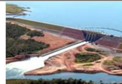
Tractebel - UHE Ponte de Pedra Campinápolis / MT
