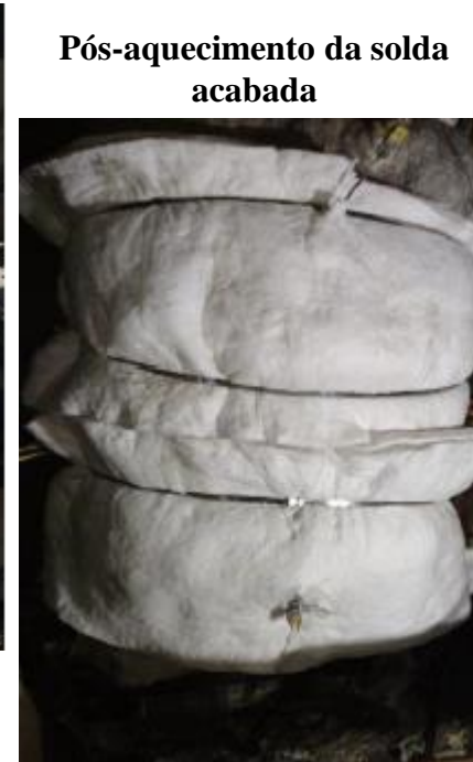
Vista da soldagem da trinca conforme procedimento
