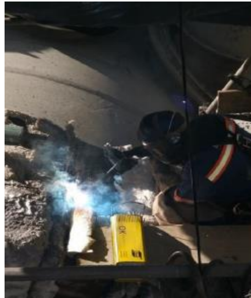
Vista da soldagem da trinca conforme procedimento
