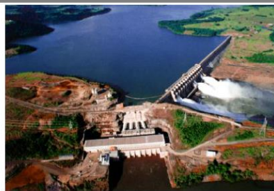
Copel - Usina Gov. José Richa Cap. Leônidas Marques / PR
