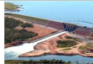
Tractebel - UHE Ponte de Pedra Campinápolis / MT
