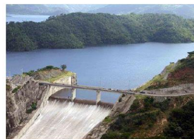
Central Hidroeléctrica de Monción República Dominicana
