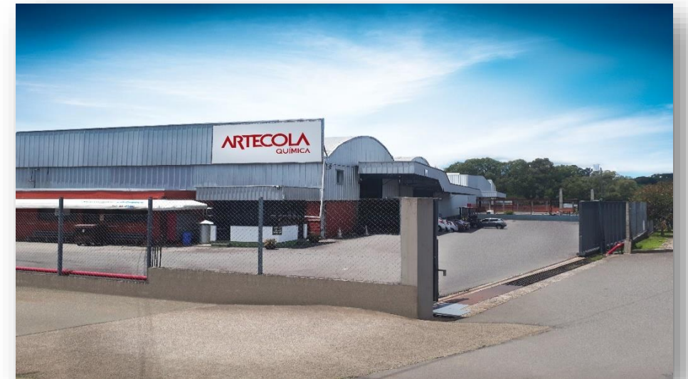
Artecologia Extrusão localizada em Caxias do Sul/RS.
