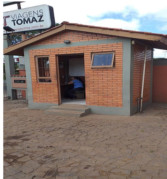
Controle de Tráfego
