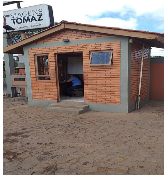
Controle de Tráfego
