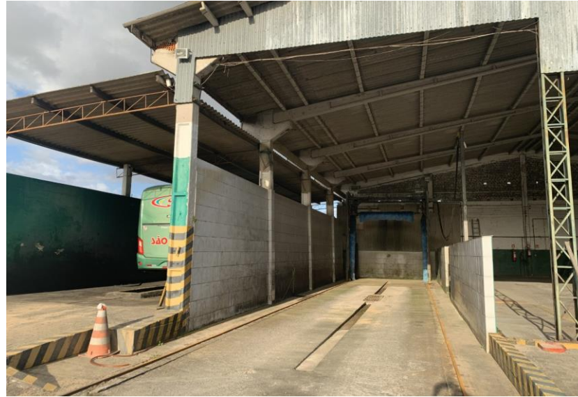
Rampa de Lavagem
