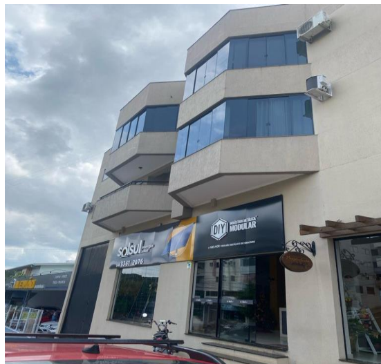
Fachada prédio - Matriz
