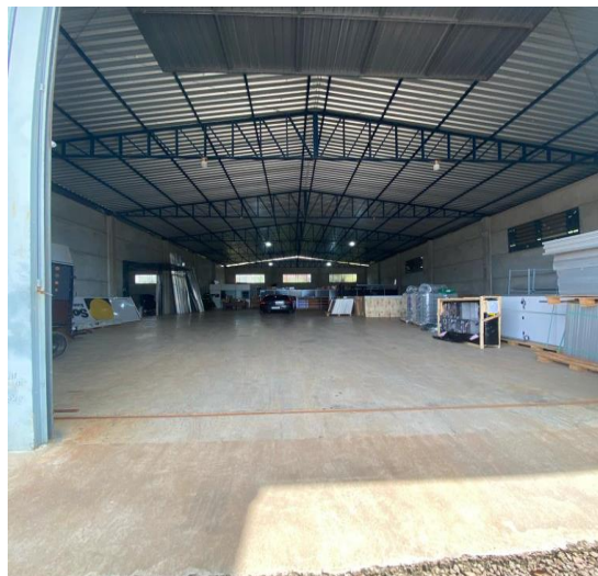
Interior pavilhão - Matriz
