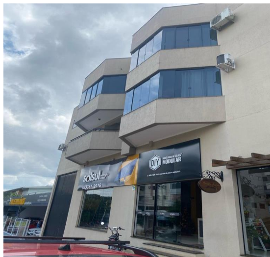
Fachada prédio - Matriz
