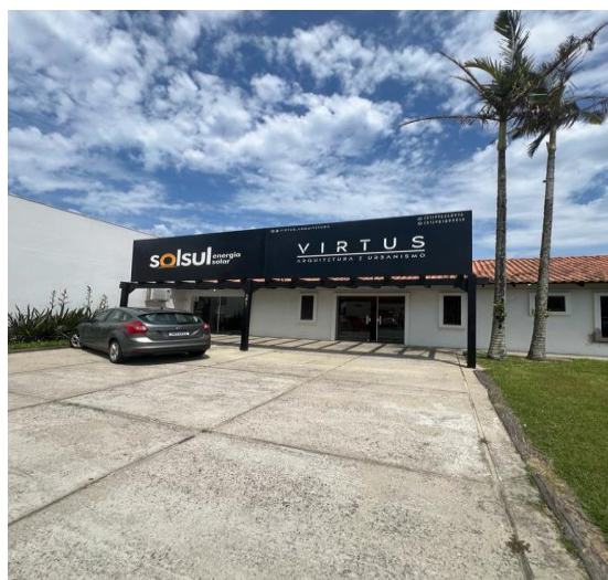
Fachada prédio - Filial Xangrilá
