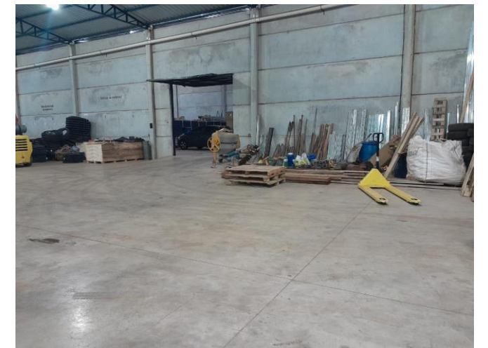
Pavilhão 2 - Armaz. de Ferramentas e Outros
