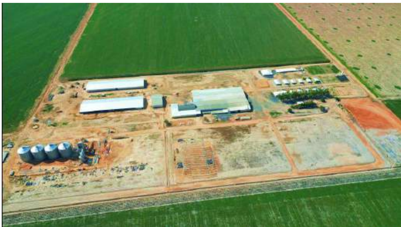
FAZENDA CURITIBA – BA – UBS – INCRUSTADORA, MÁQUINAS E SILOS
