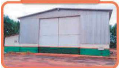
CASA DE MÁQUINAS
