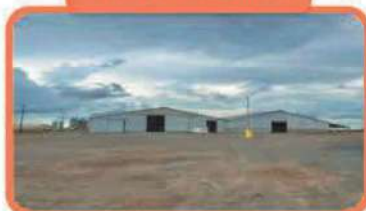
CASA DE MÁQUINAS
