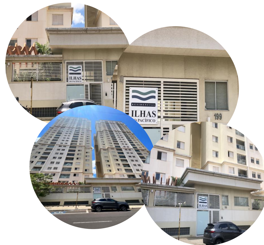
Figura 2 – Sede e Obras em execução
