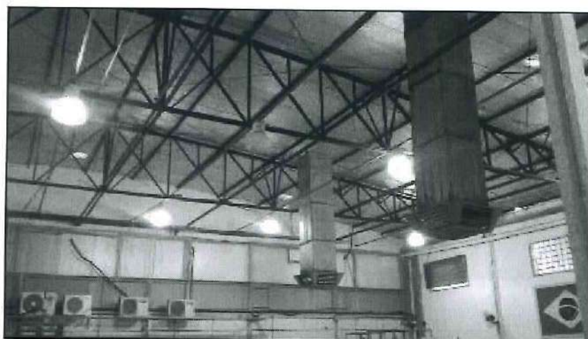
AREA PRODUTIVA – DETALHE DA COBERTURA
