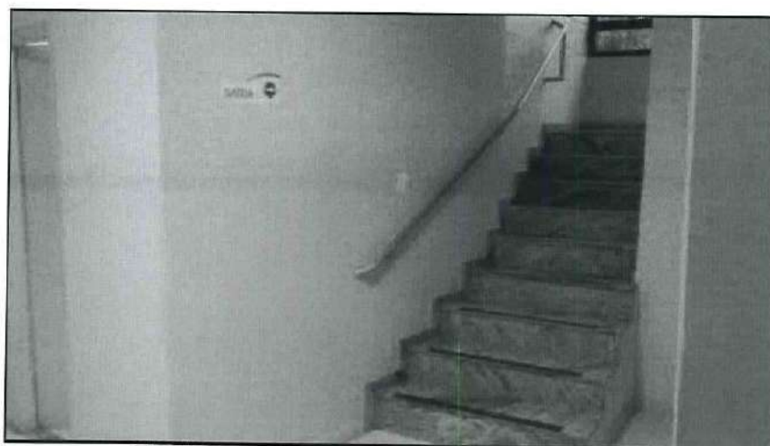
ESCADA DE ACESSO AO PAVIMENTO SUPERIOR
