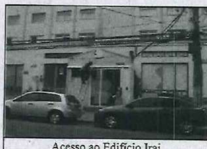
Acesso ao Edifício Irai
