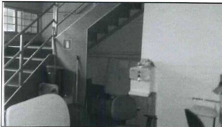
ESCADA DE ACESSO PARA O SEGUNDO PAVIMENTO SUPERIOR
