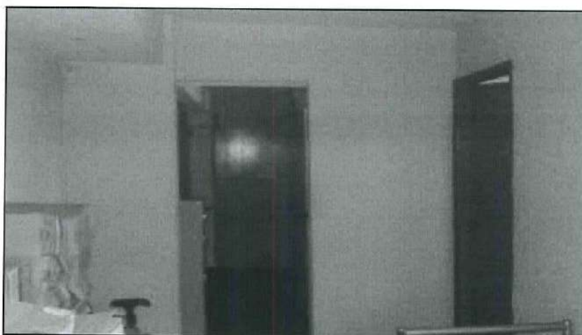
DEPOSITO E ARQUIVO MORTO - SEGUNDO PAVIMENTO SUPERIOR
