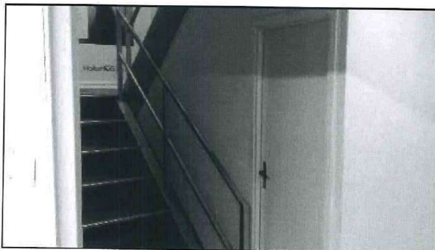
ESCADA DE ACESSO PARA O PRIMEIRO PAVIMENTO SUPERIOR
