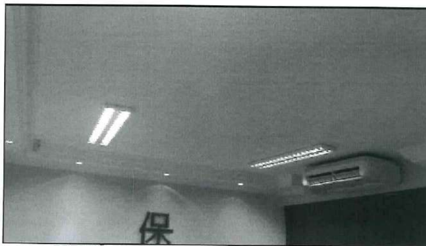
PRESIDENCIA – PISO SUPERIOR – DETALHE DO FORRO
