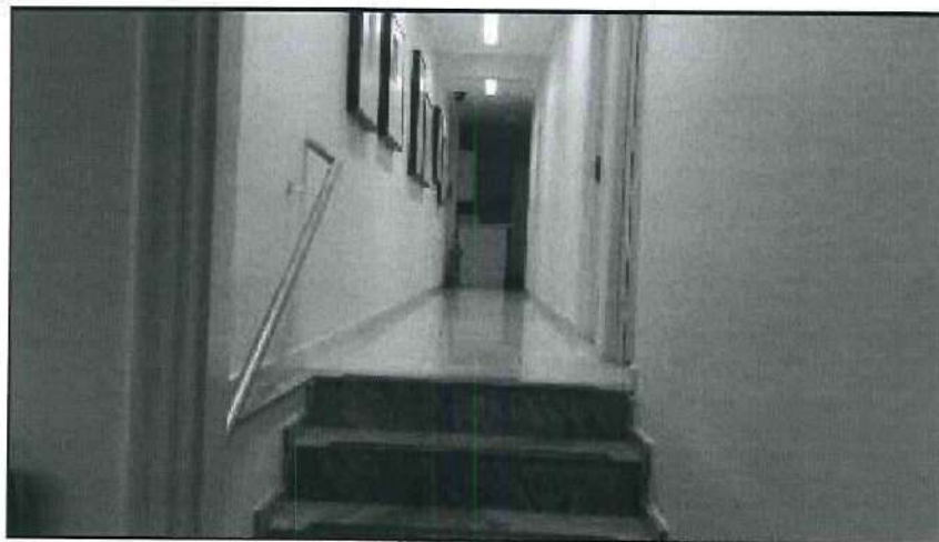
CORREDOR DE CIRCULAÇÃO – PISO SUPERIOR
