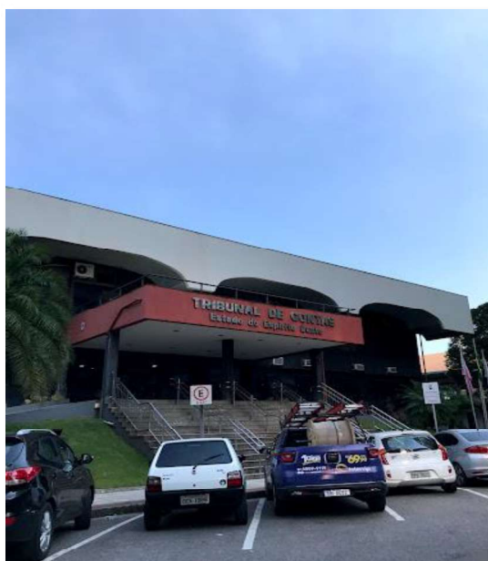
Reforma e ampliação do prédio do Tribunal de Contas do Espírito Santo/ES
