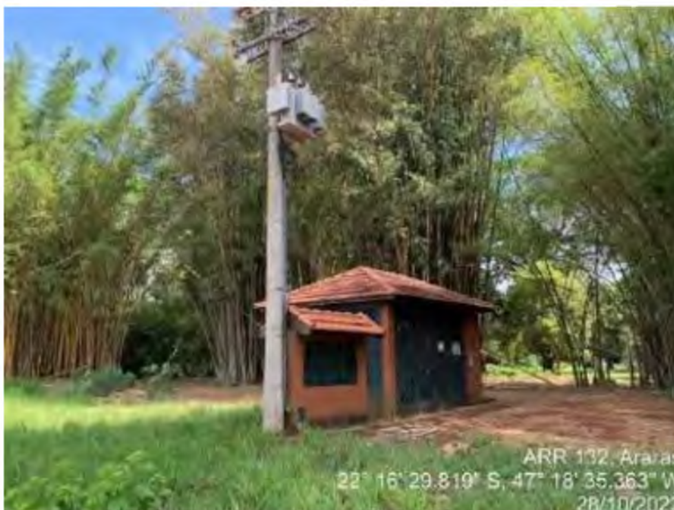
Fotografia 26 – Casa do gerador
