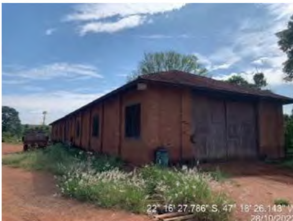
Fotografia 04 – Barracão dos tratores
