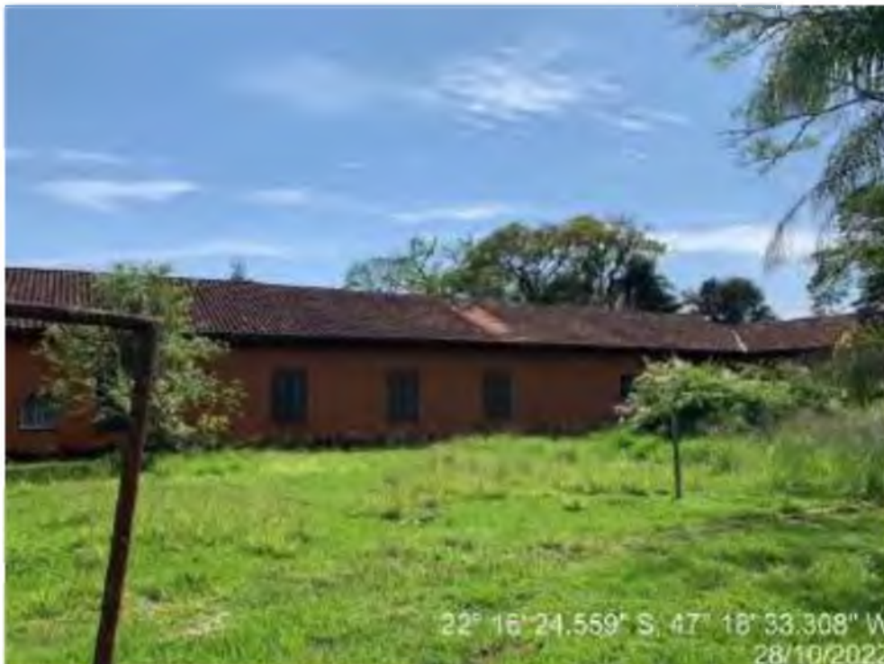
Fotografia 29 – Vista interna da casa de hóspedes
