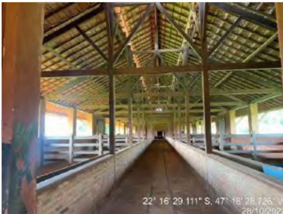
Fotografia 09 – Vista interna do bezerreiro
