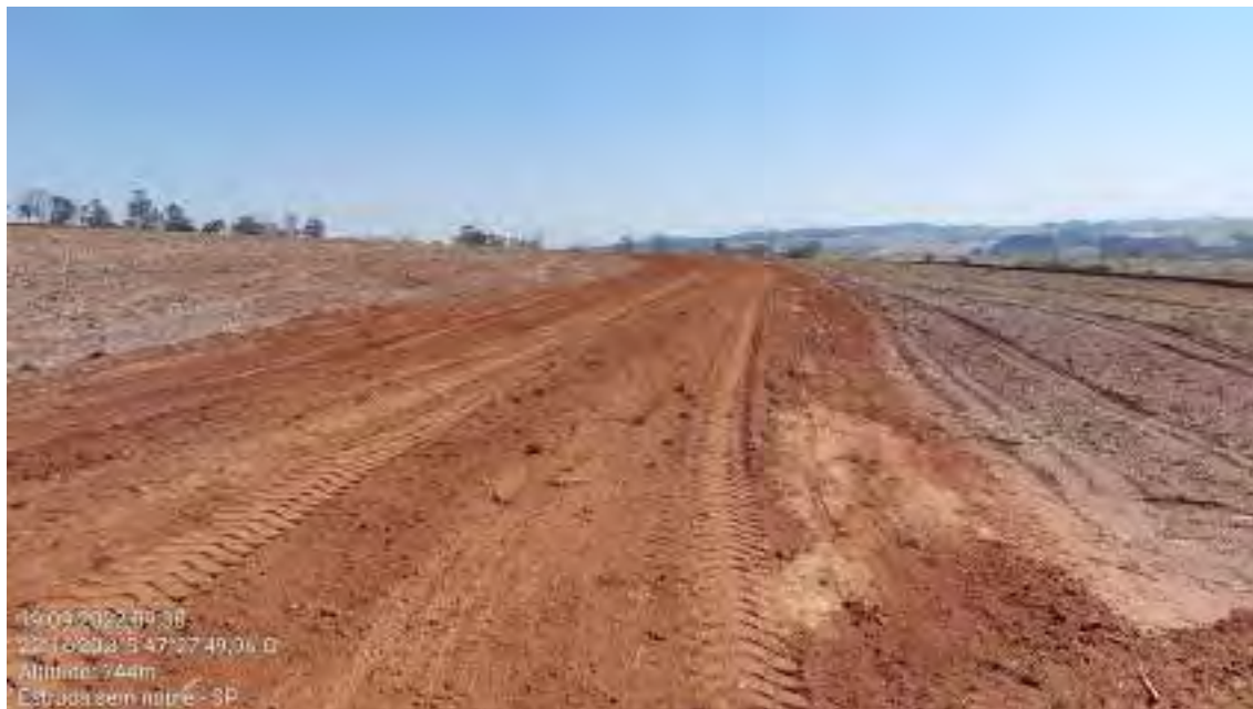
Fotografia 5 – Construção de terraço em área de reforma de cana. Solo de textura média e relevo suave ondulado.
