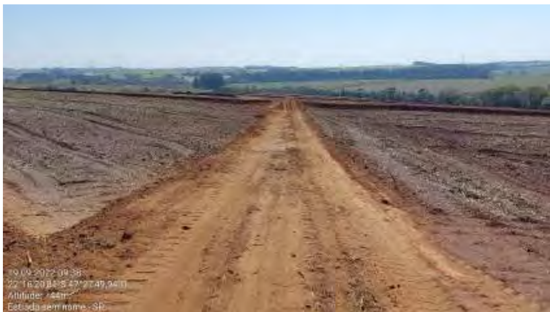
Fotografia 7 – Estrada interna em manutenção em área de reforma. Bom trabalho de conservação do solo, com terraços e prevenção contra erosão nas estradas.
