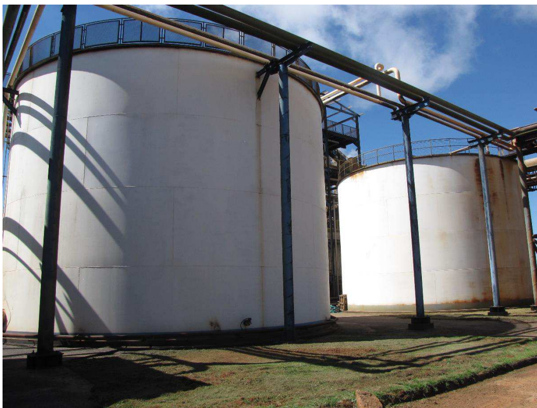
Foto 21 – Tanques reservatórios de Álcool
