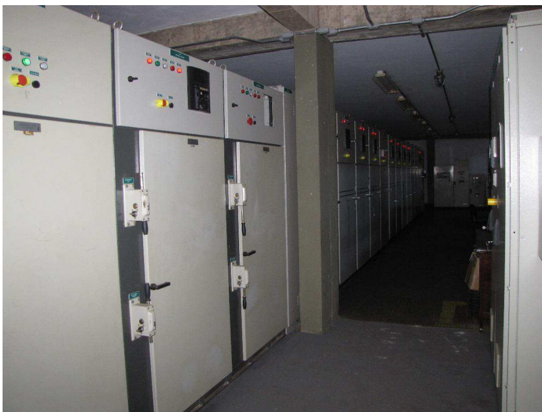
Foto 18 – Painel Grupo Gerador de Energia Elétrica
