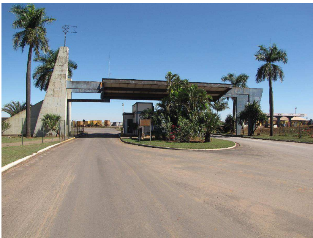
Foto 3 – Guarita entrada Usina
