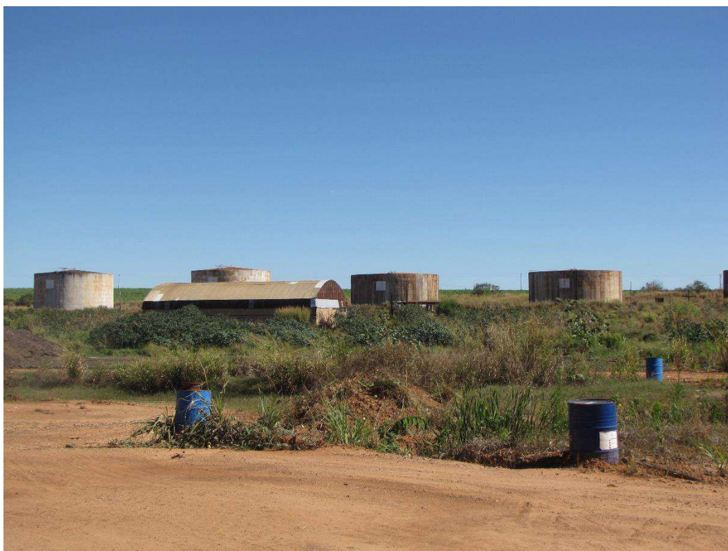
Foto 23 – Tanques de estocagem de álcool
