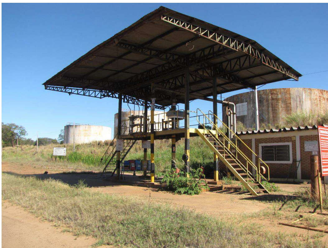
Foto 25 – Área abastecimento caminhões tanque
