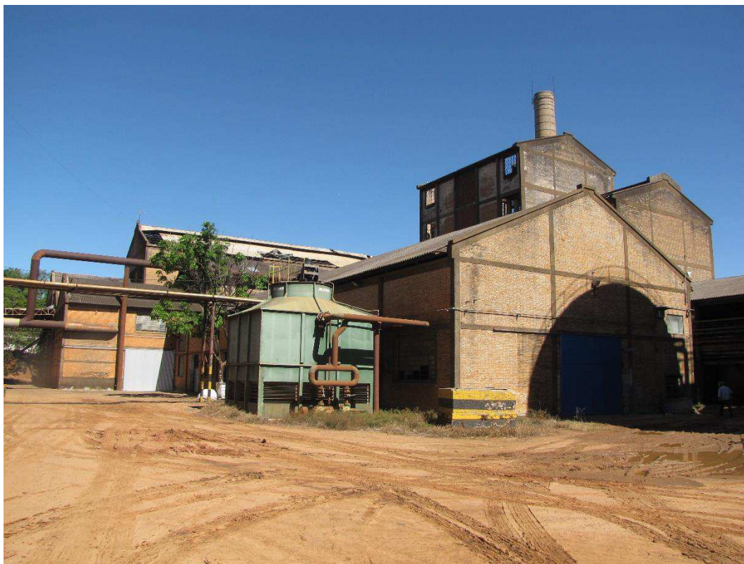
Foto 21 – Vista de traz da usina
