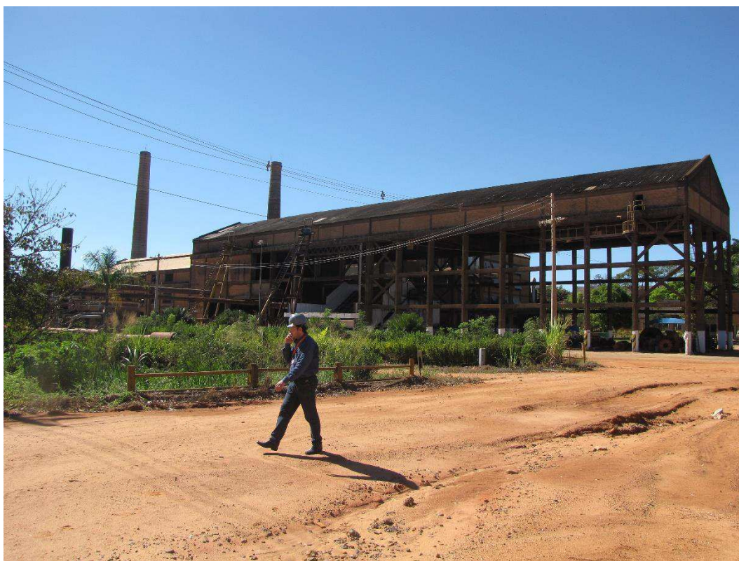
Foto 31 – Vista lateral Usina
